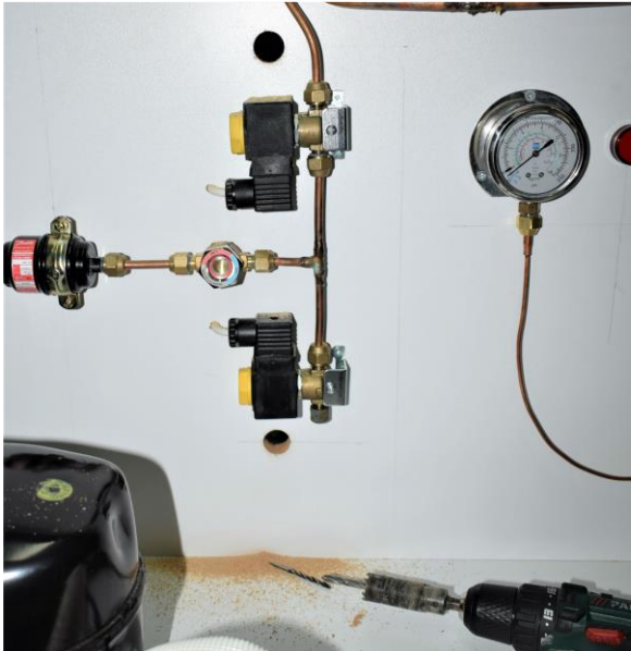
Εικόνα 3.32: Τρύπες για την τοποθέτηση των LED
