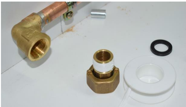
Εικόνα 4.9: Τοποθέτηση Τεφλόν Στεγανοποίησης
