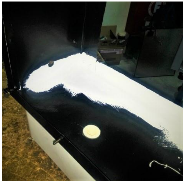
Εικόνα 2.61: Μόνωση του Πάτου για Στεγανοποίηση
