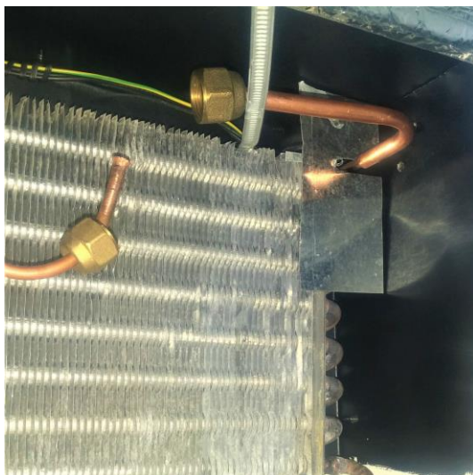
Εικόνα 2.73: Τοποθέτηση Κομματιού Σωλήνας Προέκτασης
