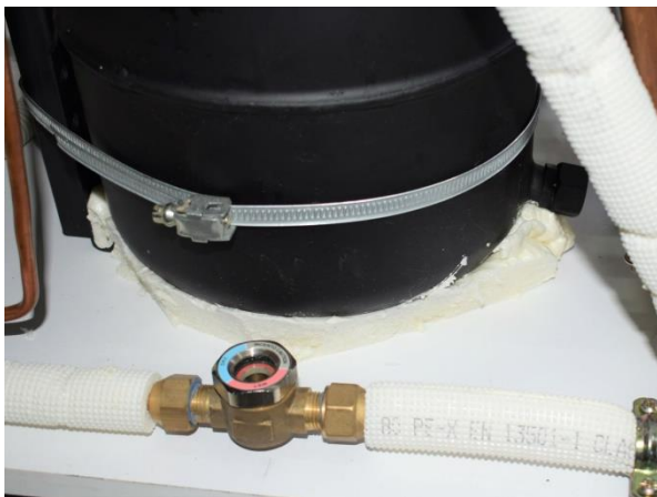
Εικόνα 2.44: Πολυουρεθάνη στον Πάτο του Δοχείου
