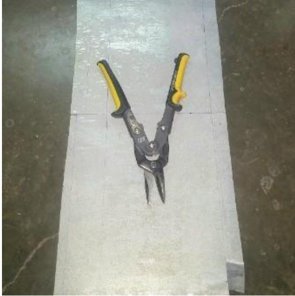
Εικόνα 2.58: Κοπή Λαμαρίνας με Ειδικό Ψαλίδι
