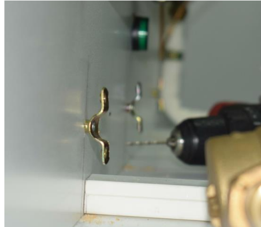
Εικόνα 4.8: Τοποθέτηση Στηριγμάτων
