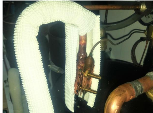
Εικόνα 2.43: Βολβός Τοποθετημένος πριν την Μόνωση
