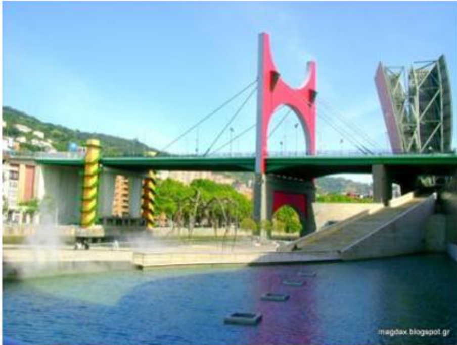
Εικόνα 23 - Γέφυρα La Salve Bridge
