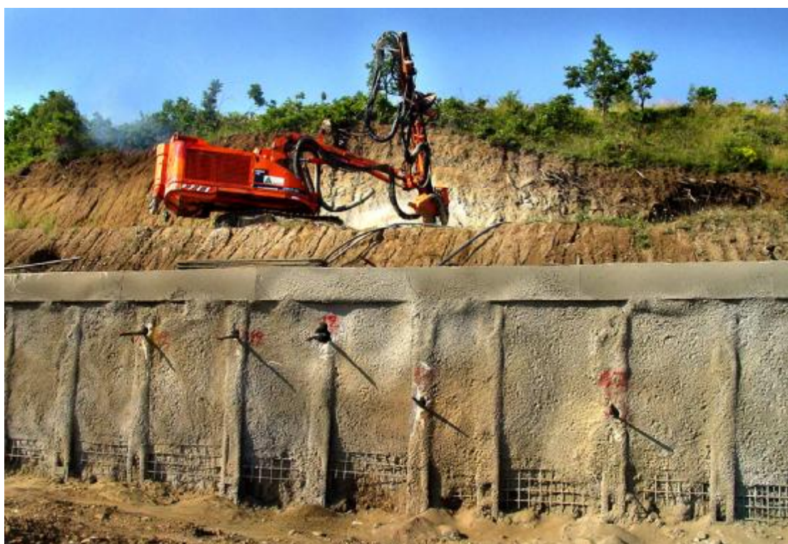
Σχήμα 3: Αντιστήριξη τοιχείου με προεντεταμένα αγκύρια συρματόσχοινου TTM ( http://www.elebor.gr/categories.asp?id=275 )
