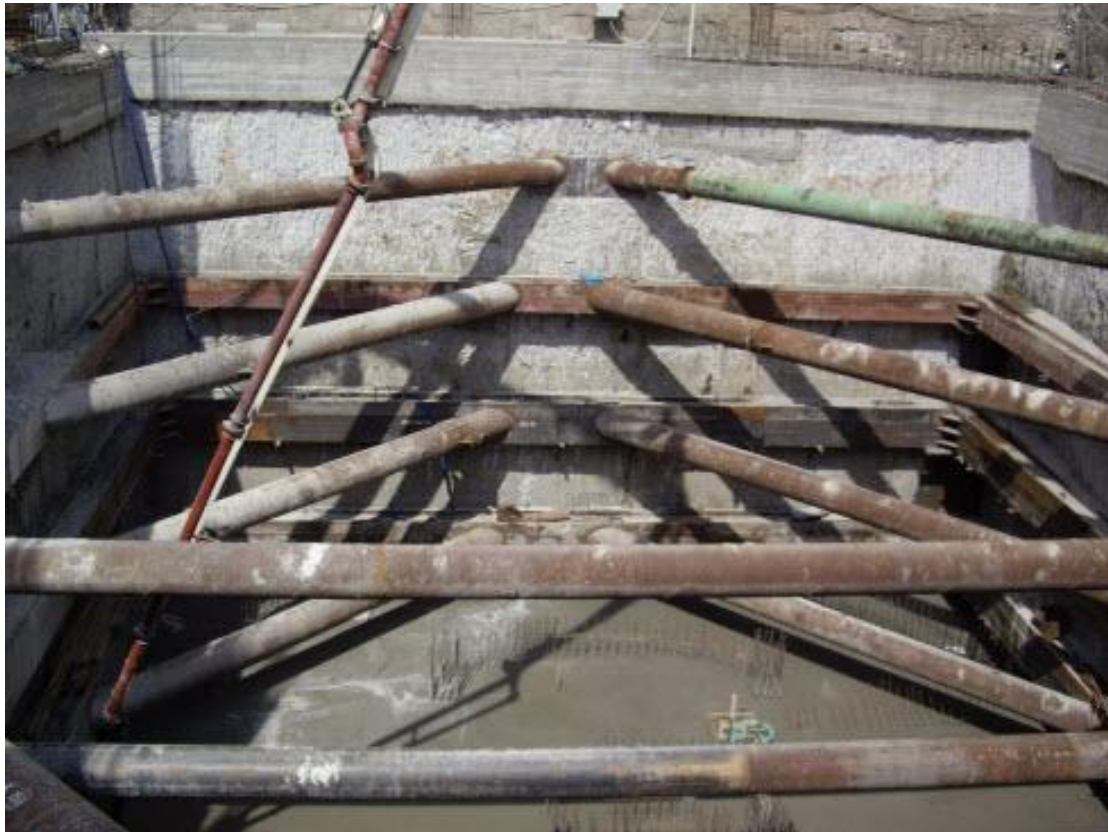
Σχήμα 8: Διαφραγματικοί Τοίχοι: Φάση Εκσκαφής. ( http://ecomu.users.uth.gr/6aa.htm )
