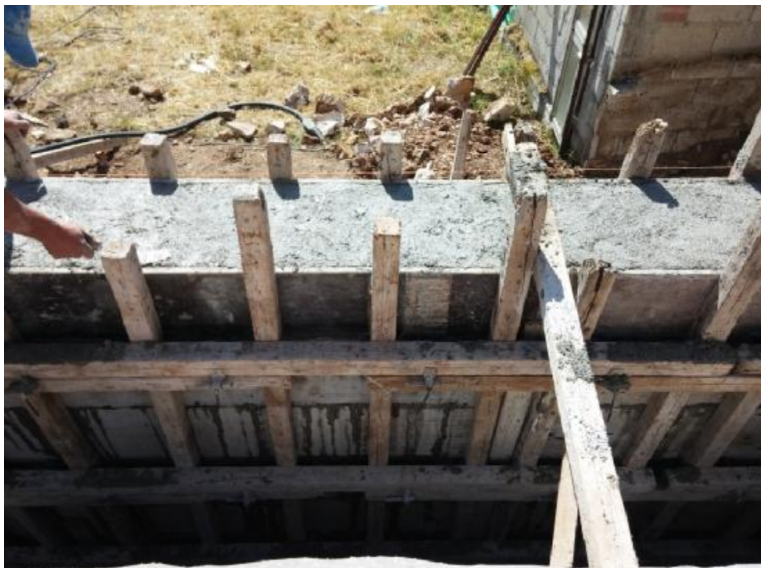
Σχήμα 7: Κατασκευή τοίχου αντιστήριξης από οπλισμένο σκυρόδεμα ( http://www.zampakolas.gr/projects-erga/ergo2/ ).
