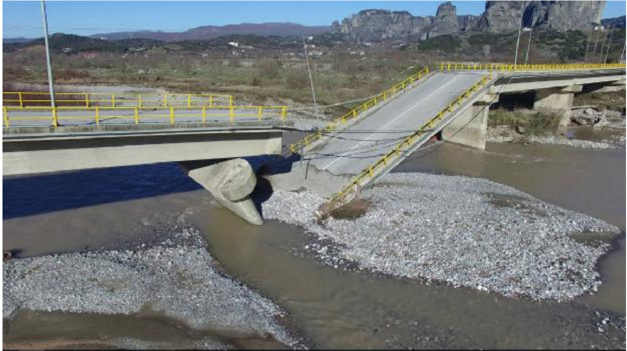
Εικόνα 9: Κατάρρευση της γέφυρας της Διάβας στη Θράκη ( Διαδίκτυο 8 )
