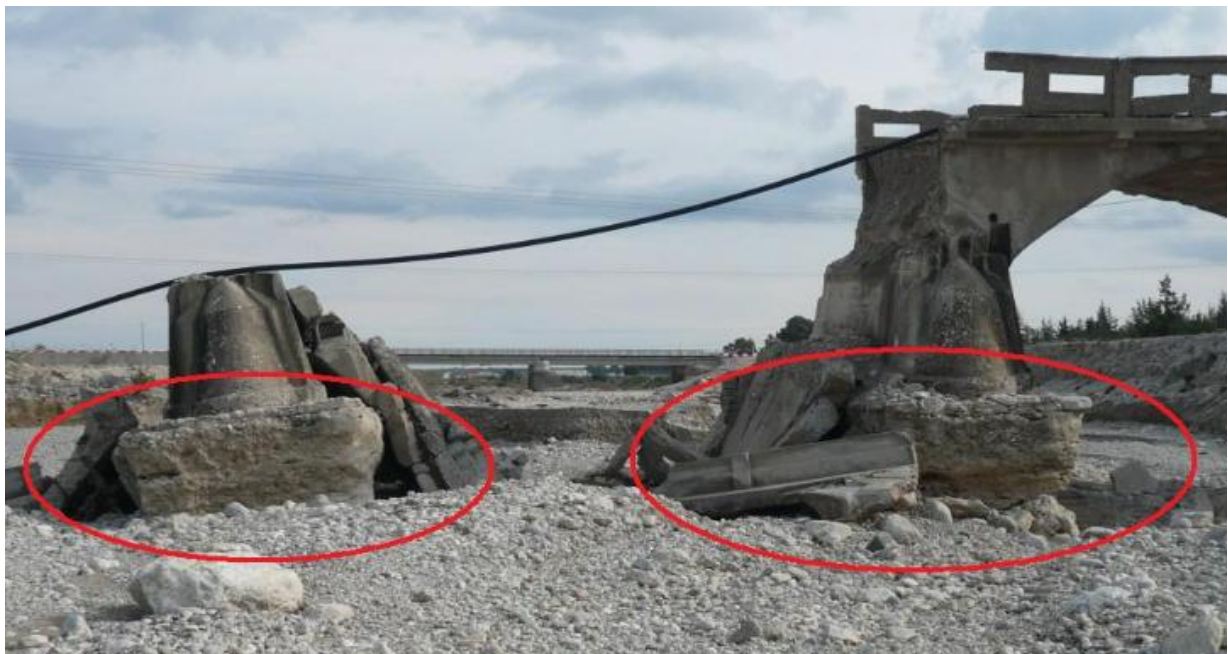
Εικόνα 10: Κατάρρευση της γέφυρας του ποταμού Λουτάνη ( Διαδίκτυο 9 )
