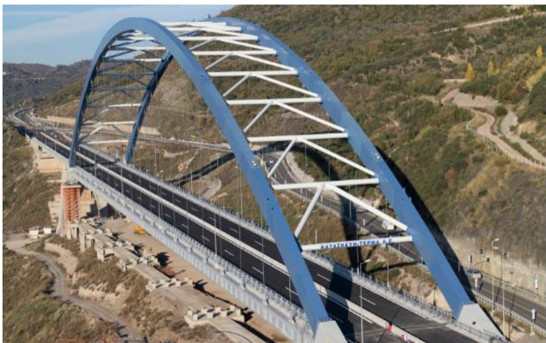
Εικόνα 2: Τοξοτή γέφυρα Τσακώνας ( Διαδίκτυο 2 )
