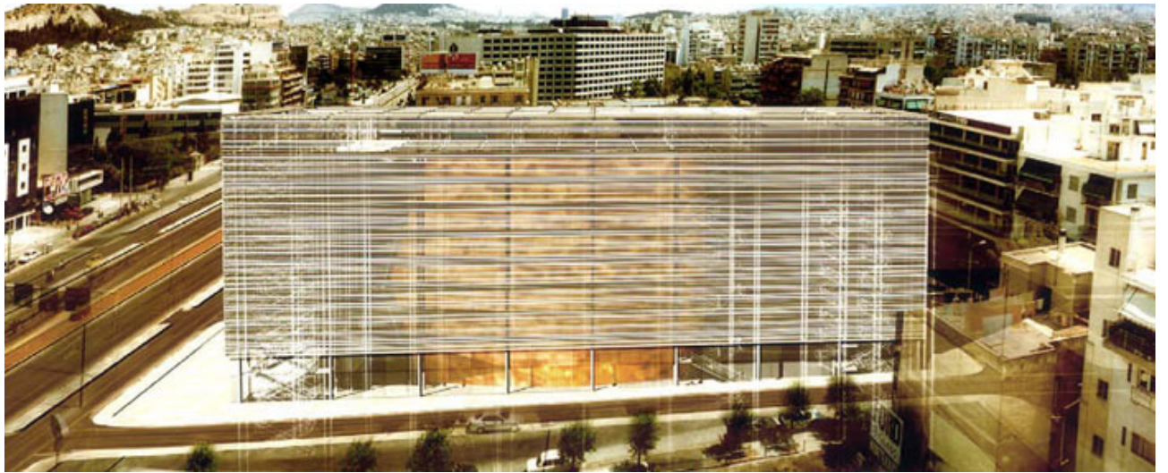
Εικόνα 8: Εξωτερική άποψη της στέγης γραμμάτων και τεχνών
