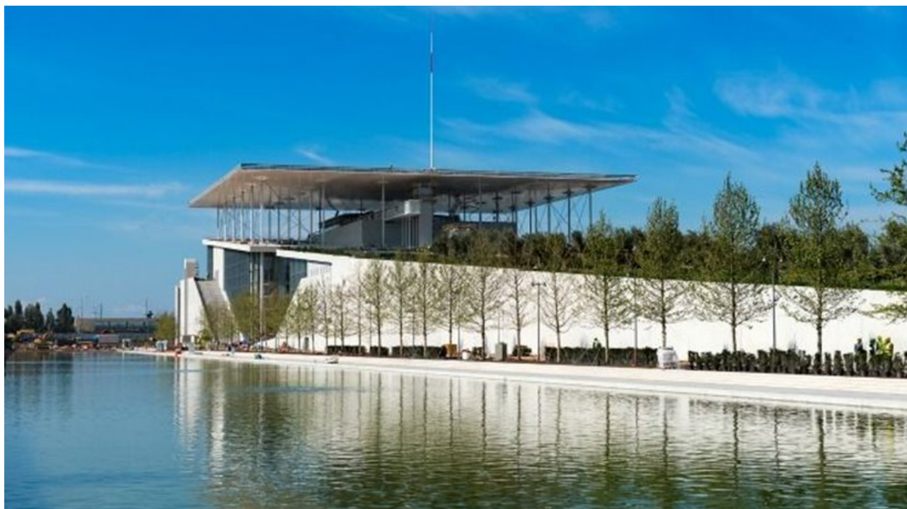
Εικόνα 10: Εξωτερική άποψη του ΚΠΙΧΝ
