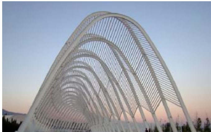
Εικόνα 25: Η στοά των Εθνών-Ολυμπιακό Στάδιο. Πηγή: www.fortunegreece.com/
