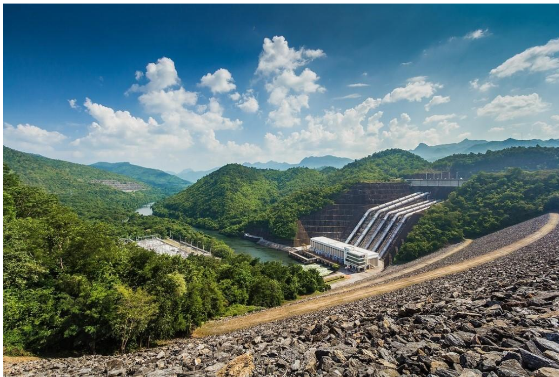
Το φράγμα Srinagarind σήμερα
