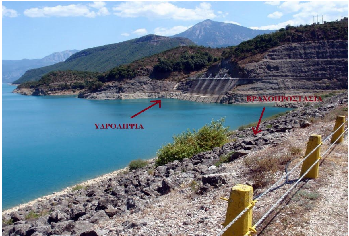
Ανάντη πλευρά φράγματος από στέψη
