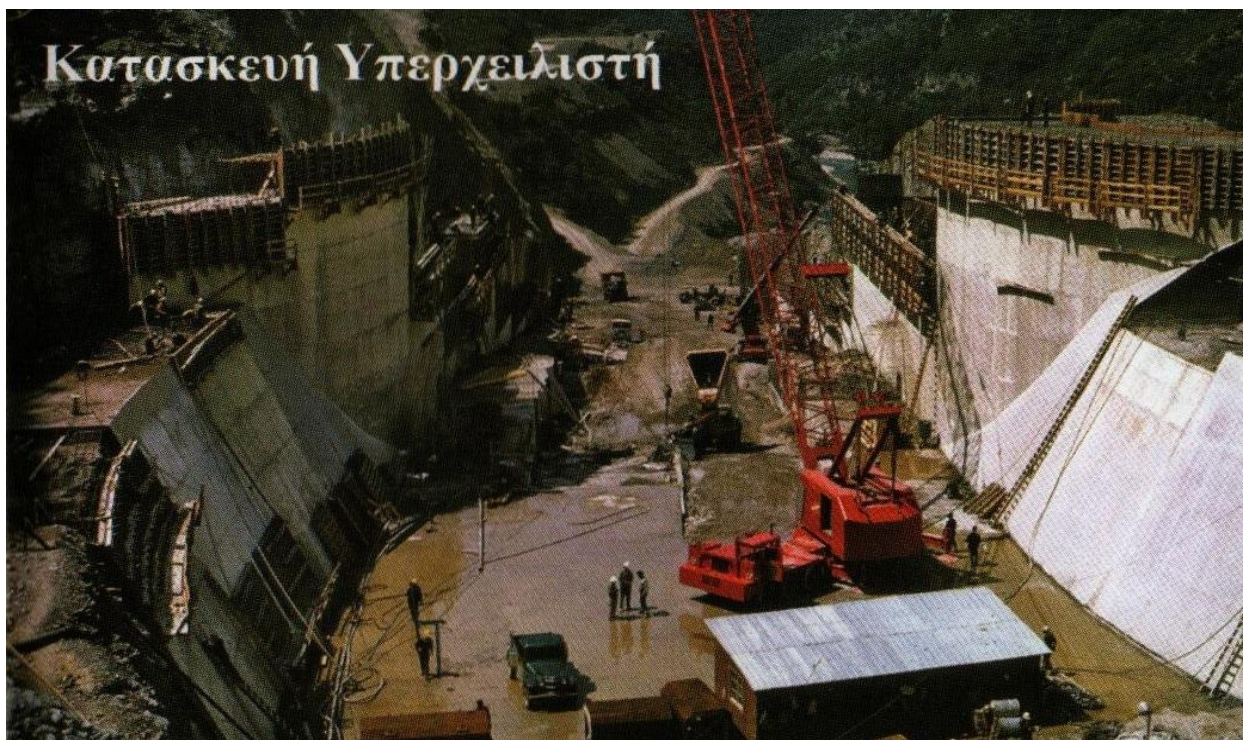
Κατασκευή υπερχειλιστή
