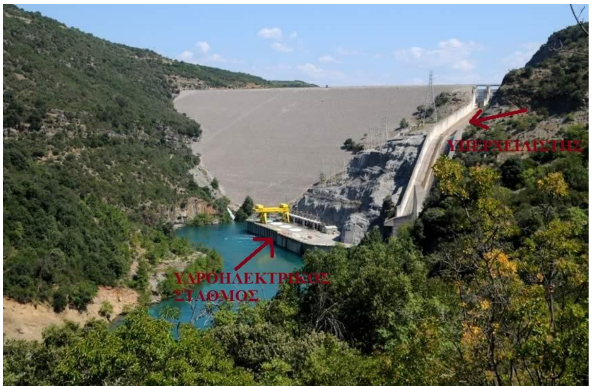
Κατάντη πλευρά φράγματος
