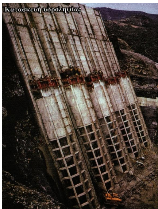
Κατασκευή Υδροληψίας
