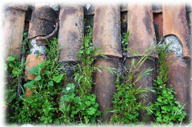
Εικόνα 31. Παθολογία κεραμιδιών.
