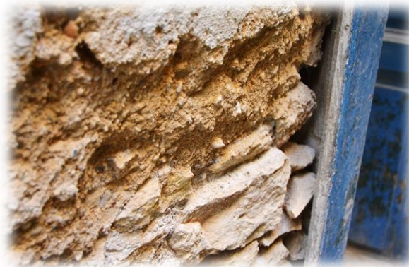
Εικόνα 28. Φθορά τοιχοποιίας.
