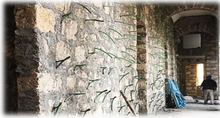
Εικόνα 35. Παράδειγμα εφαρμογής ενεμάτων.
