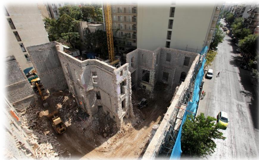
Εικόνα 32. Παράδειγμα Εργοταξίου, κτίριο Βίλα Αμαλίας.
