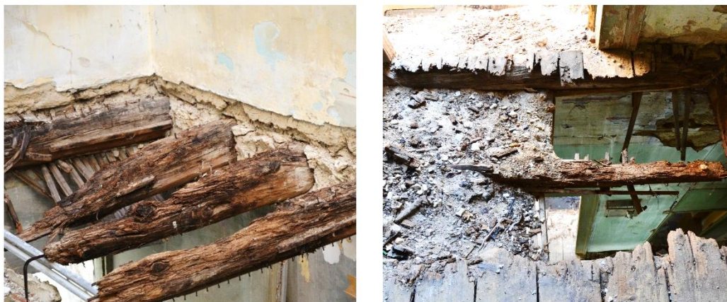
Εικόνα 30. Φθορά δοκών.
