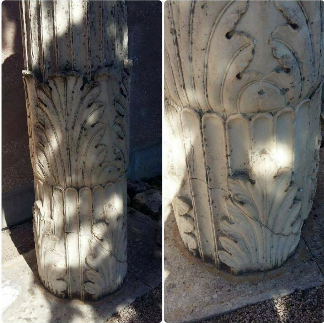
Εικόνα 5.3.1.α. Κολώνα Κορινθιακού ρυθμού με ρωγμή στο κάτω μέρος από σεισμό.
