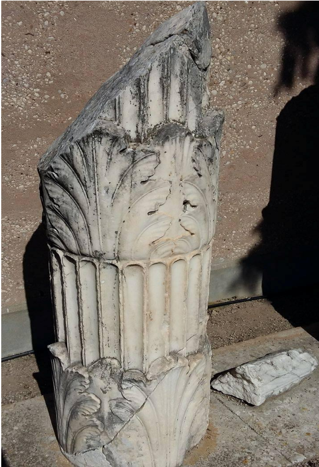
Εικόνα 5.3.1.γ. Και αυτή η κολώνα είναι Κορινθιακού ρυθμού και έχει υποστεί ζημιά από κάποιον αρχαίο σεισμό.
