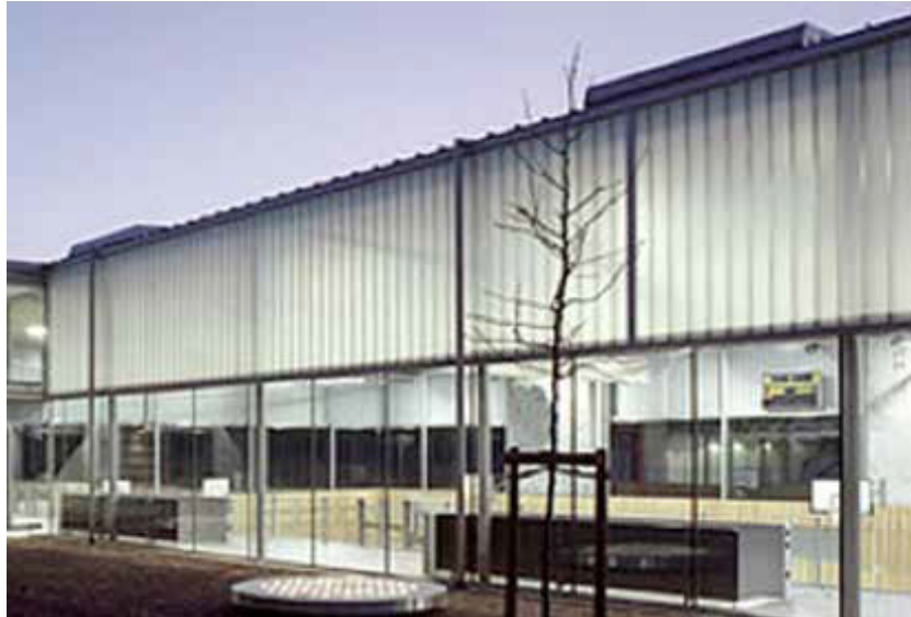
Εικόνα 3.18 Κτίριο με χρήση διαφανών μονωτικών υλικών
