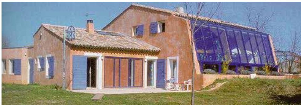
Εικόνα 3.13 Θερμοκήπιο προσαρτημένο σε κτίριο
