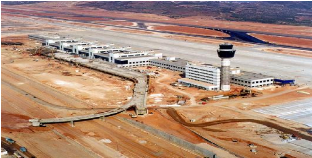
Φωτογραφία 4.1.1: Κατασκευή αεροδρομίου «Ελευθέριος Βενιζέλος»
