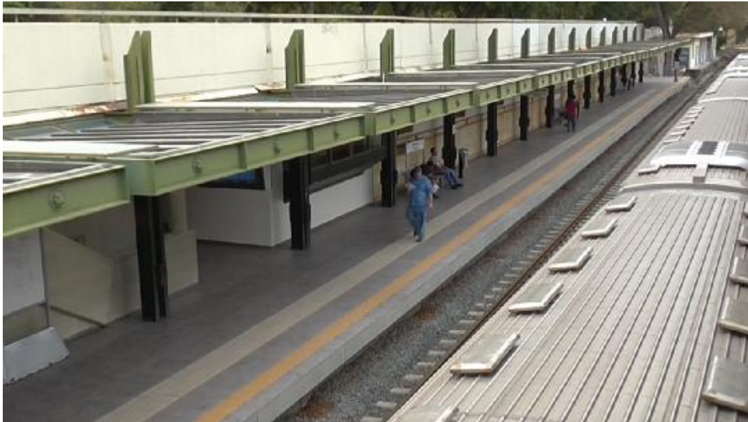
3.33 Γενικό σταθμού ΗΣΑΠ
