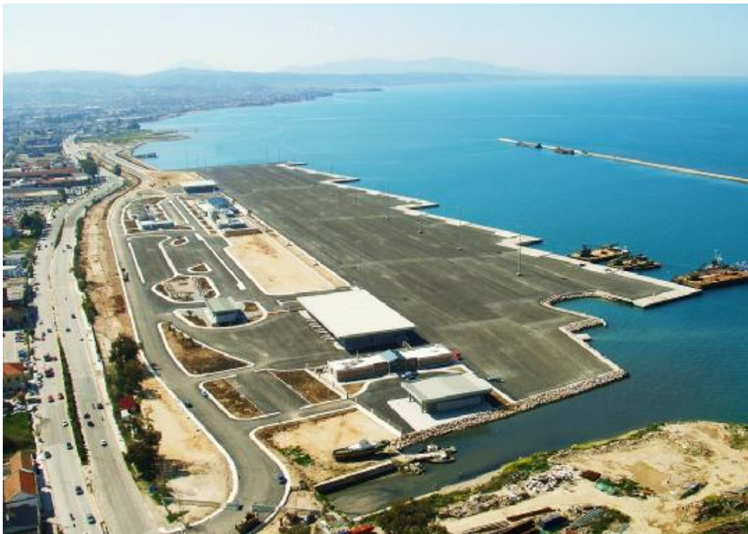
Εικόνα 3. Τμήμα του νέου λιμένα Πατρών
