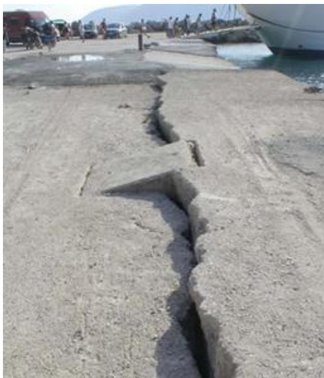
Εικόνα 7. Καθίζηση του επιχώματος ίση με 20cm πίσω από κρηπιδότοιχο στο λιμάνι της Βασιλικής στον σεισμό της Λευκάδας.
