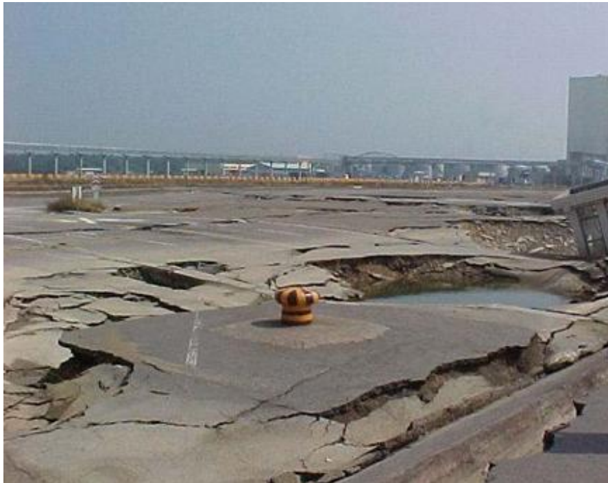
Εικόνα 4.4 Βλάβες στις επιστρώσεις των προκουμαίων κατά την διάρκεια του σεισμού του Chi-Chi.
