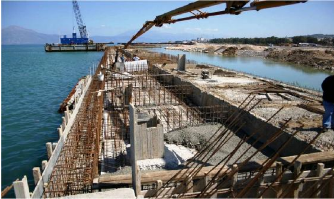
Εικόνα 2. Διαδικασία κατασκευής κρηπιδότοιχου σε τμήμα Νέου λιμένα Πάτρας
