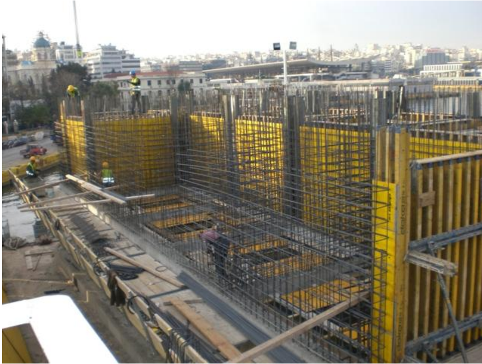
Εικόνα 5. Κατά την κατασκευή του κρηπιδότοιχου στον Άγιο Νικόλα Πειραιά.
