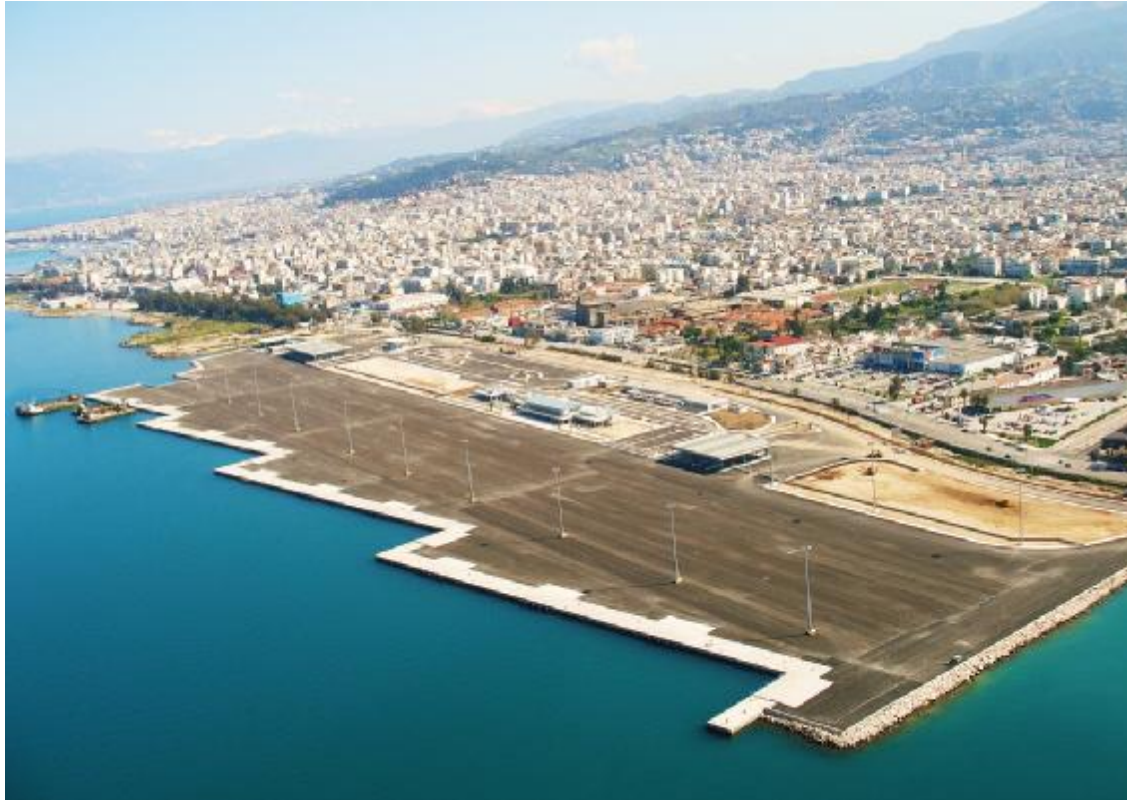
Εικόνα 4. Τμήμα του νέου λιμένα Πατρών
