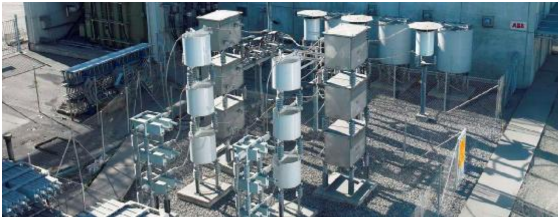
Εικόνα 25: Μονάδες SVC της εταιρείας ABB στη Φινλανδία
