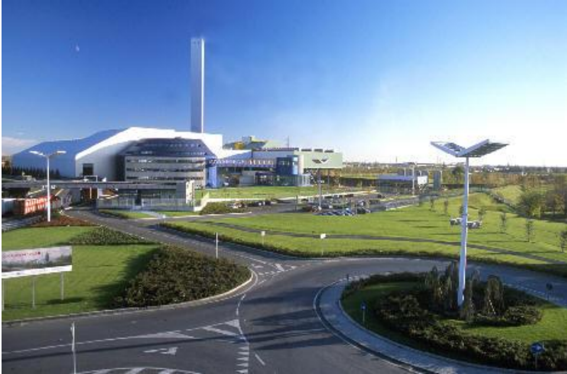
Εργοστάσιο παραγωγής ενέργειας, Μπρέσια.
