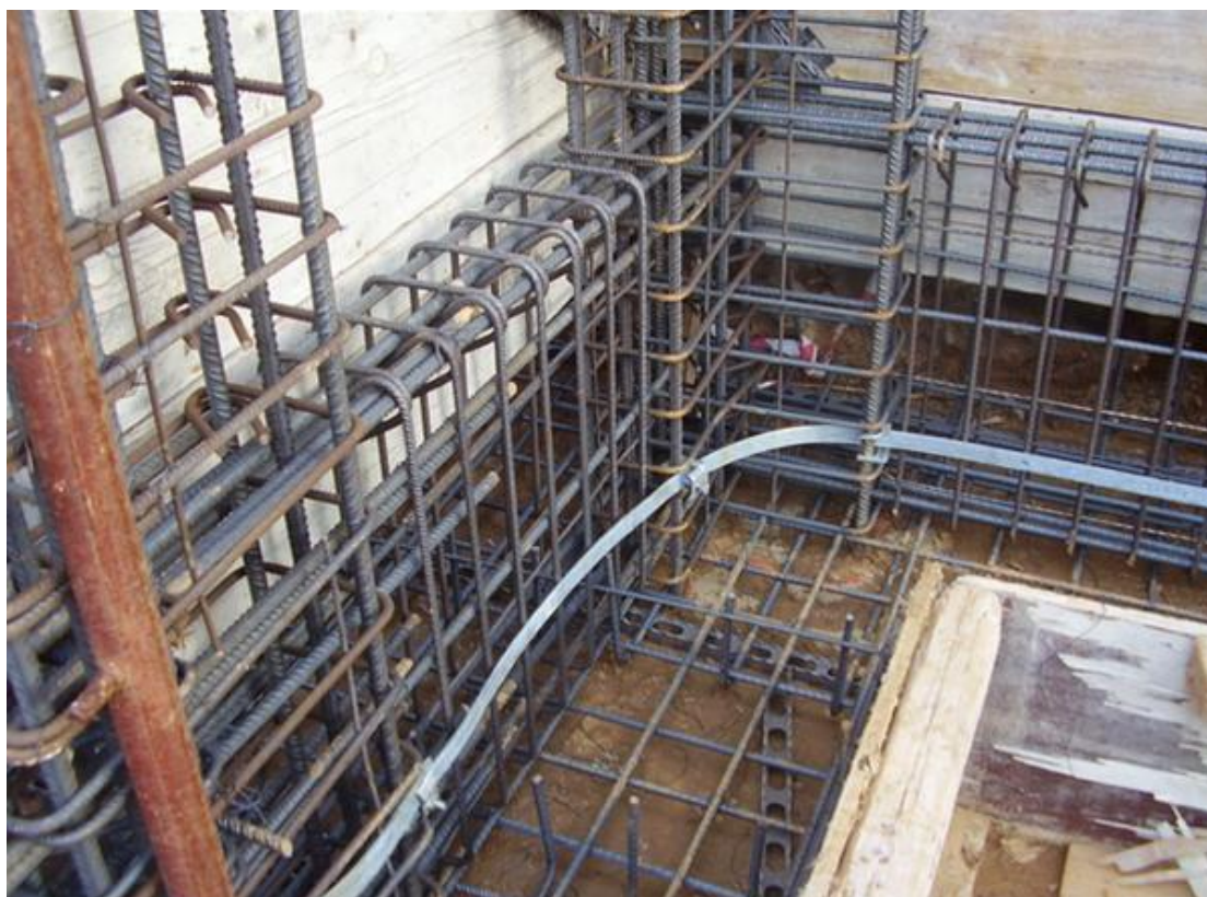
Εικόνα 4.1: Τοποθέτηση της περιμετρικής ταινίας γείωσης κατά τη θεμελίωση
