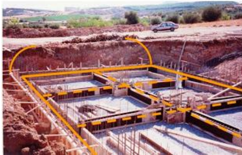
Εικόνα 4.4: Τοποθέτηση παραπάνω από μία ταινίες
