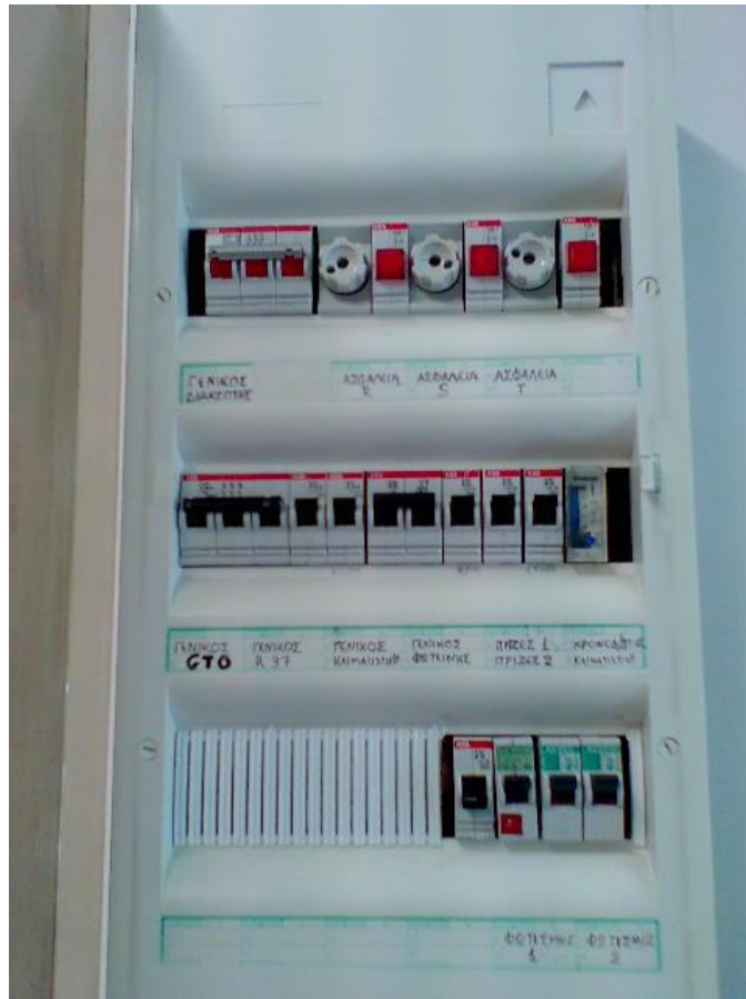
Εικόνα 0.2:Γενικός Πίνακας Διανομής
