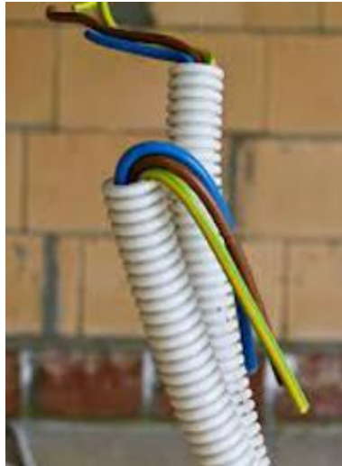
Εικόνα 3.3: Προστατευτικοί σωλήνες ηλεκτρολογικής εγκατάστασης
