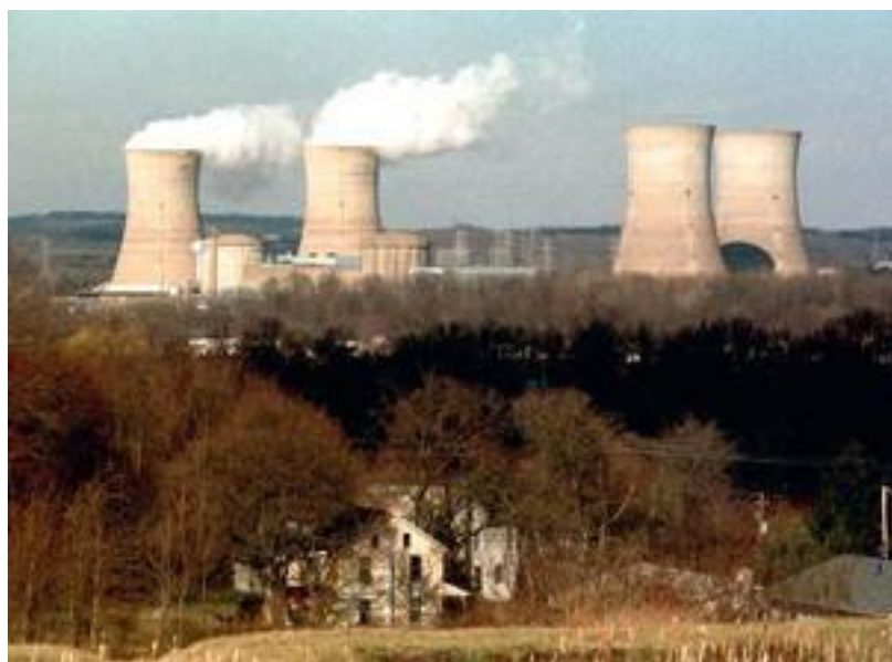
Εικόνα 39: Πυρηνικός σταθμός ενέργειας στο Κατενόμ της Γαλλίας. Μη ραδιενεργός ατμός εξέρχεται από τους ψυκτικούς πύργους
