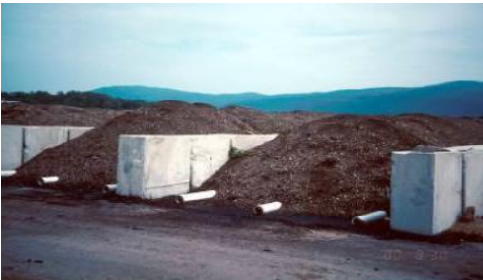
Εικόνα 5.4 : Ανοιχτό σύστημα κομποστοποίησης σε σειράδια με εξαναγκασμένο αερισμό με ή χωρίς μηχανική ανάδευση [Πηγή: Γάνος και συν., 2015]
