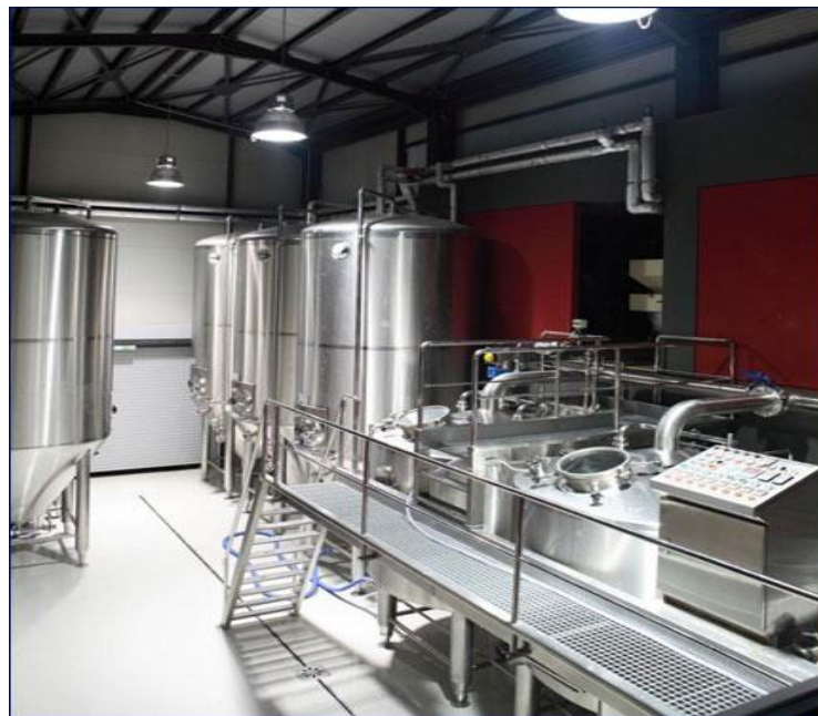
Εικόνα 3.8: Εξοπλισμός φιλτραρίσματος μύρας της εταιρίας Defranceschi [4].
