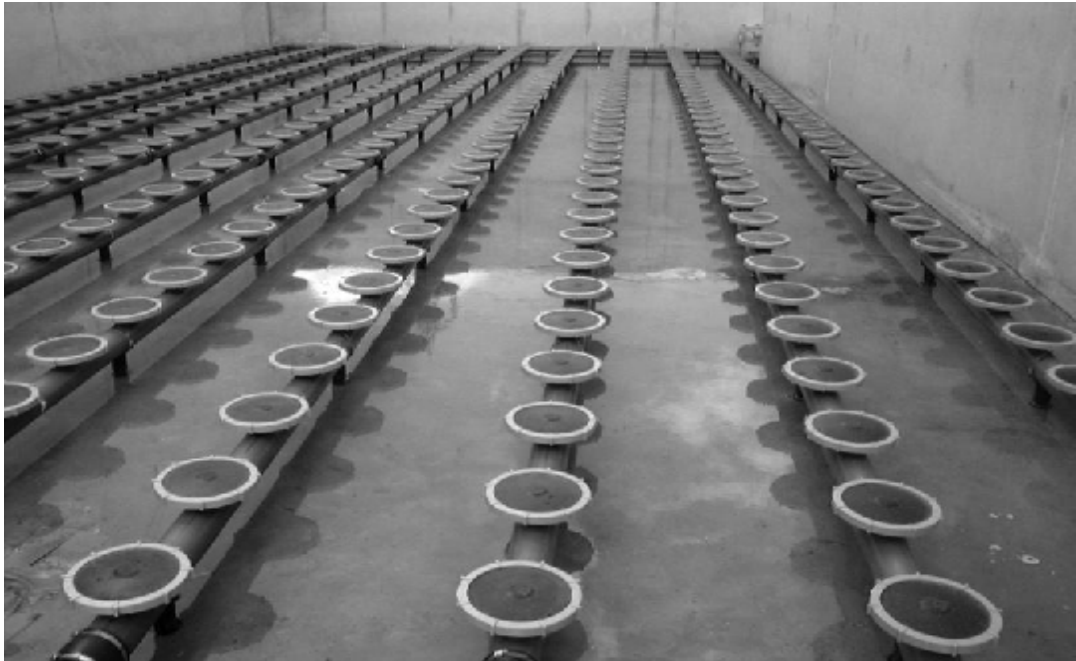
Εικόνα 4.1: Δεξαμενή αερισμού με πορώδεις διαχύτες [4].
