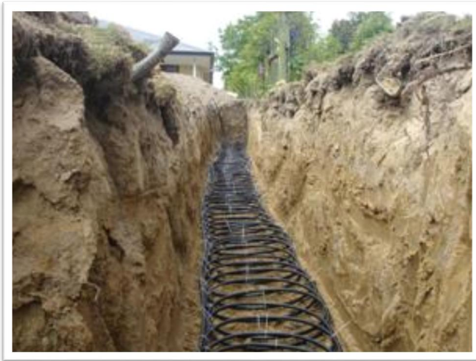
Εικόνα 29 : Οριζόντιο κλειστό κύκλωμα σπειροειδής μορφής.
