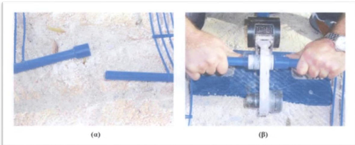
Εικόνα 28 :Τα οριζόντια πλέγματα του γήινου εναλλάκτη συνδέονται με τις σωληνώσεις του συλλέκτη με ειδικό μηχάνημα θερμοκόλλησης.
