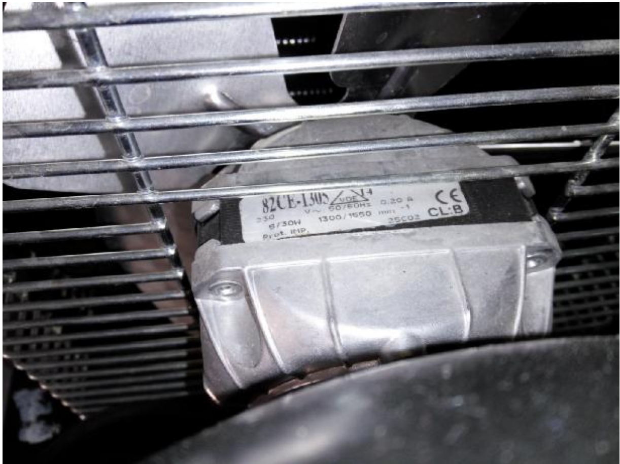
Σχήμα 59: Ανεμιστήρας του συμπυκνωτή
