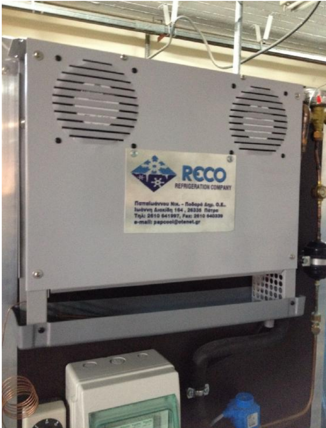
Σχήμα 63: Εξατμιστής (GARCIA CAMARA BM52AUP)
