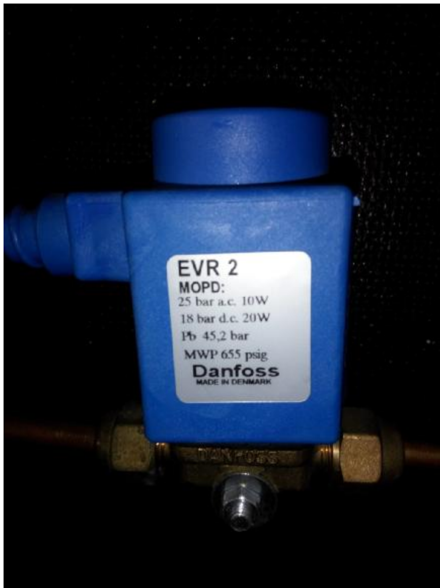
Σχήμα 61: Ηλεκτρομαγνητική βαλβίδα (Danfoss EVR 2)
