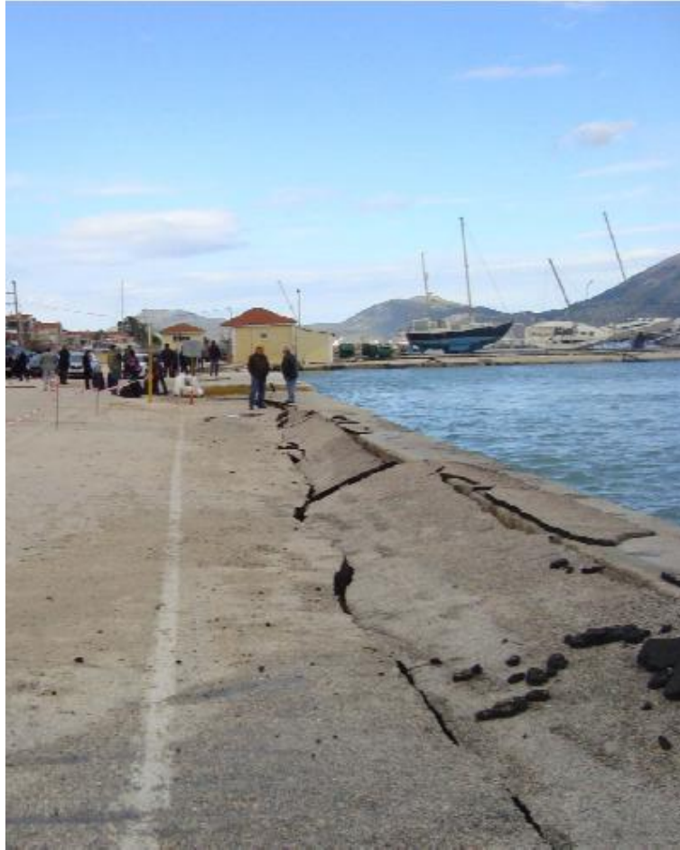
Εικόνα 3.18: Ρευστοποίηση στο λιμένα
