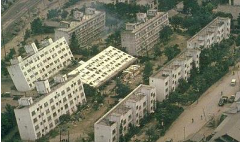
Εικόνα 1.1: Ανατροπή πολυκατοικιών λόγω ρευστοποίησης των υποκείμενων εδαφικών σχηματισμών (Niigata, Ιαπωνία, 1964).
