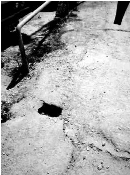
Εικόνα 3.8: Λευκάδα-parking: Δημιουργία πίδακα άμμου
