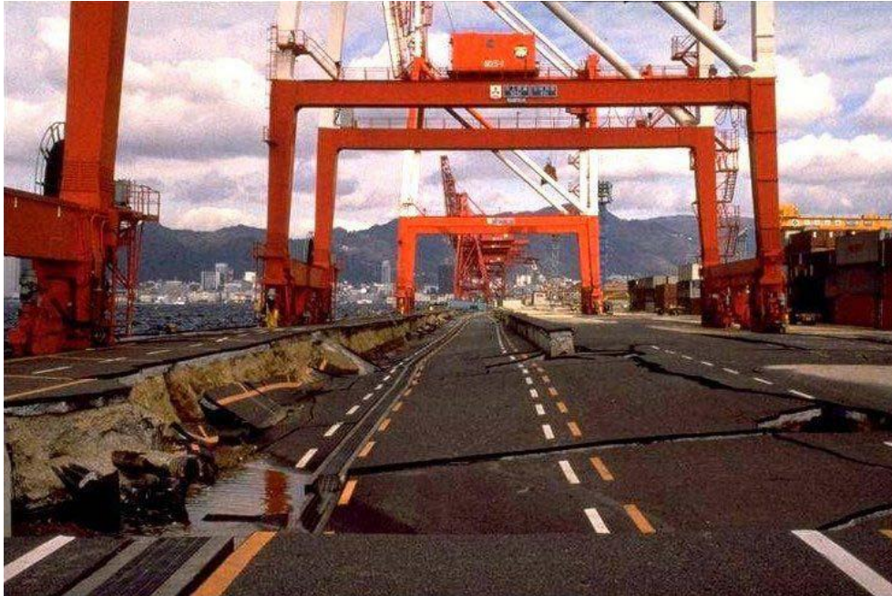
Εικόνα 2.4 Πλευρική μετατόπιση της αποβάθρας στο λιμένα Κοβε, το 1995.
