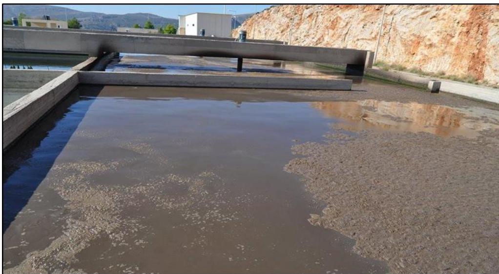
Εικόνα (β): Δεξαμενή απονιτροποίησης
