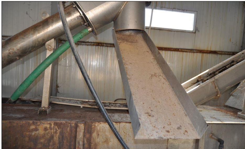
Εικόνα: Μονάδα εσχάρωσης
