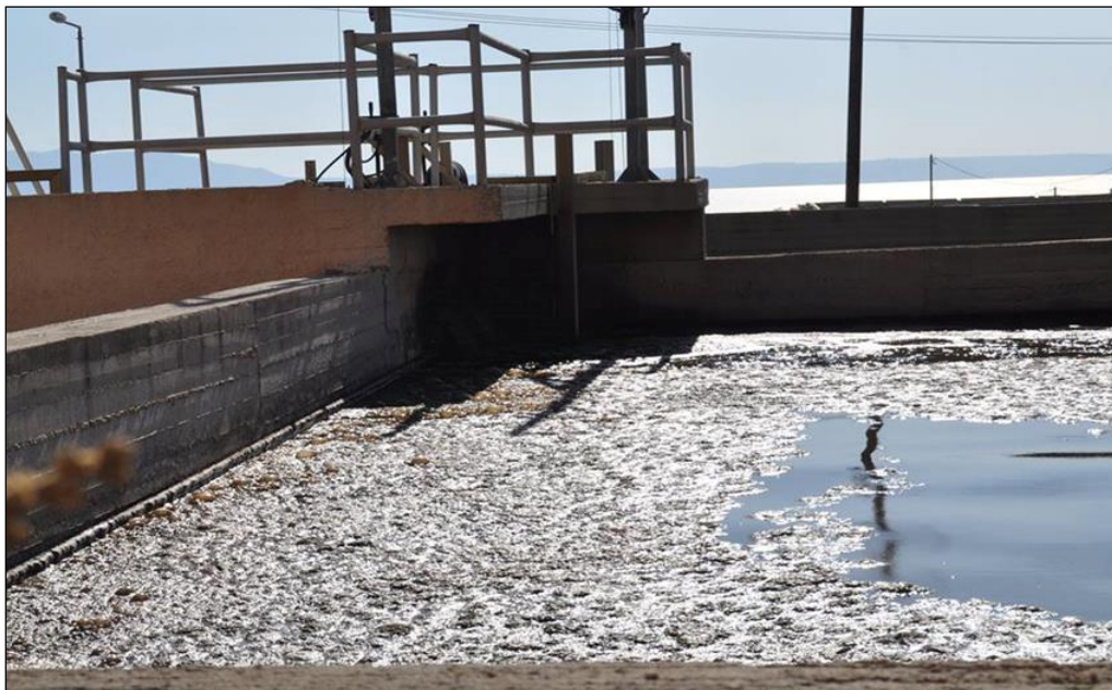
Εικόνα (α): Δεξαμενή απονιτροποίησης
