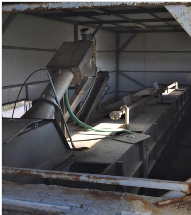
Εικόνα: Μονάδα εσχάρωσης
