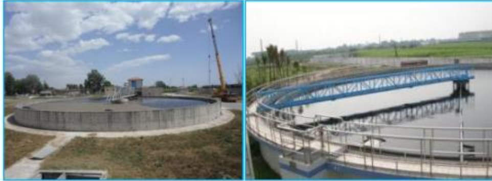
Εικόνα: Δεξαμενές δευτεροβάθμιας καθίζησης
