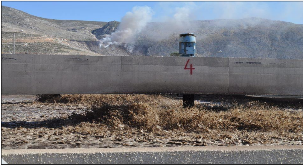
Εικόνα: Αναδευτήρας δεξαμενής αερισμού
