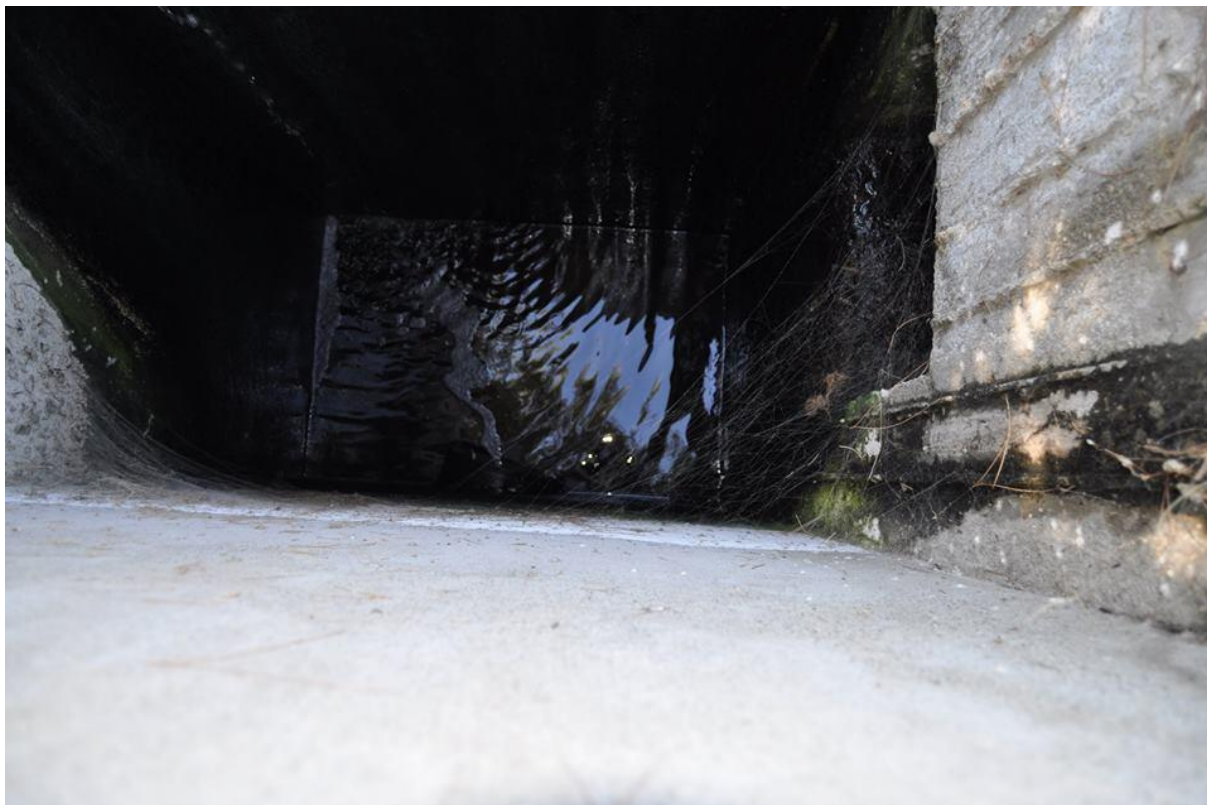
Εικόνα: Δεξαμενή Επεξεργασμένου νερού
