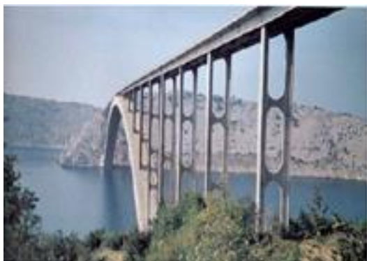
γ. Γέφυρα από σκυρόδεμα
