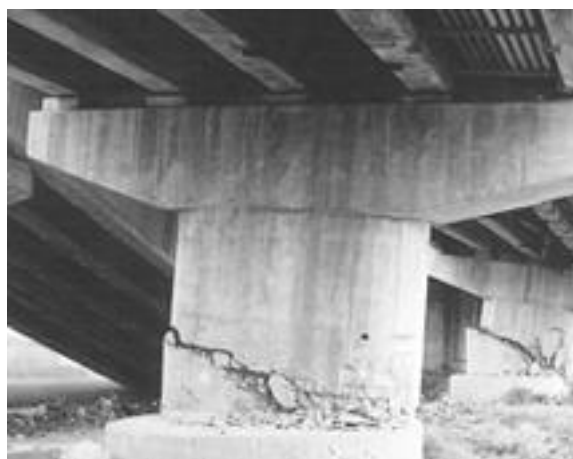
Σχήμα 2.2: Αστοχία καμπτικού τύπου.
