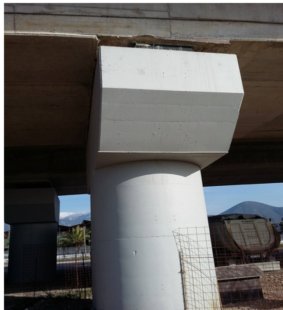
Φωτ. 6.5: Δυτική όψη μεσοβάθρου M3.Δ (αποτελείται από ένα σύλο και έχει ορθογωνική διατομή με ημικυκλικά άκρα με εξωτερικές διαστάσεις 2.5m x 4.0m) σε πρώτο πλάνο.
