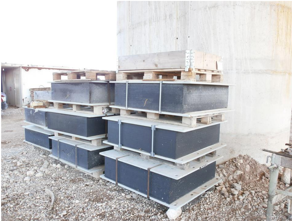
Φωτ. 6.11: Στην παραπάνω φωτογραφία απεικονίζονται τα εφέδρα που χρησιμοποιήθηκαν στο σύνολο του έργου του ανισόπεδου δρόμου.
