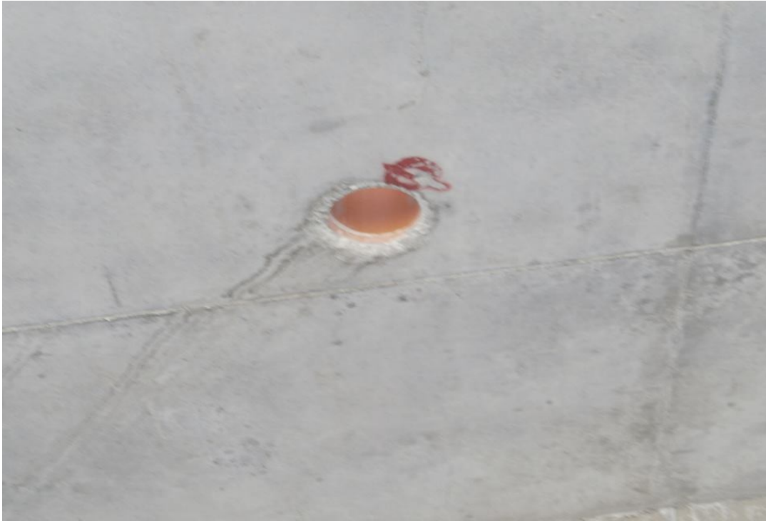
Φωτ. 6.14: Αγωγός παροχέτευσης όμβριων υδάτων.
