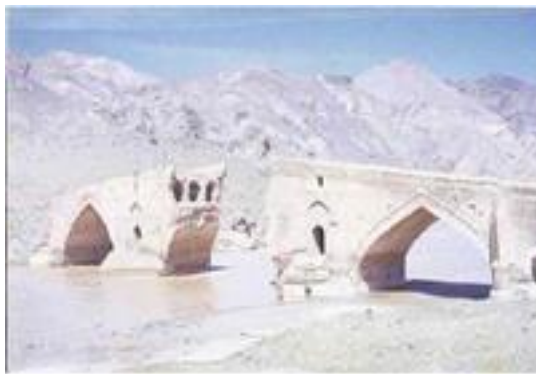
β. Γέφυρα λίθινη
