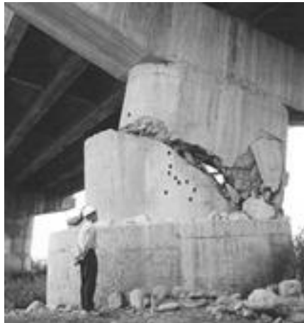
Σχήμα 2.3: Αστοχία διατμητικού τύπου.
