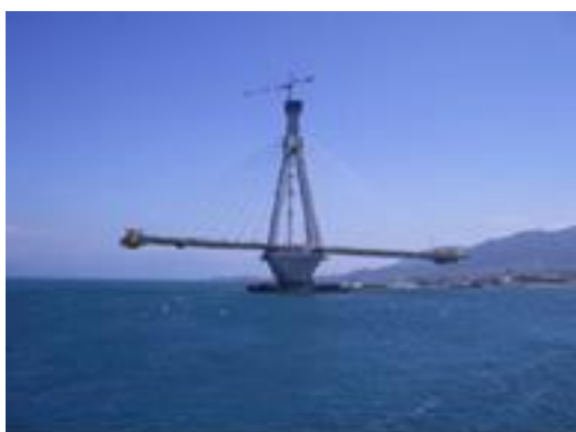
ε. Σύμμικτη γέφυρα
