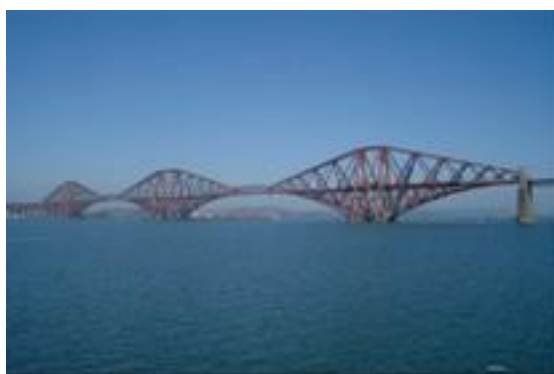
δ. Γέφυρα μεταλλική
