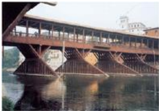
α. Γέφυρα ξύλινη
