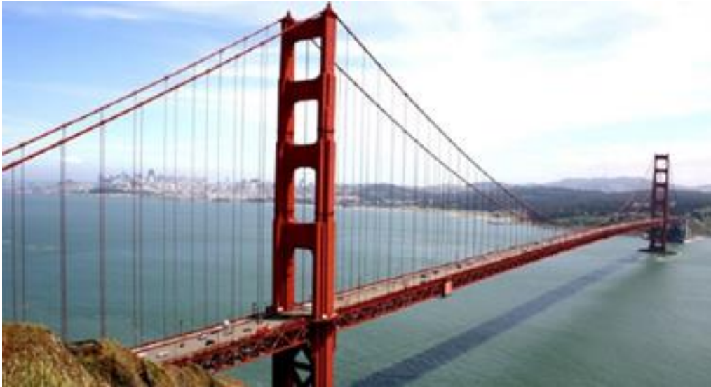
Σχήμα 1.6: Γέφυρα της Χρυσής Πύλης, Σαν Φρανσίσκο.
