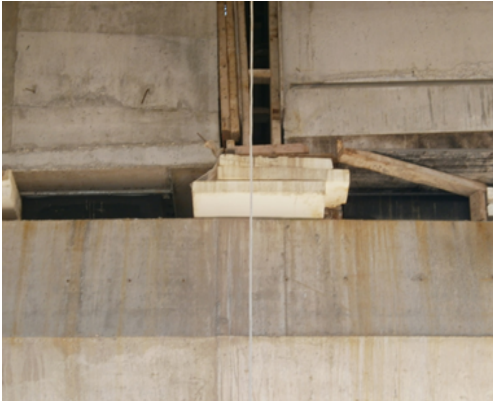
Φωτ. 6.8: Θέση τοποθέτησης εφεδράνων και αρμός μεταξύ της παρούσας γέφυρας T1 και της T2(Δεξιά).
