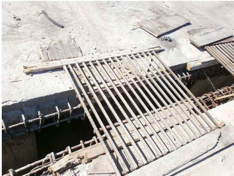
Φωτ. 6.13: Λεπτομέρεια του αρμού μεταξύ της γέφυρας T1 και T2 μετά την ολοκλήρωση της σκυροδέτησης του καταστρώματος.
