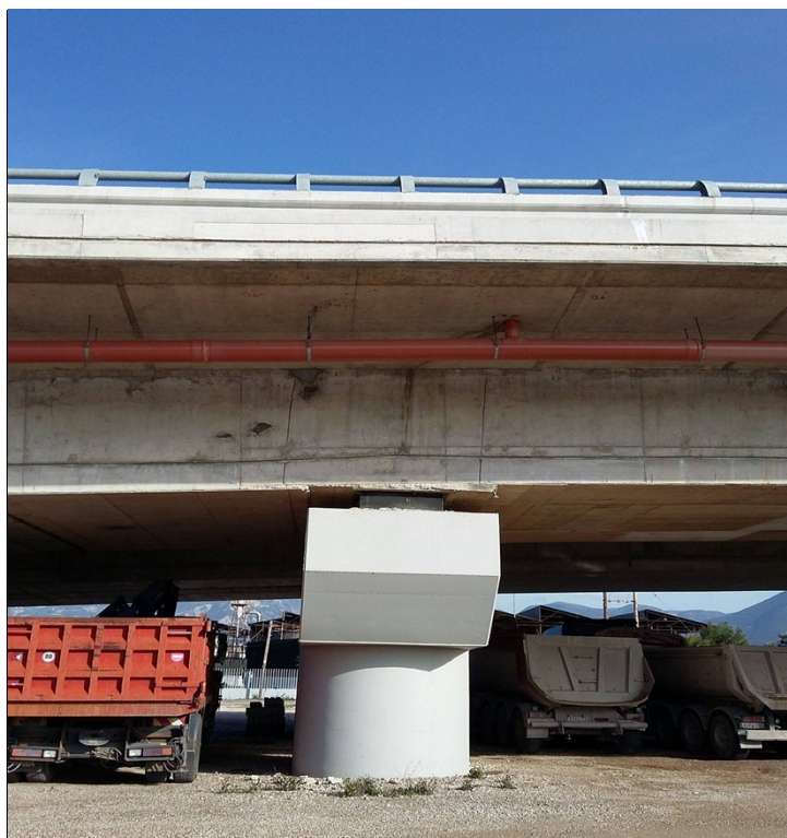
Φωτ. 6.3: Δυτική όψη μεσοβάθρου Μ1.Δ (αποτελείται από ένα στύλο και έχει ορθογωνική διατομή με ημικυκλικά άκρα με εξωτερικές διαστάσεις 2.5m x 4.0m).
