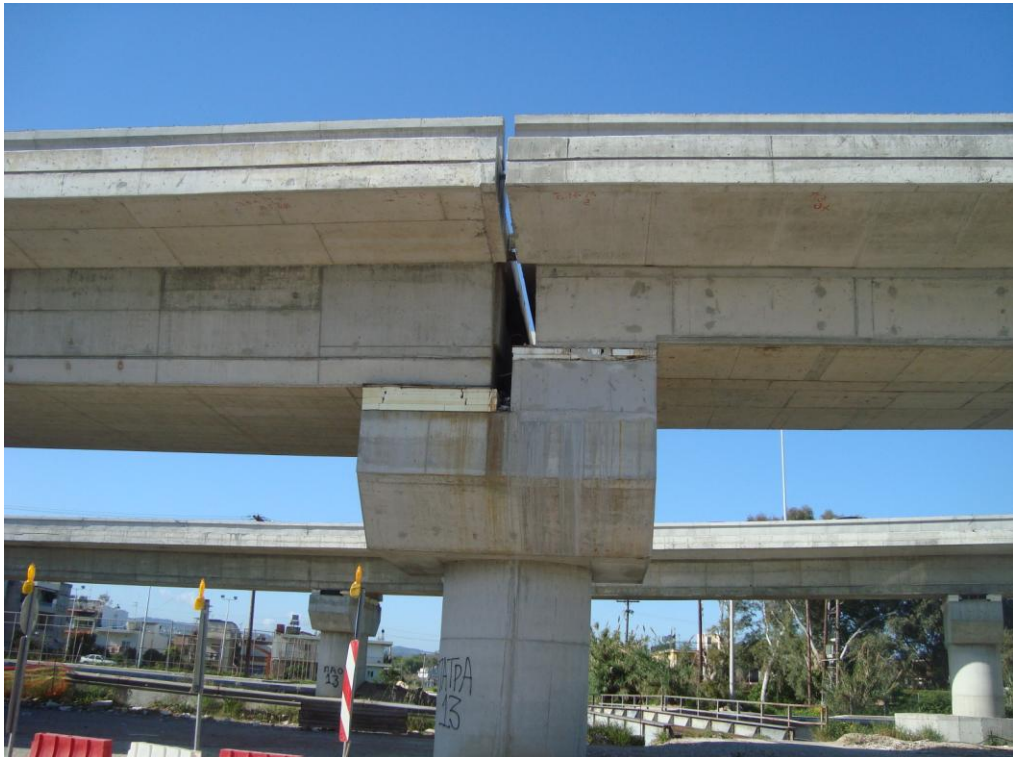
Φωτ. 6.15: Αρμός μεταξύ παρούσας γέφυρας T10 (αριστερά) και γέφυρας T9 (δεξιά) άνωθεν του μεσόβαθρου M14.A.
