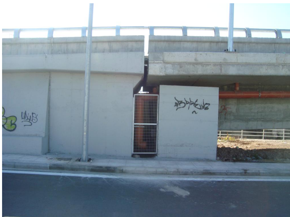
Φωτ. 6.3: Ολοκληρωμένο τμήμα ανωδομής νότιας όψης ακροβάθρου A2.A (δεξιά) τοιχοειδούς μορφής από οπλισμένο σκυρόδεμα C20/25.
