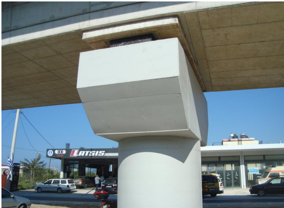
Φωτ. 6.13: Βόρεια όψη ολοκληρωμένου μεσόβαθρου Μ15.Α ύψους 5,00m αποτελούμενο από ένα στύλο με κυκλική διατομή και ημικυκλικά άκρα.
