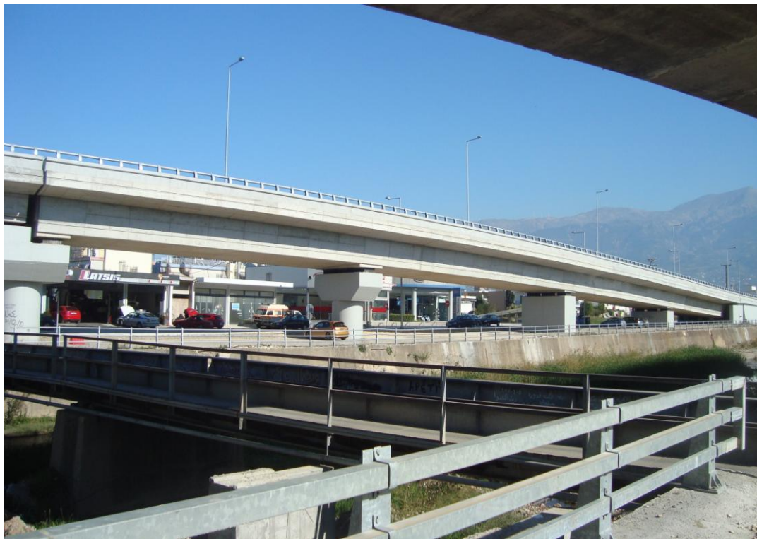
Φωτ. 6.21: Ολοκληρωμένη ανωδομή άνωθεν μεσοβάθρων M14.A (αριστερά), M15.A, M16.A, M17.A και ακροβάθρου A2.A (δεξιά) στην αριστερή Παραγαλιάκι αρτηρία Πατρών.
