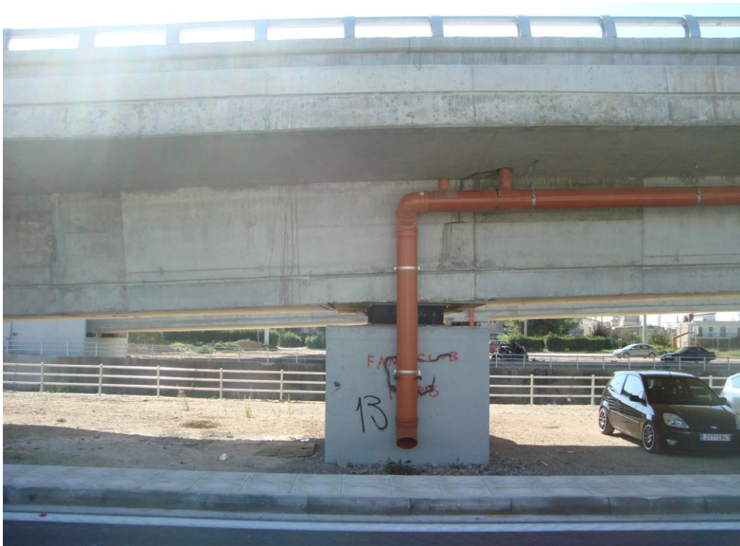
Φωτ. 6.8: Νότια όψη μεσόβαθρου M17.A ορθογωνικής διατομής από οπλισμένο σκυρόδεμα C30/37 και αγωγός παροχέτευσης όμβριων υδάτων.
