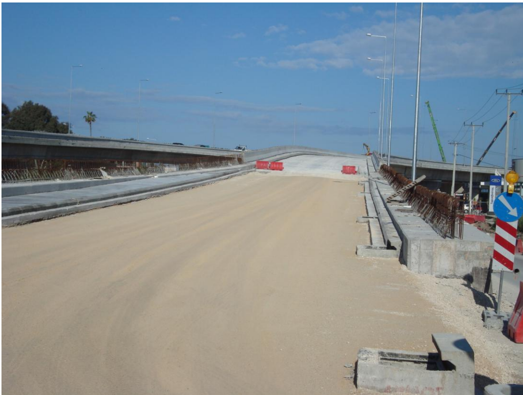
Φωτ. 6.19: Φάση κατασκευής καταστρώματος της παρούσας γέφυρας T10.
