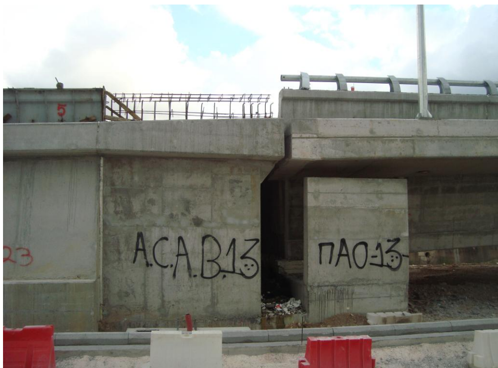
Φωτ. 6.2: Αρμός μεταξύ Παραγλαύκιας αρτηρίας (αριστερά) με το ακρόβαθρο A2.A (φαίνεται δεξιά) της παρούσας γέφυρας T10.
