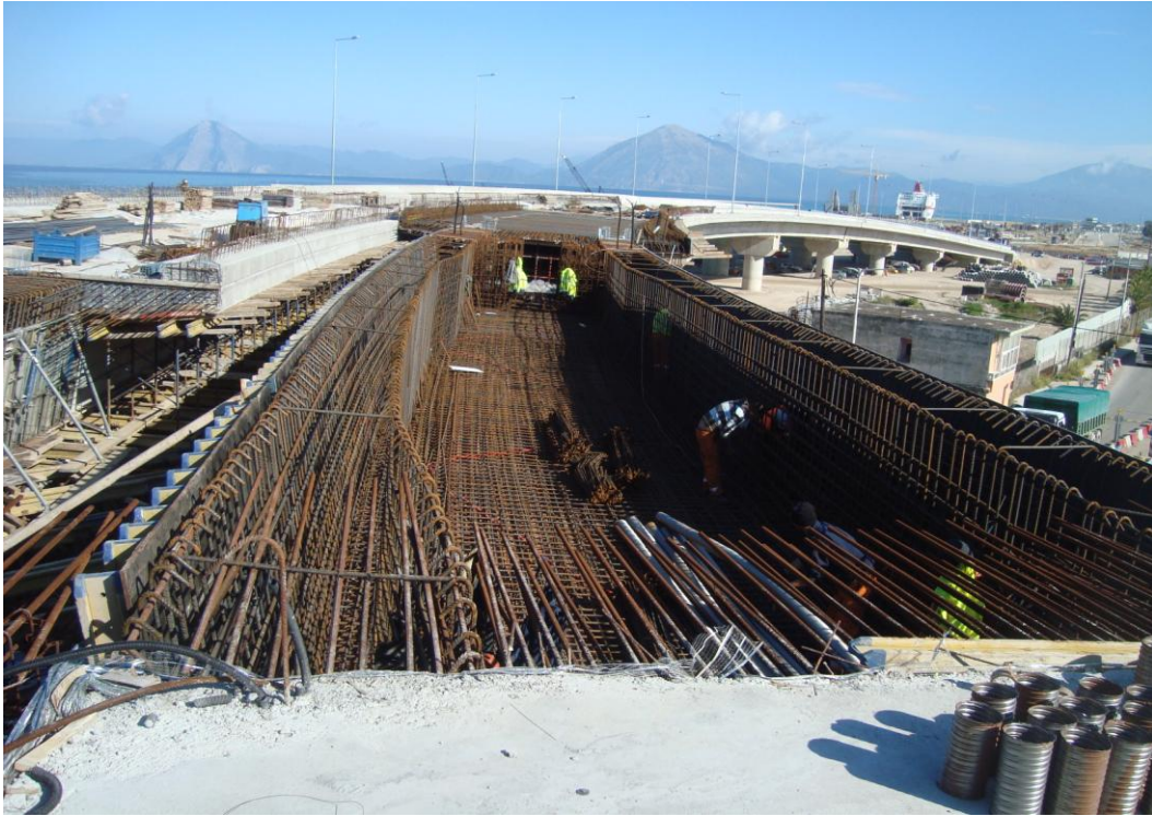
Φωτ. 6.18: Διάταξη σπλισμού της κυβωτοιειδούς διατομής της γέφυρας T9 πριν την σκυροδέτηση.
