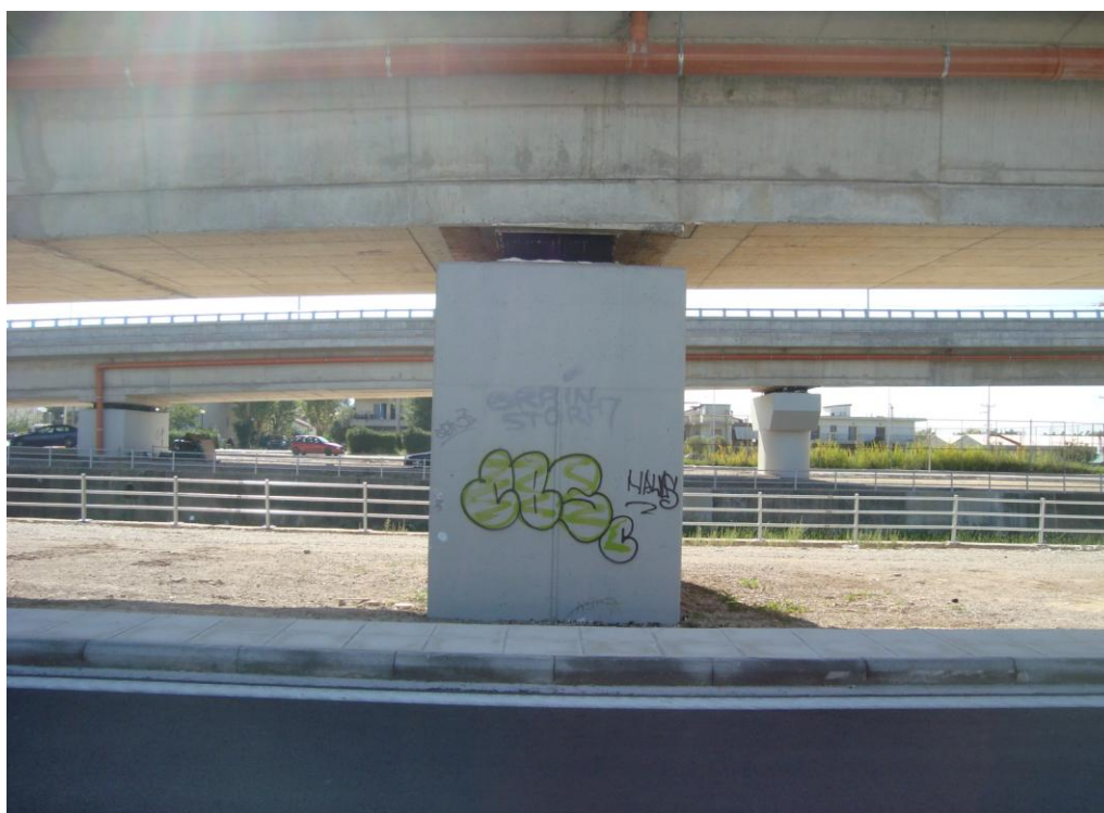
Φωτ. 6.11: Νότια όψη του μεσόβαθρου M16.A ορθογωνικής διατομής μετά την ολοκλήρωση του έργου.
