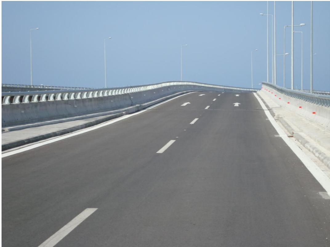
Φωτ. 6.20: Ολοκλήρωση του καταστρώματος της γέφυρας με τις προβλεπόμενες τρεις στρώσεις ασφαλτικών, η ανώτερη εκ των οποίων αντιολισθηρή πάχους 4cm.
