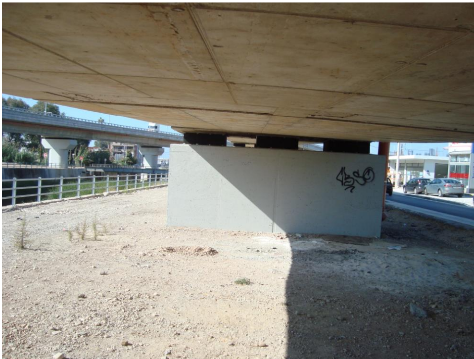
Φωτ. 6.7: Βορειοδυτική όψη ολοκληρωμένου μεσόβαθρου M17.A ορθογωνικής διατομής διαστάσεων 5,5m x 2,5m και τοποθετημένα ελαστομεταλλικά εφεδράνα.
