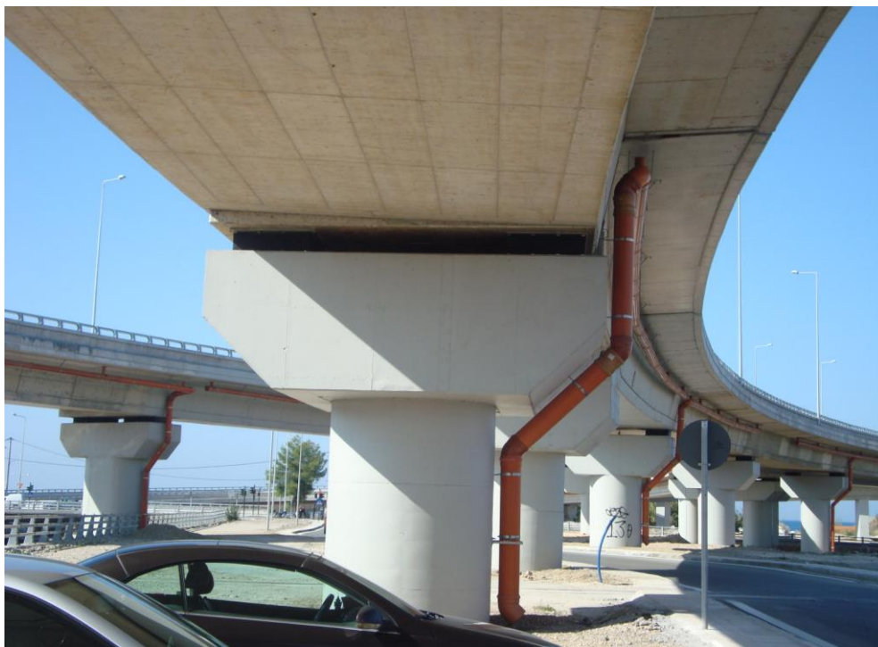
Φωτ. 6.17: Βορειοδυτική όψη ολοκληρωμένου μεσόβαθρου M14.A. κυκλικής διατομής με κοινή κεφαλή για την έδραση της ανωδομής των γεφυρών T9 και T10.
