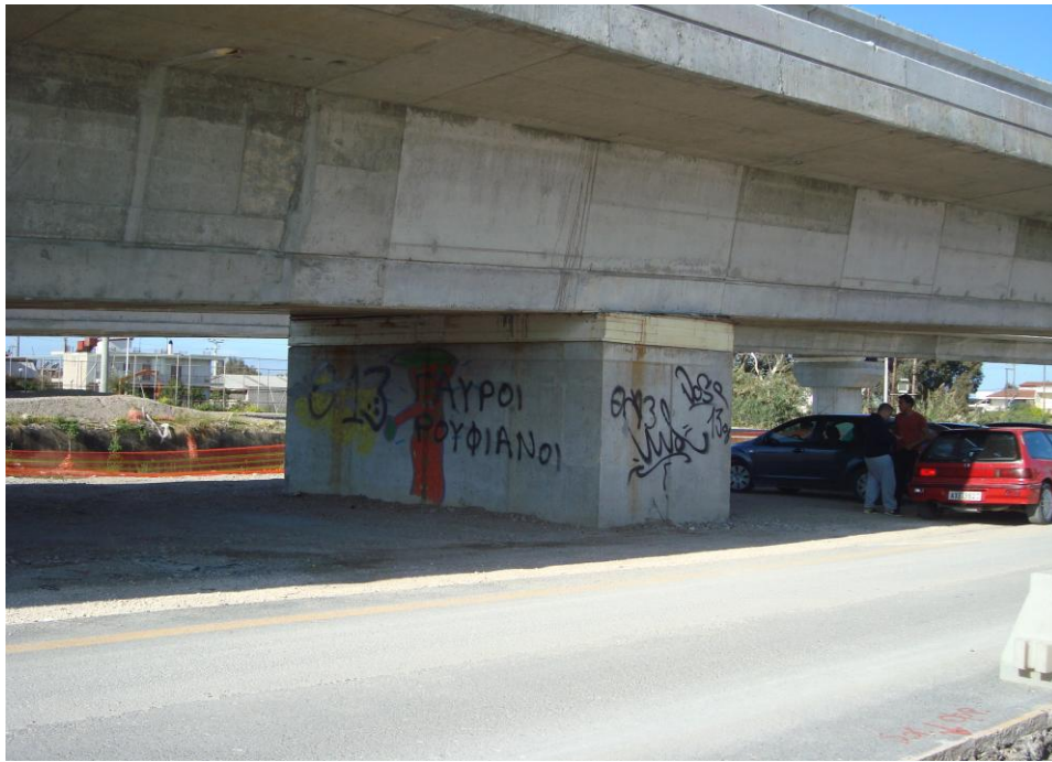
Φωτ. 6.6: Νοτιοδυτική όψη μεσόβαθρο M17.A και θέσεις τοποθέτησης εφεδράνων.
