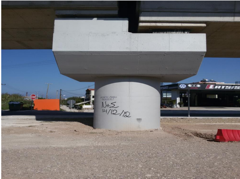
Φωτ. 6.16: Βόρεια όψη μεσόβαθρου M14.A κυκλικής διατομής από οπλισμένο σκυρόδεμα C30/37 με ελαστομεταλλικά εφάδρανα.
