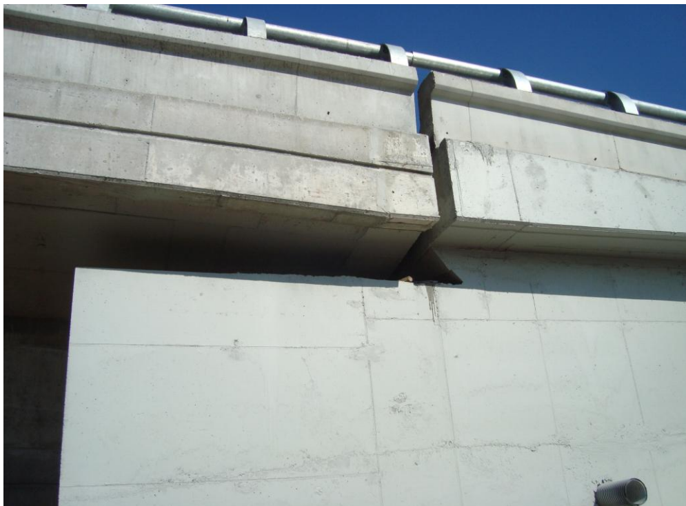
Φωτ. 6.5: Βόρεια όψη αρμού συστολοδιαστολής μεταξύ γέφυρας T10 που εδράζεται στο ακρόβαθρο A2.A (αριστερά) και υπάρχουσας αριστερής Παραγλαύκιας αρτηρίας (δεξιά).
