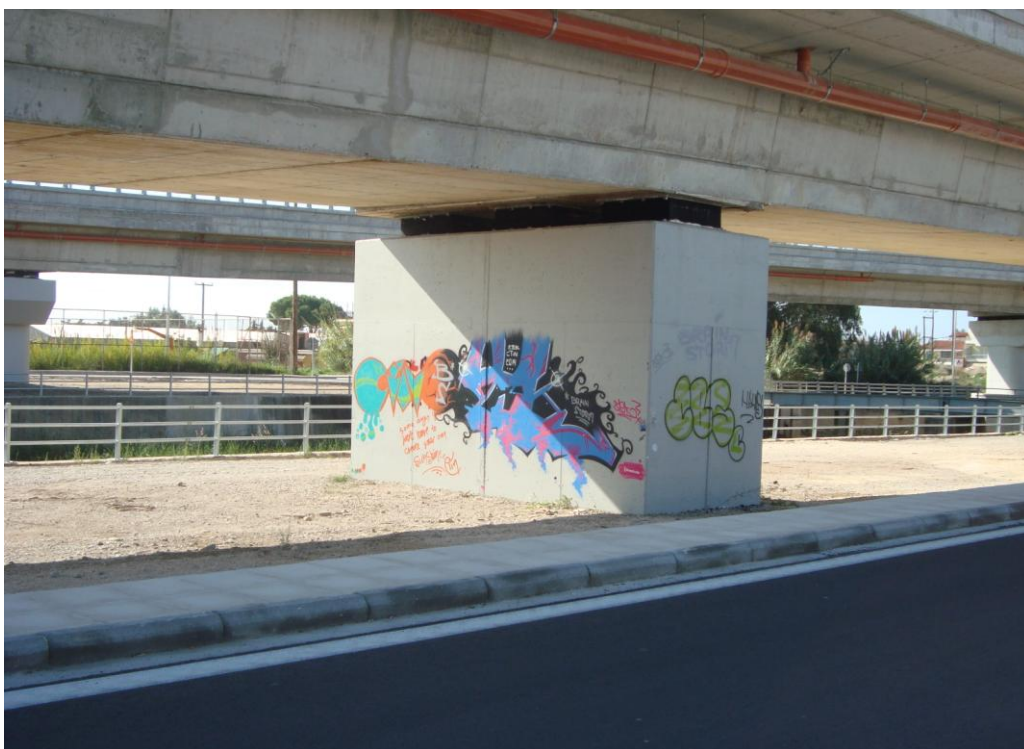
Φωτ. 6.10: Νοτιοδυτική όψη μεσόβαθρου M16.A όπου διακρίνονται τα τοποθετημένα ελαστομεταλλικά εφέδρανα.
