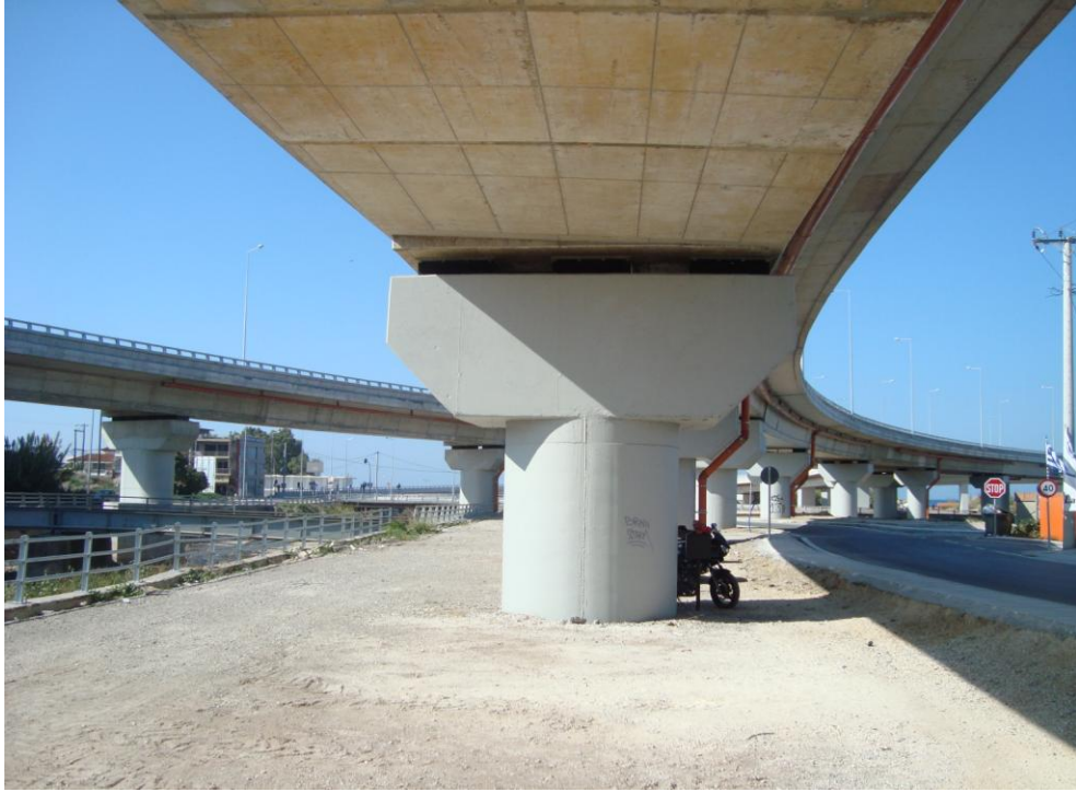
Φωτ. 6.14: Δυτική όψη μεσόβαθρου M15.A κυκλικής διατομής με μήκος κεφαλής 2,50m και διακρίνονται τα εφέδρανα μεταξύ του μεσόβαθρου και του καταστρώματος της γέφυρας.
