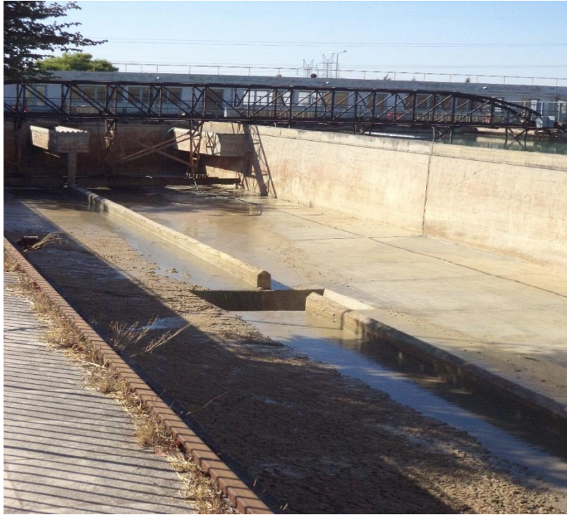
Εικόνα 5-11. Άδεια δεξαμενή καθίζησης. Η ιλύς έχει καθιζάνει μετά από την διαδικασία της καθίζησης.
