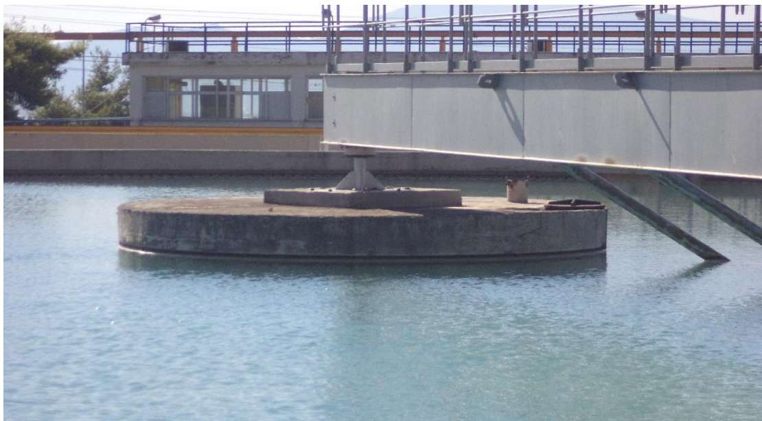
Εικόνα 5-16. Κώνος περισυλλογής ιλύος
