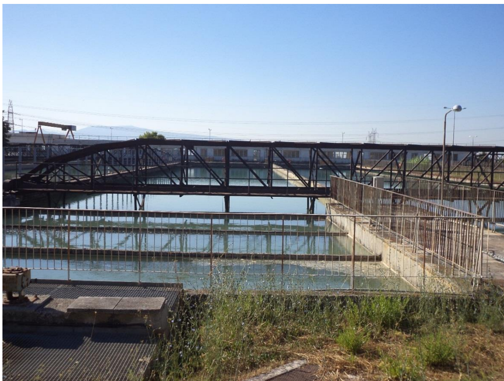
Εικόνα 5-1. Ορθογώνια δεξαμενή με ορατή γερανογέφυρα
