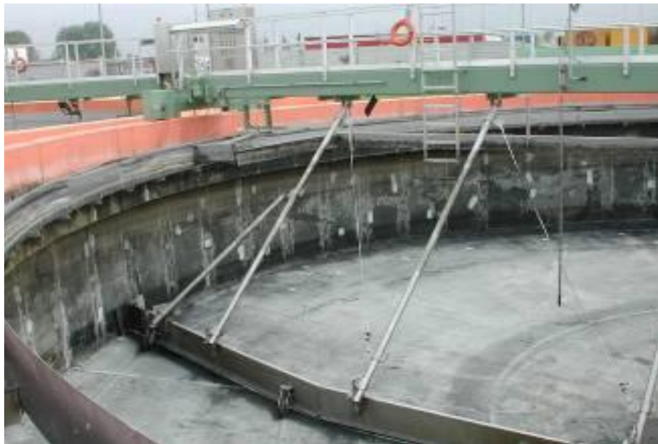
Εικόνα 5-20. Ξέστρο (σάρωθρο) πυθμένα
