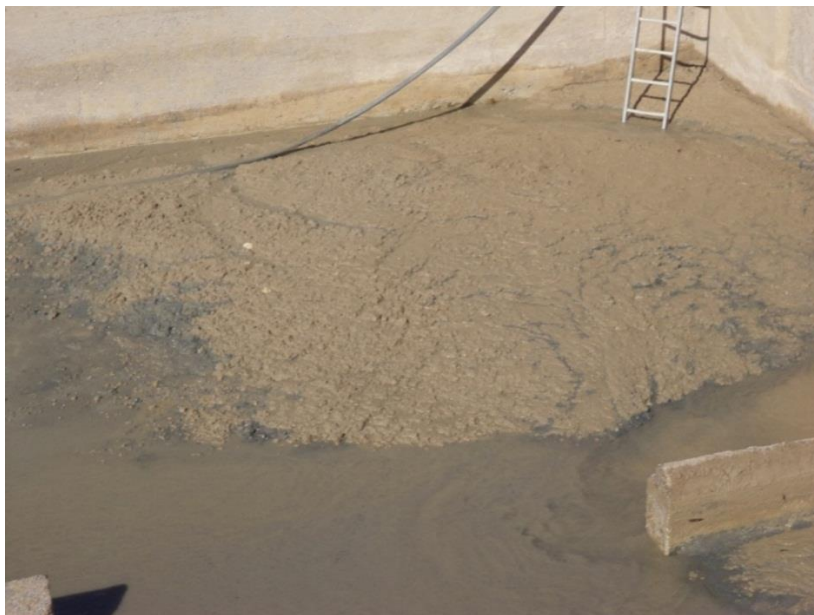
Εικόνα 5-11. Άδεια δεξαμενή καθίζησης. Η ιλύς έχει καθιζάνει μετά από την διαδικασία της καθίζησης.
