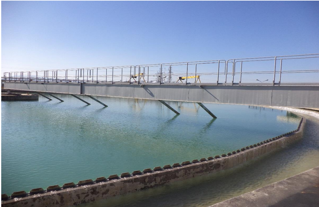
Εικόνα 5-15. Βλέπουμε την γερανογέφυρα της δεξαμενής, τους υπερχειλιστές και το ξέστρο (σάρωθρο)
