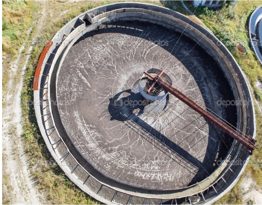
Εικόνα 4-3. Άδεια κυκλική δεξαμενή καθίζησης που είναι εμφανής η γερανογέφυρα και ο κώνος περισυλλογής ιλύος
