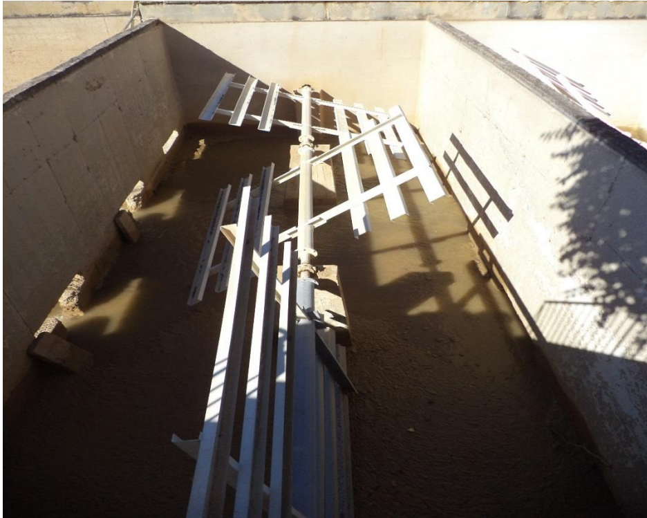
Εικόνα 5-13. Ξέστρο, η χρήση του είναι να καθαρίζει τον πυθμένα των δεξαμενών καθίζησης
