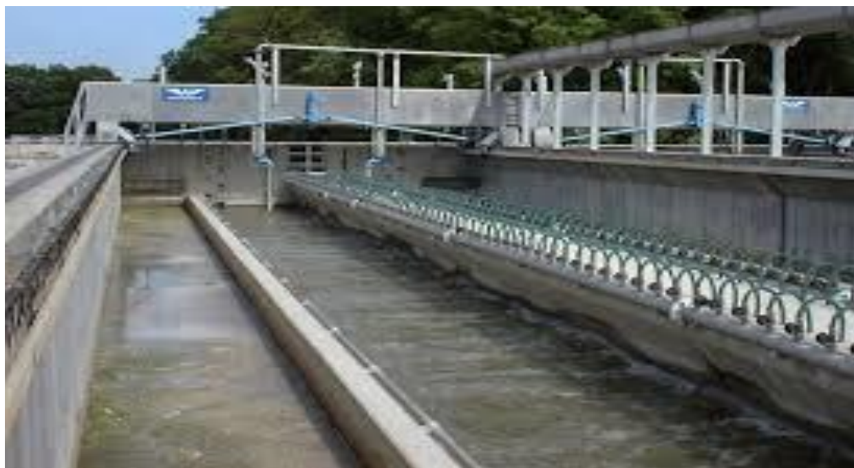
Εικόνα 4-2. Ορθογώνια δεξαμενή όπου είναι ορατοί οι υπερχειλιστές
