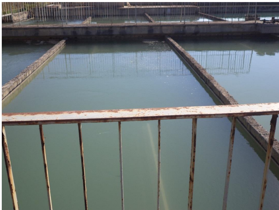
Εικόνα 5-3. Εν συνεχεία μετά την χρήση των κροκιδωτικών και με την συνεχή ανάδευση του νερού με τους αναδευτήρες, η ιλύς καθιζάνει ακόμα περισσότερο και διάφορα άλλα αντικείμενα όπως κλαδιά . Το νερό καθαρίζει όλο και περισσότερο και η θολότητα βελτιώνεται.
