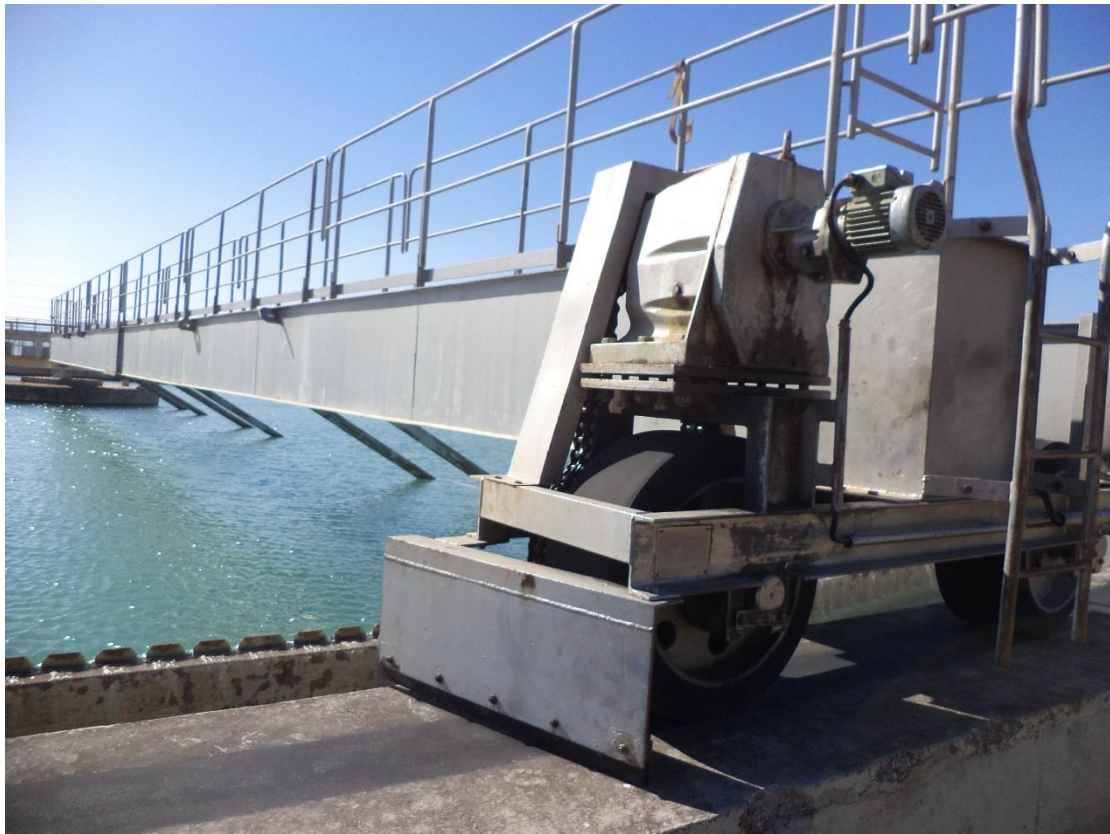
Εικόνα 5-19. Σύστημα καθαρισμού της εξωτερικής επιφάνειας της δεξαμενής
