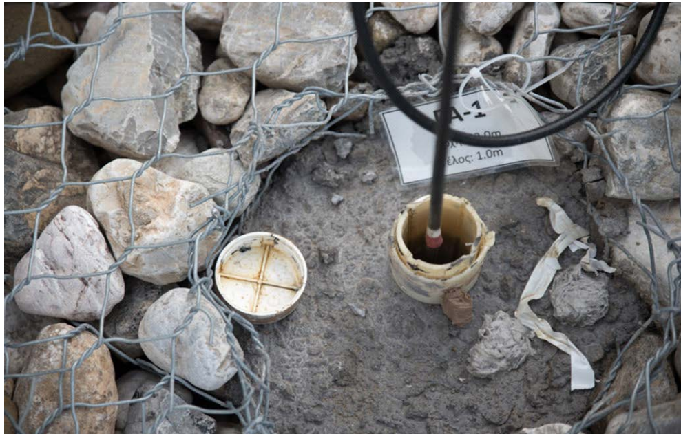
Σχήμα 4.7 Γεώτρηση ΓΑ-1 (32.5m) κατά την μέτρηση με το αποκλισίμετρο
