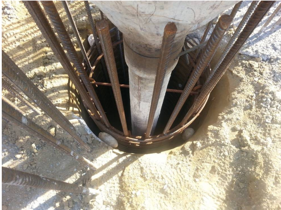
Σχήμα 3.19 Σωλήνας σκυροδέτησης τοποθετημένος στο εσωτερικό του φρεατίου.
