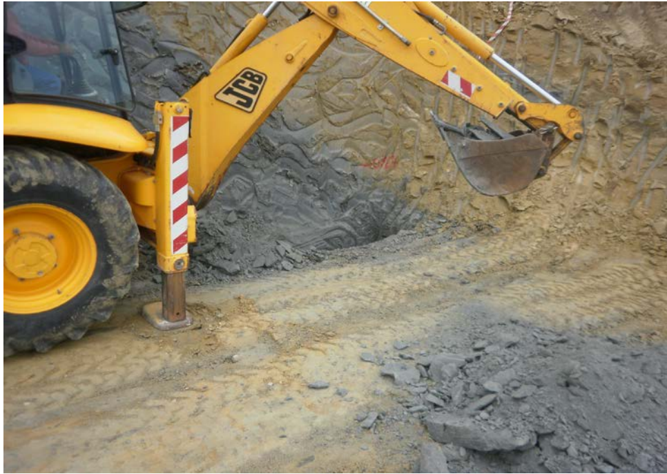
Σχήμα 1.3 Επί τόπου εκσκαφή.
