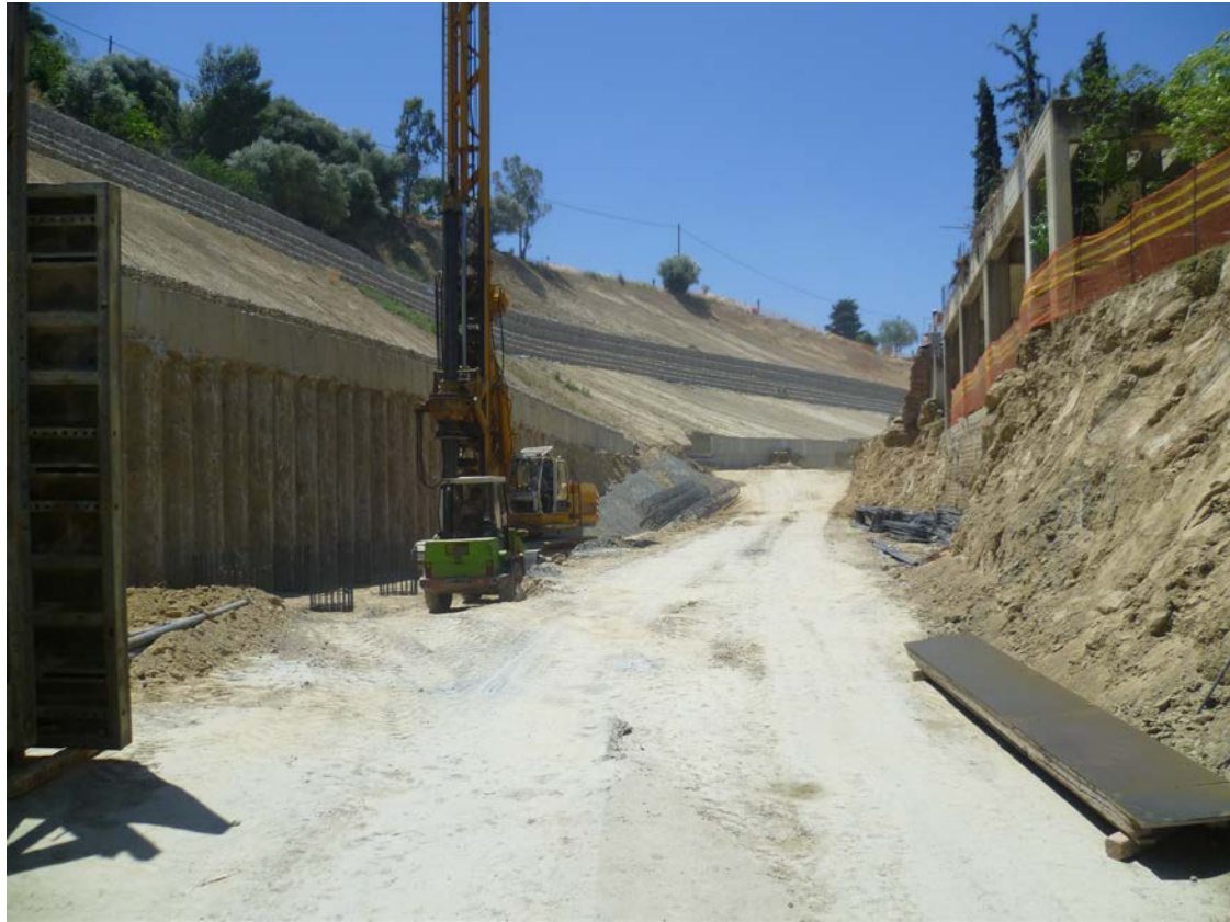
Σχήμα 3.10 Φανέρωση του δεύτερου επιπέδου εκσκαφής.
