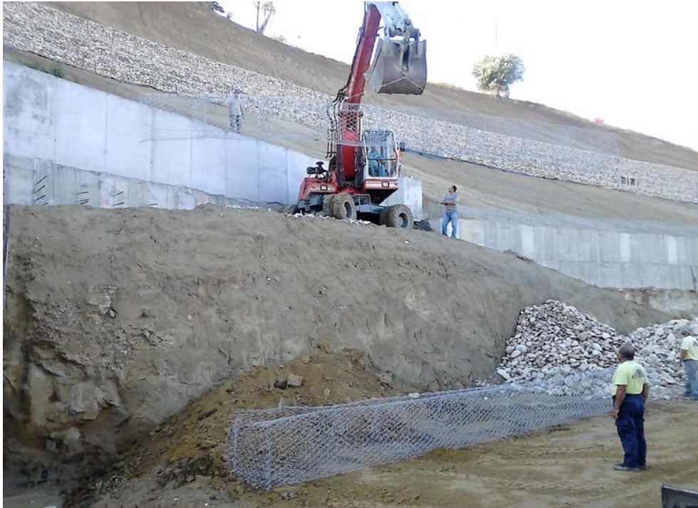
Σχήμα 5.10 Μεταφορά των ακόμα, ακαθόριστου σχήματος, πλεγμάτων σε ανώτερο επίπεδο εκσκαφής
