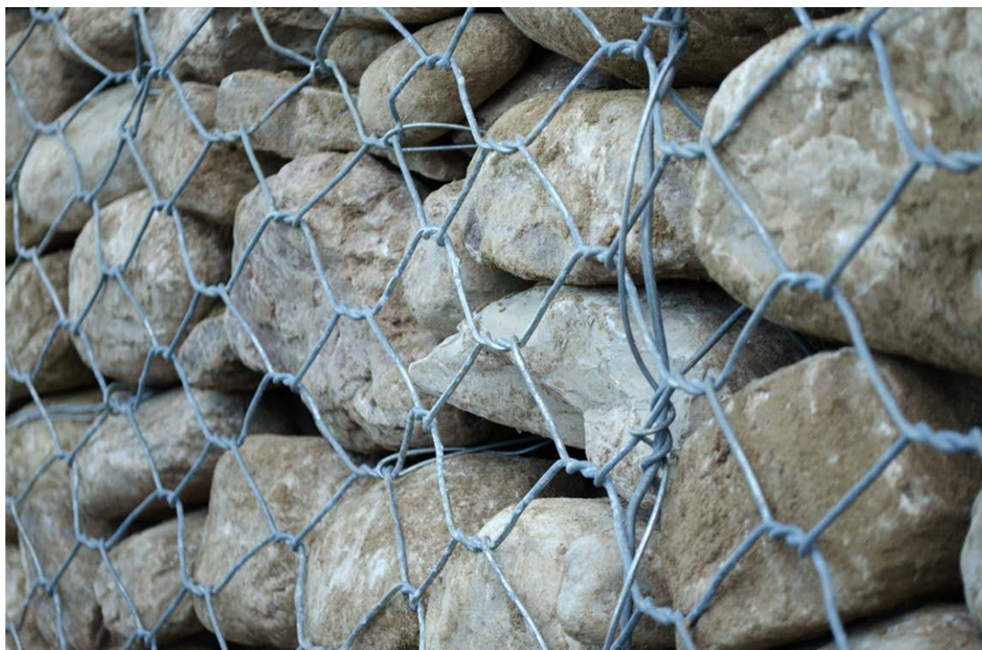
Σχήμα 5.8 Λεπτομέρεια από τα σαρζανέτ της οδού (Σύρμα γαλβανιζέ και πέτρες).
