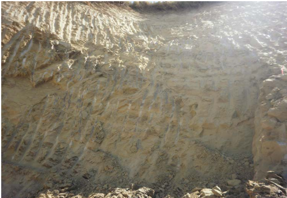
Σχήμα 1.4 Σχηματισμοί των εδαφικών υλικών κατά την εκσκαφή.
