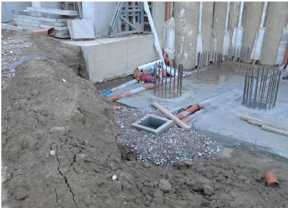
Σχήμα 3.64 Φρεάτιο στο οποίο καταλήγουν οι πορτοκαλί, από PVC, σωλήνες αποστράγγισης.
