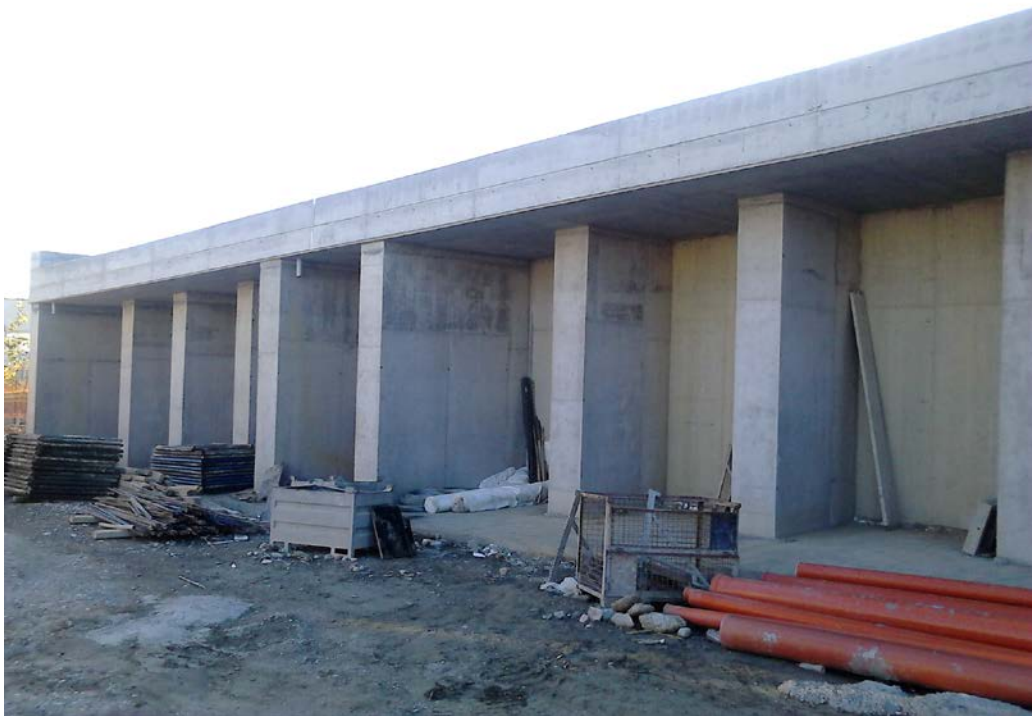
Σχήμα 3.57 Σκυροδετημένα όλα τα βασικά στελέχη του τοίχου αντιστήριξης
