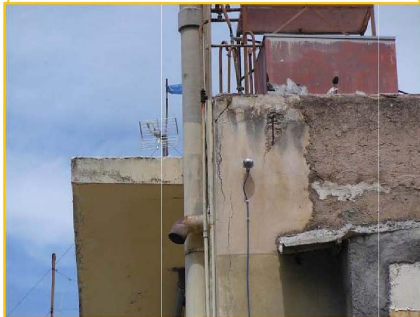
Σχήμα 4.17 Φωτογραφική άποψη της θέσης εγκατάστασης του κλισιμέτρου T-2 ( Νόρμαν-Αγ.Σοφίας, Χ.Θ. 0+219)
