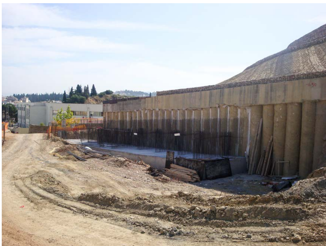
Σχήμα 3.53 Σκυροδετημένος κεφαλόδεσμος και κομμάτι του σκελετού των αντηρίδων.
