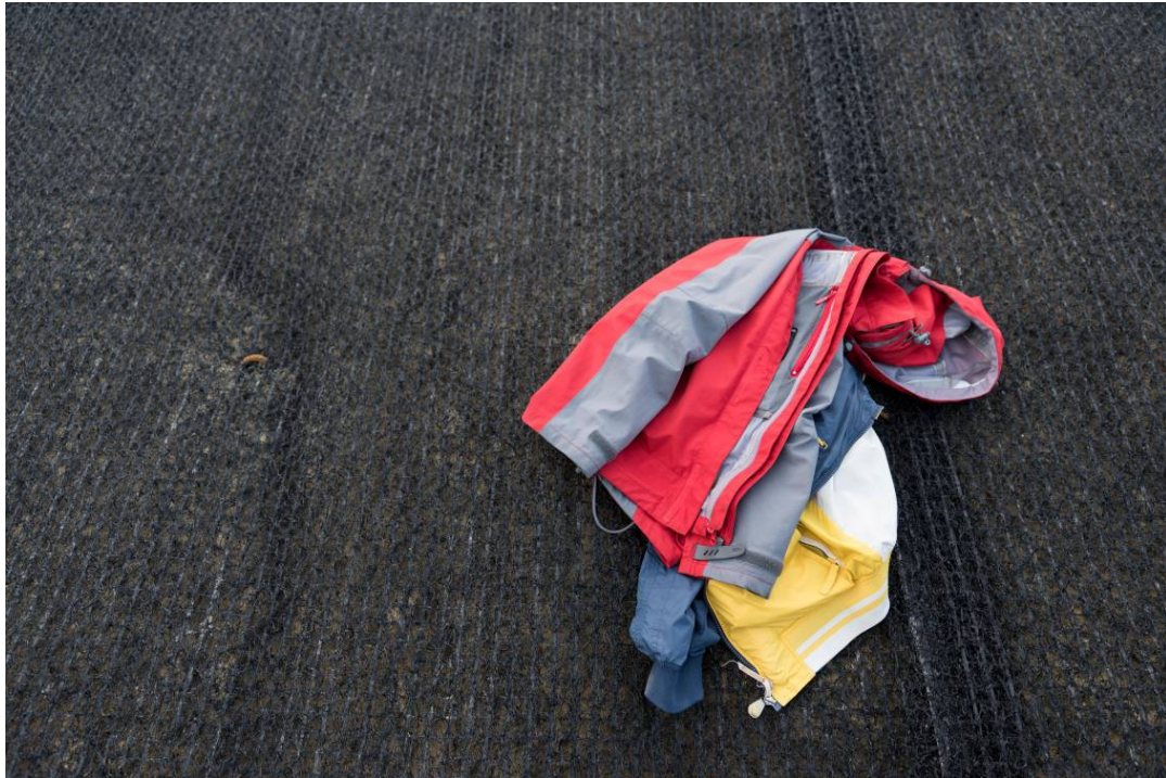
Σχήμα 5.5 Κοντινή άποψη γεωπλέγματος στο έργο και μπουφάν εργατών.
