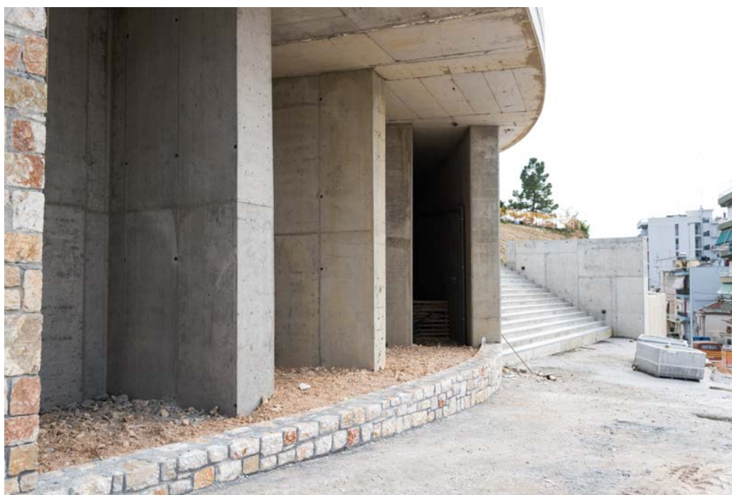
Φωτογραφία 2 Τοίχος αντιστήριξης με καλοπιστικές λεπτομέρειες πέτρας στην αρχή του τμήματος 2
