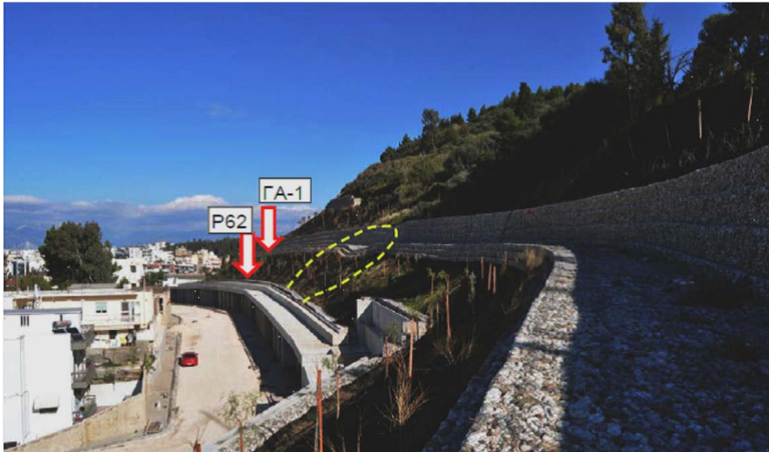
Σχήμα 4.19 Άποψη των έργων αντιστήριξης στην περιοχή των αποκλισημέτρων ΓΑ-1 και Ρ62.
