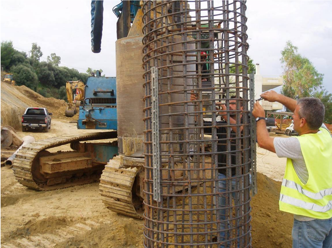
Σχήμα 3.18 Τοποθέτηση των αποστατών στους κλωβούς.
