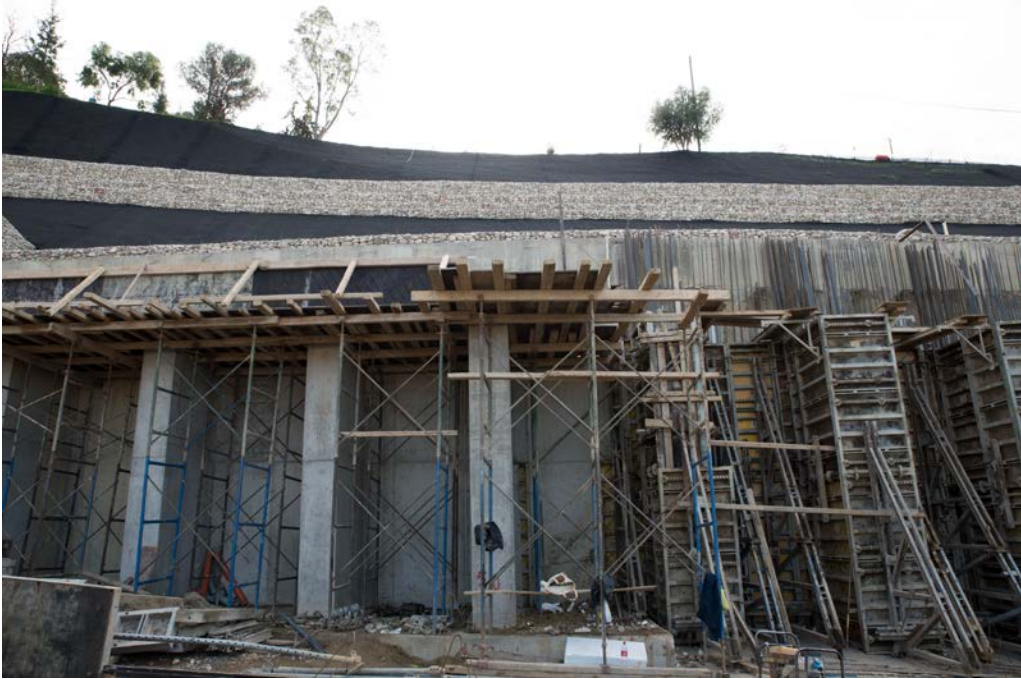
Σχήμα 3.56 Κατασκευή προβόλου σε δύο φωτογραφίες
