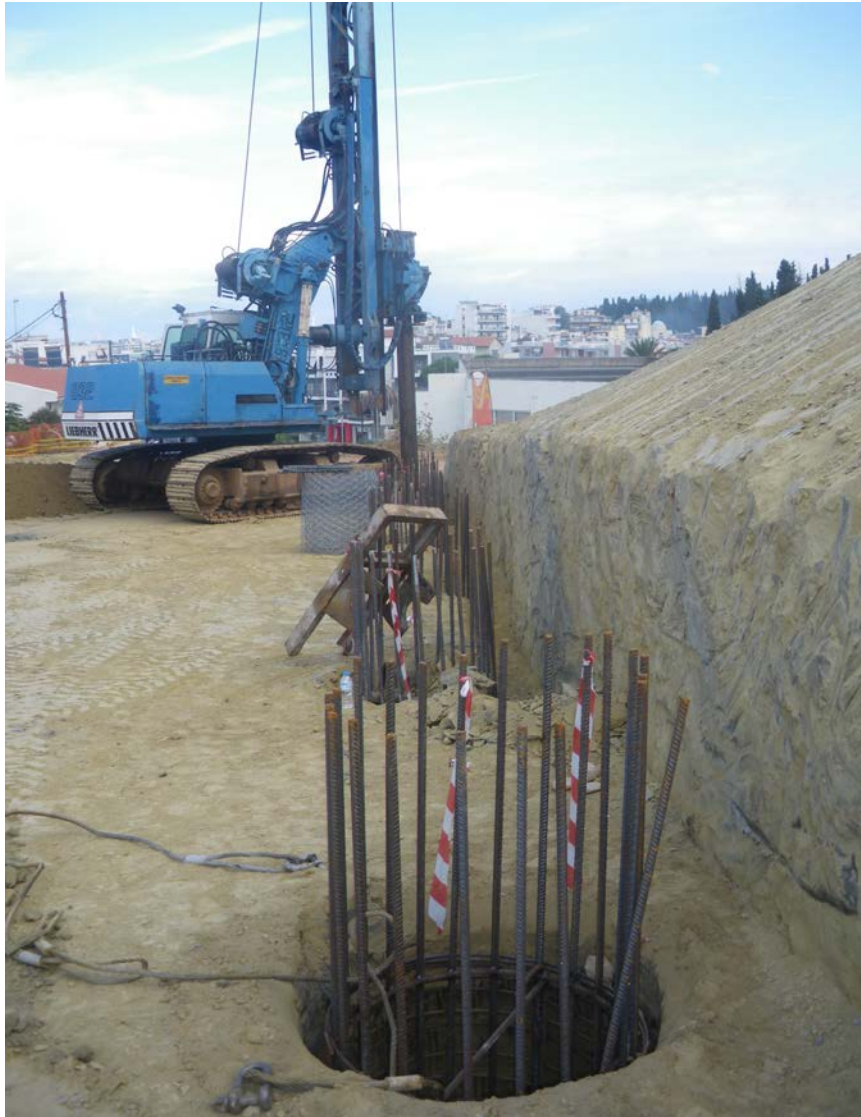
Σχήμα 3.5 Φρεατοπάσσαλος στο τμήμα 2 και γεωτρύπανο για την διάνοιξη των οπών των πασσάλων.
