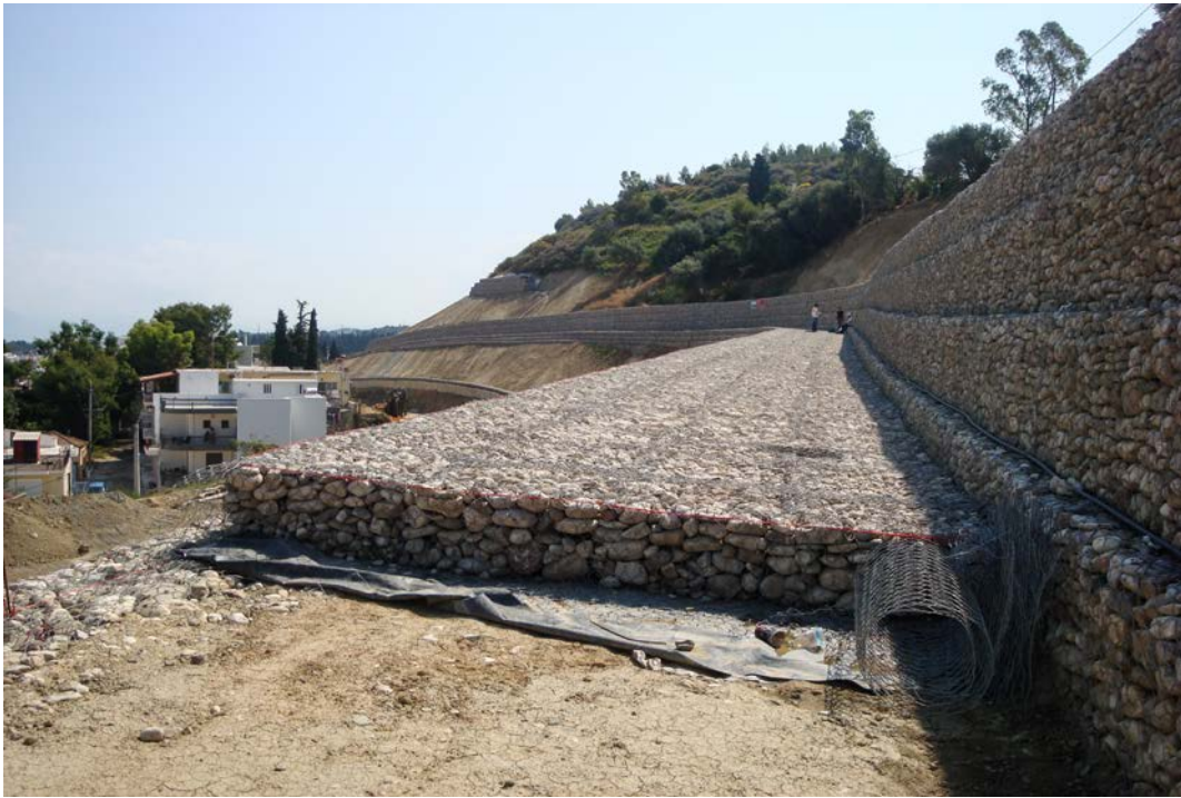
Σχήμα 5.15 Στρώση συρματοκιβωτίων στο έργο η οποία αποτελεί κομμάτι του δεύτερου τοίχου σαρζανέτ που βρίσκεται στην μέση του πρανούς
