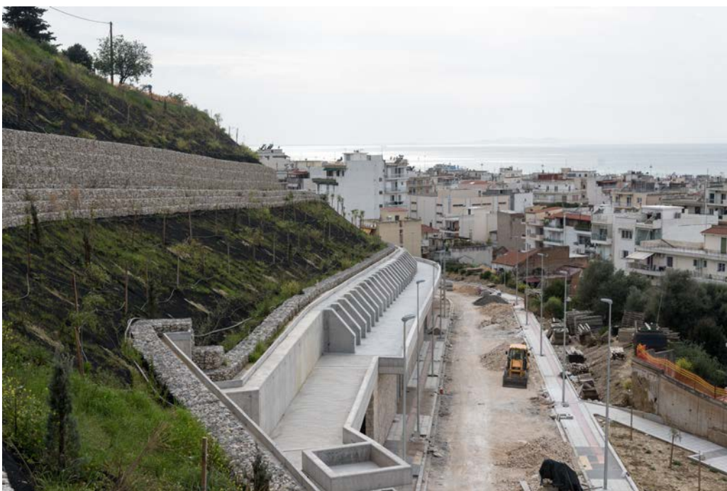
Φωτογραφία 1 Τμήμα 2 της οδού Κανακάρη τον Μάρτιο του 2016 τραβηγμένη από την δεύτερη σειρά των αγκυρίων.
