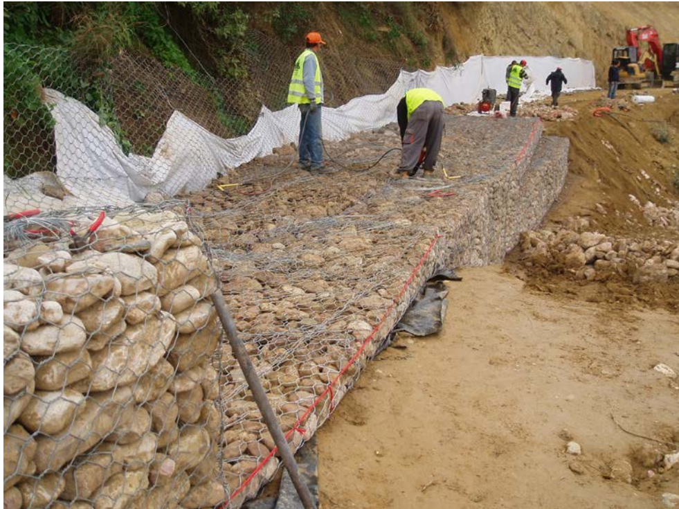
Σχήμα 5.12 Διαδικασία λιθοπλήρωσης
