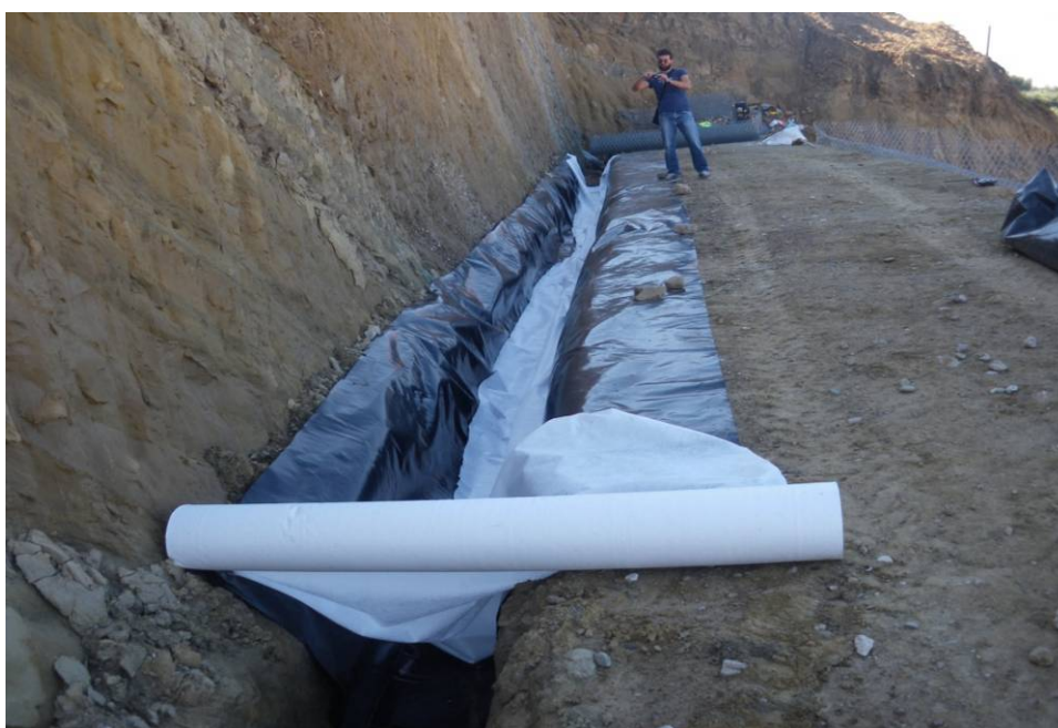
Σχήμα 3.62 Φρεάτιο επενδυμένο με γεωμεμβράνη και γεώφασμα σε ένα σημείο του έργου
