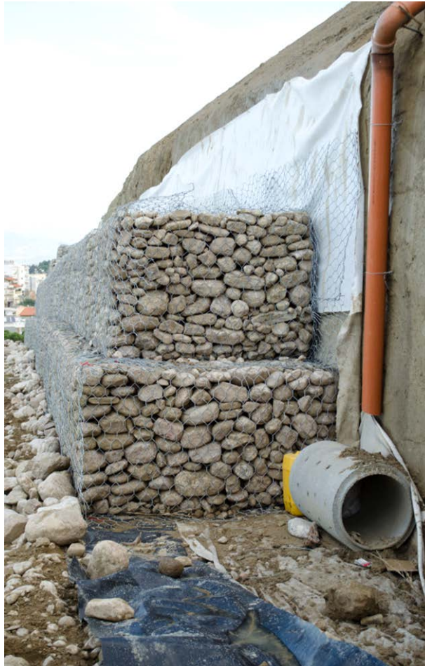
Σχήμα 5.9 Συρματοκιβώτια στην οδό Κανακάρη.
