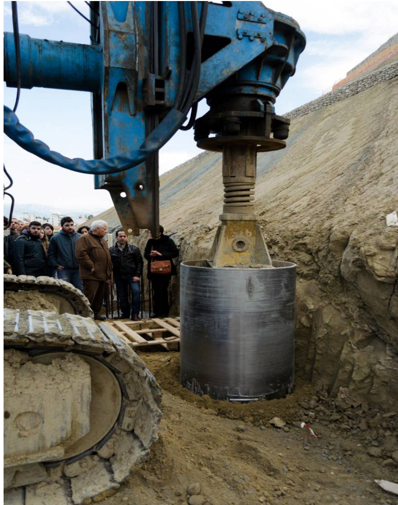
Σχήμα 3. 14 Διάτρηση του εδάφους με πασσαλομπήχτη για την διάνοιξη της οπής ώστε να μπει ο κλωβός του πασσάλου. (Στο βάθος αχνοφαίνεται η Κ. Βγενοπούλου, ο Κ. Σπηλιωτόπουλος και ο Κ. Καθρέπτας)
