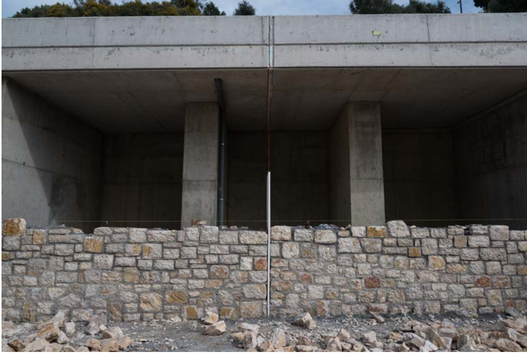
Φωτογραφία 3 Τοίχος αντιστήριξης τα κένα του οποίου θα καλυφθούν με καλοπιστικό τοίχο από πέτρα
