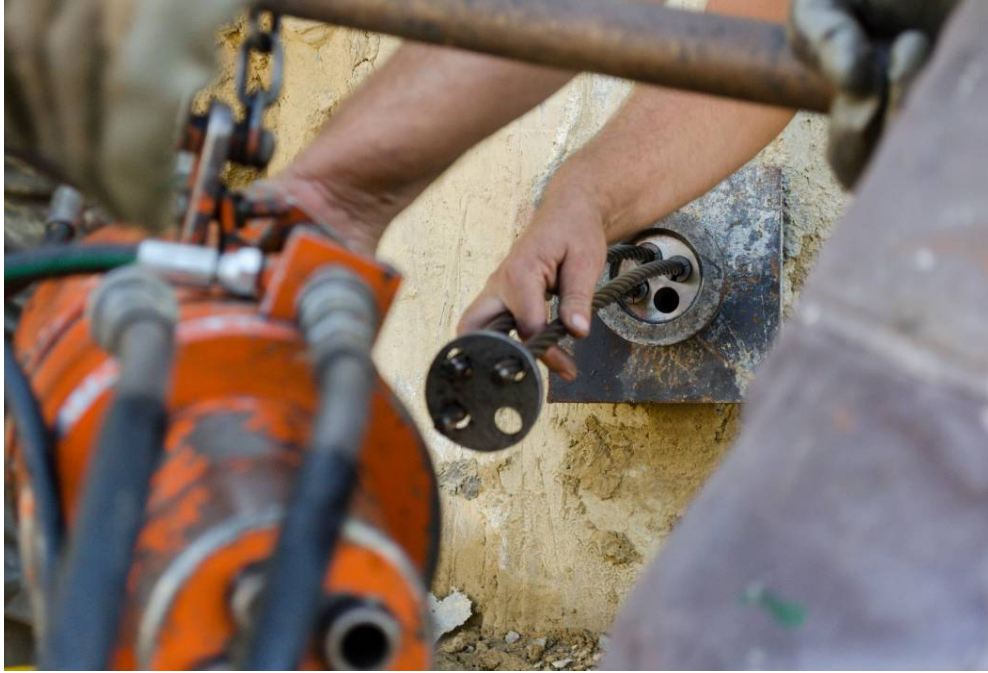
Σχήμα 3.38 Προετοιμασία τάνυσης αγκυρίου
