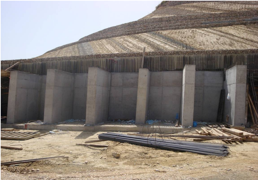
Σχήμα 3.55 Σκυροδετημένος κεφαλόδεσμος και αντηρίδες.
