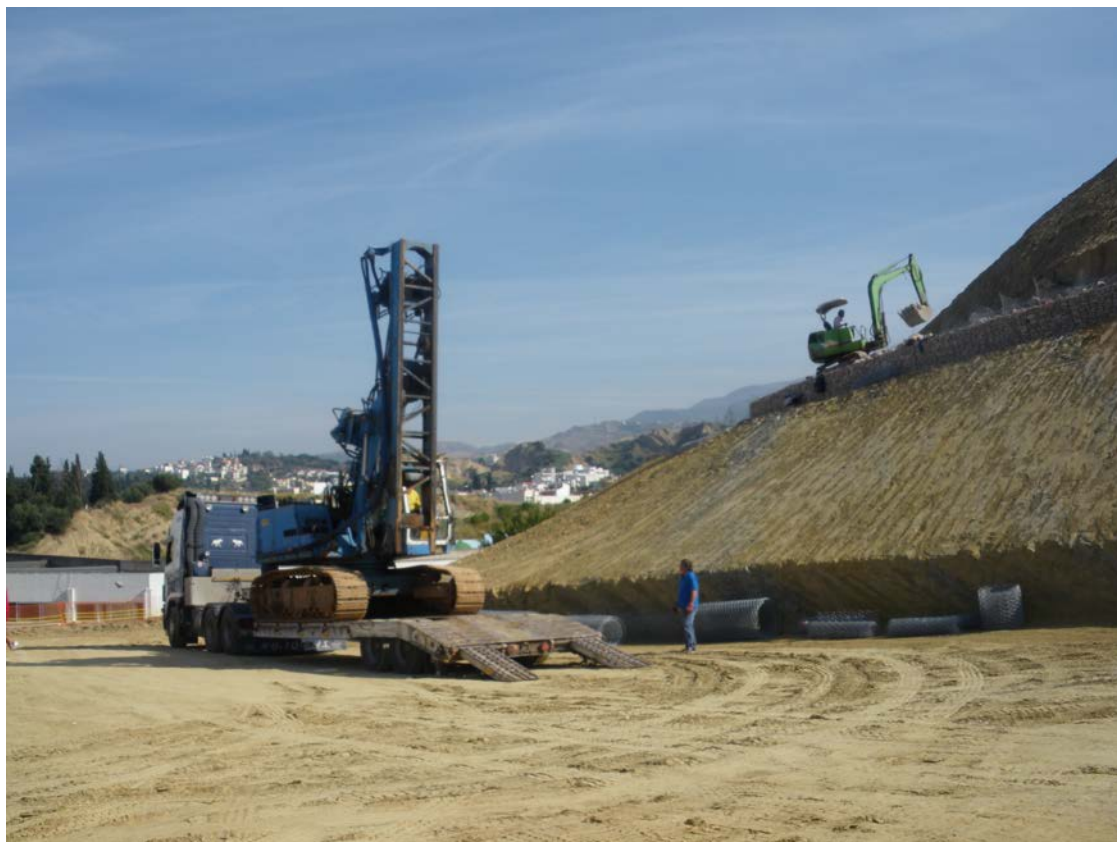
Σχήμα 3.3 Οριζοντιοποίηση του εδάφους για την διάτρηση των πασσάλων.
