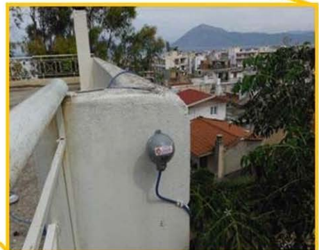
Σχήμα 4.16 Φωτογραφική άποψη της θέσης εγκατάστασης του κλισιμέτρου T-1 ( Νόρμαν-Αγ.Σοφίας, Χ.Θ. 0+274)
