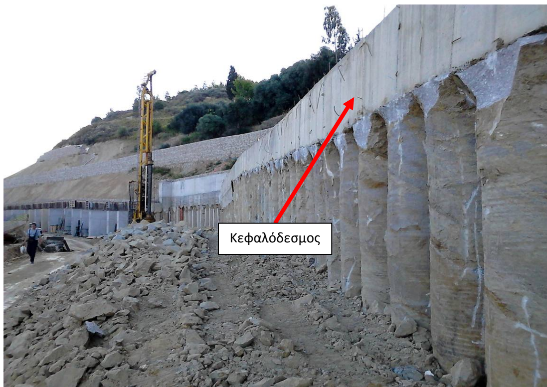
Σχήμα 3.6 Εκσκαφή εδαφών κατάντη της πασσαλοσυστοιχίας.
