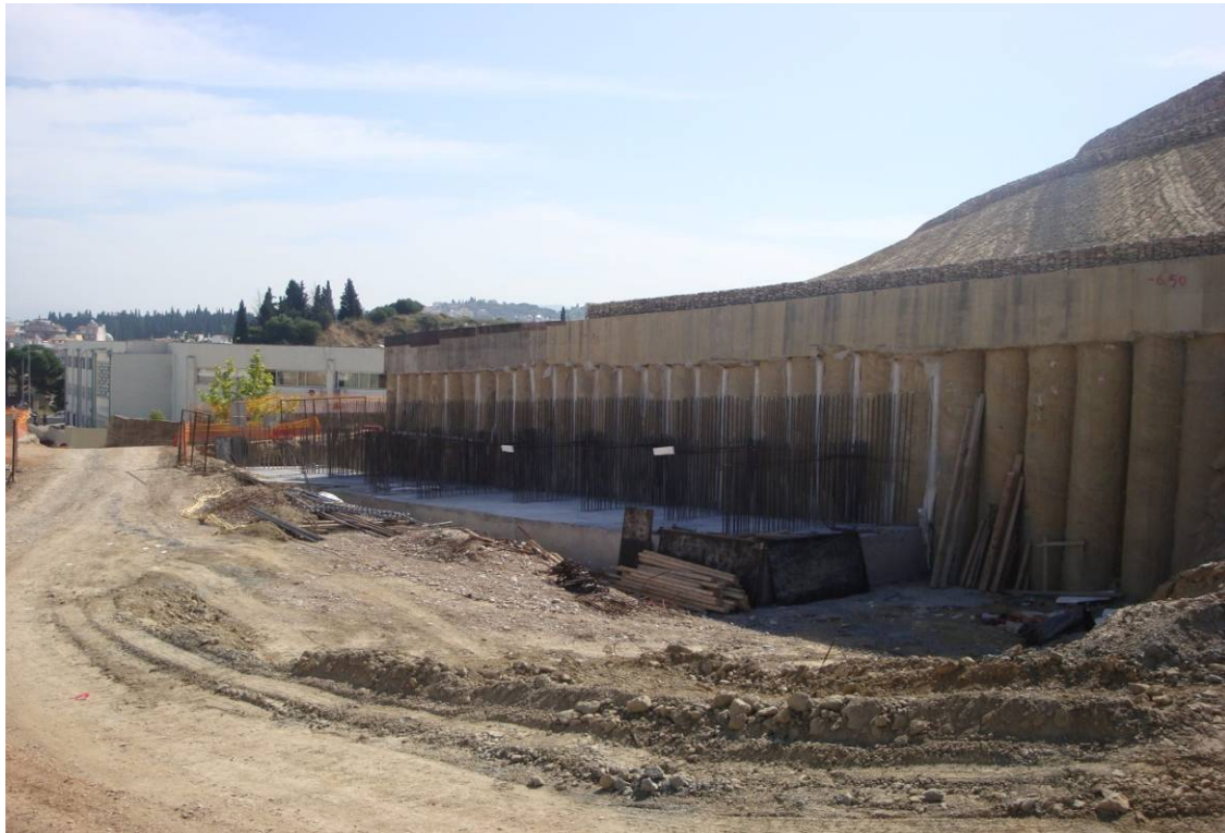
Σχήμα 3.13 Πασσαλότοιχος με ήδη κατασκευασμένο ένα κομμάτι του τοίχου αντιστήριξης.
