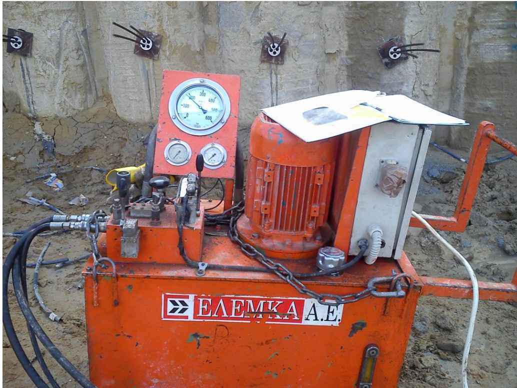
Σχήμα 3.33 Πρέσα τάνυσης
