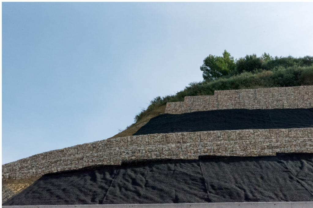
Σχήμα 5.14 Σαρζανέτ στο τμήμα 2 (Νόρμαν-Αγίας Σοφίας)
