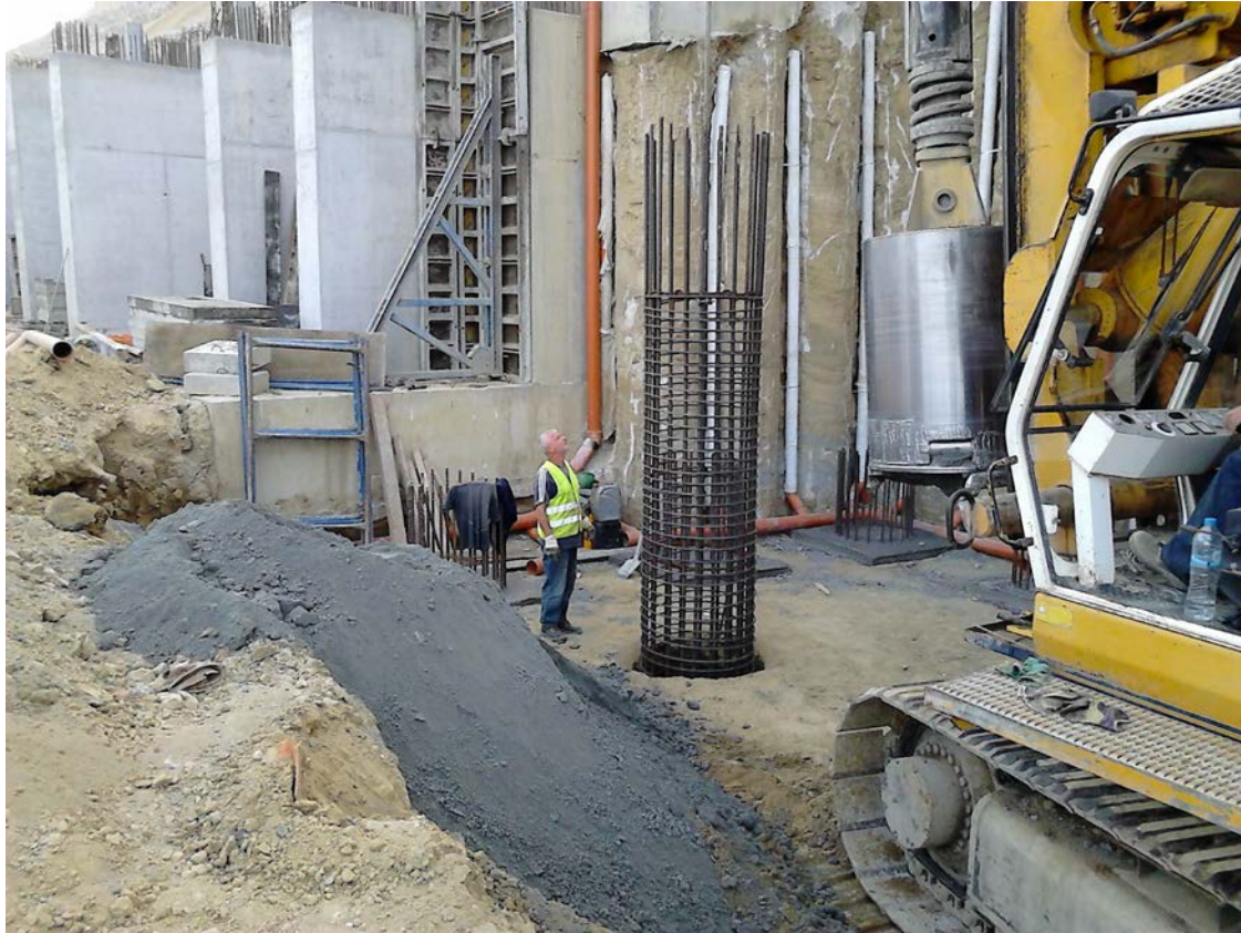
Σχήμα 3.47 Εναπόθεση του κλωβού στην οπή του πασσάλου
