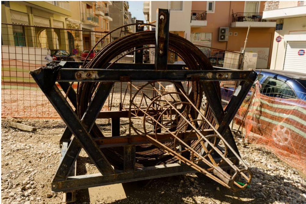
Σχήμα 3.31 Ανέμη για την κατασκευή των αγκυρίων
