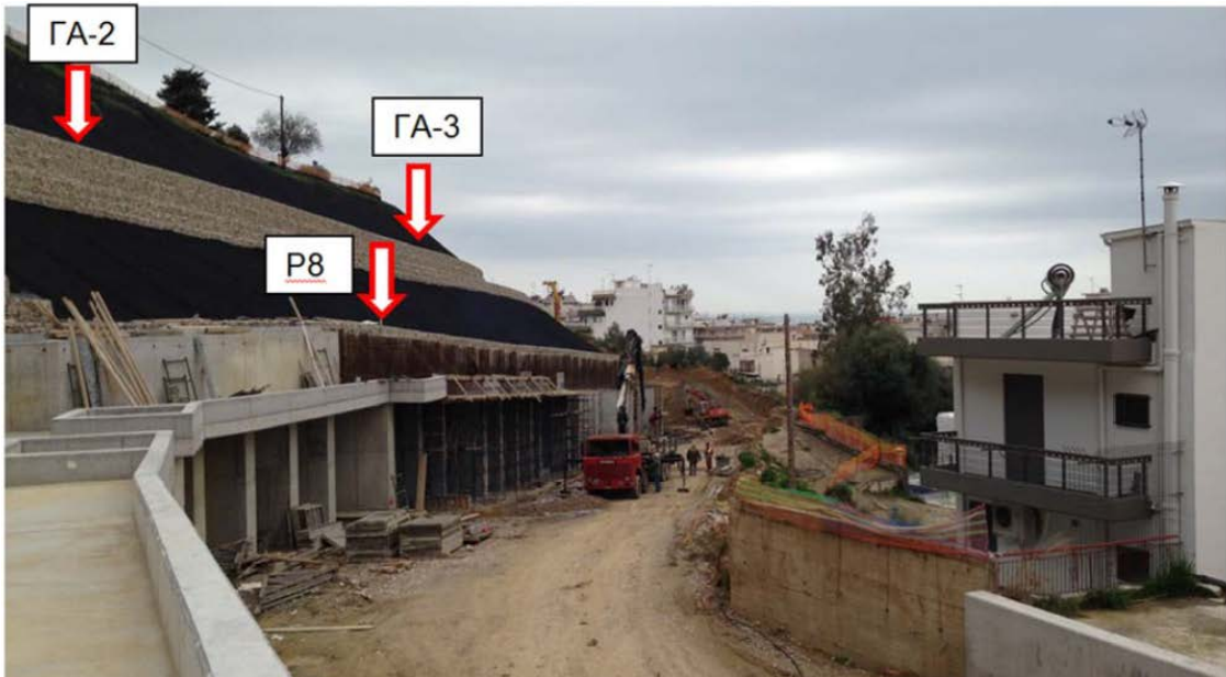
Σχήμα 4.20 Άποψη των έργων αντιστήριξης στην περιοχή των αποκλισημέτρων ΓΑ-2, ΓΑ-3 και Ρ8.
