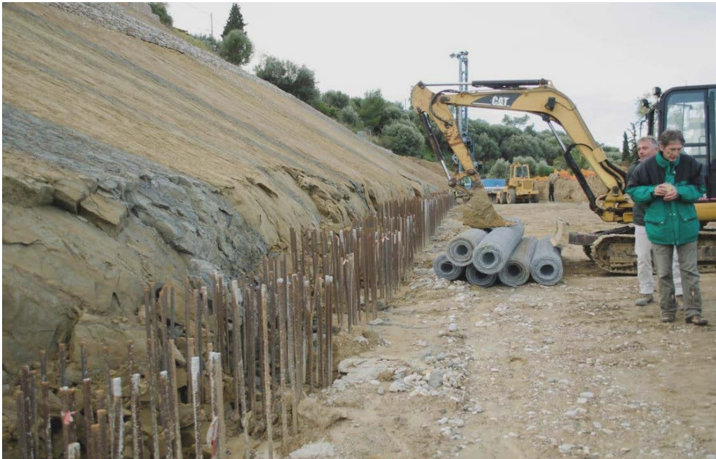
Σχήμα 3.4 Πρώτη φάση εκσκαφής με τους τένοντες των φρεατοπασσάλων να εξέρχουν από το έδαφος αφού έχει προηγηθεί η κατασκευή τους. Δεξιά είναι εμφανής ένας μικρός εκσκαφέας.
