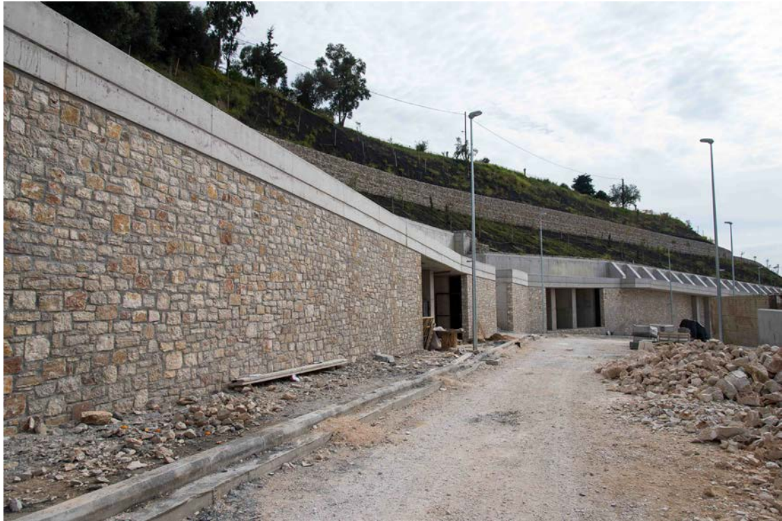
Φωτογραφία 5 Η οδός από το κατώτερο της επίπεδο
