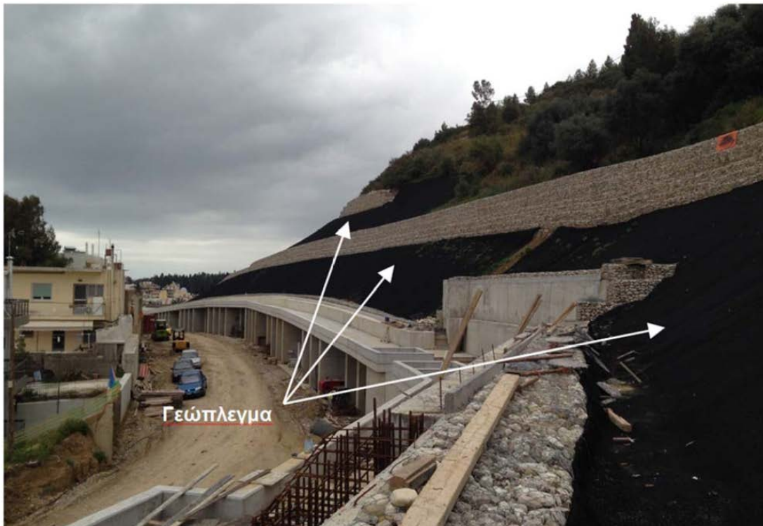
Σχήμα 5.4 Γεωπλέγματα στο έργο της οδού Κανακάρη και συγκεκριμένα στο τμήμα Νόρμαν-Αγίας Σοφίας
