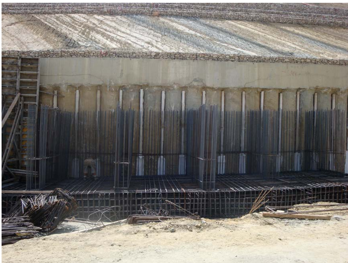
Σχήμα 3.50 Σιδερένιος σκελετός του οπλισμού του θεμελίου και των αντηρίδων.
