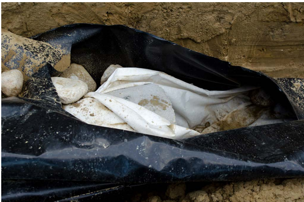
Σχήμα 3.60 Γεώφασμα (λευκό κομμάτι) και γεωμεμβράνη (μαύρο κομμάτι) πάνω από το στραγγιστήριο
