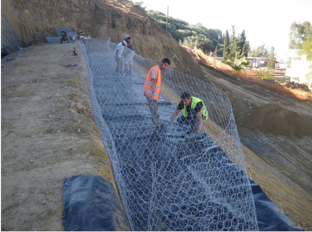
Σχήμα 5.11 Σύνθεση τετραγωνικών 'κλουβιών' επιτόπου από ειδικευμένους εργάτες
