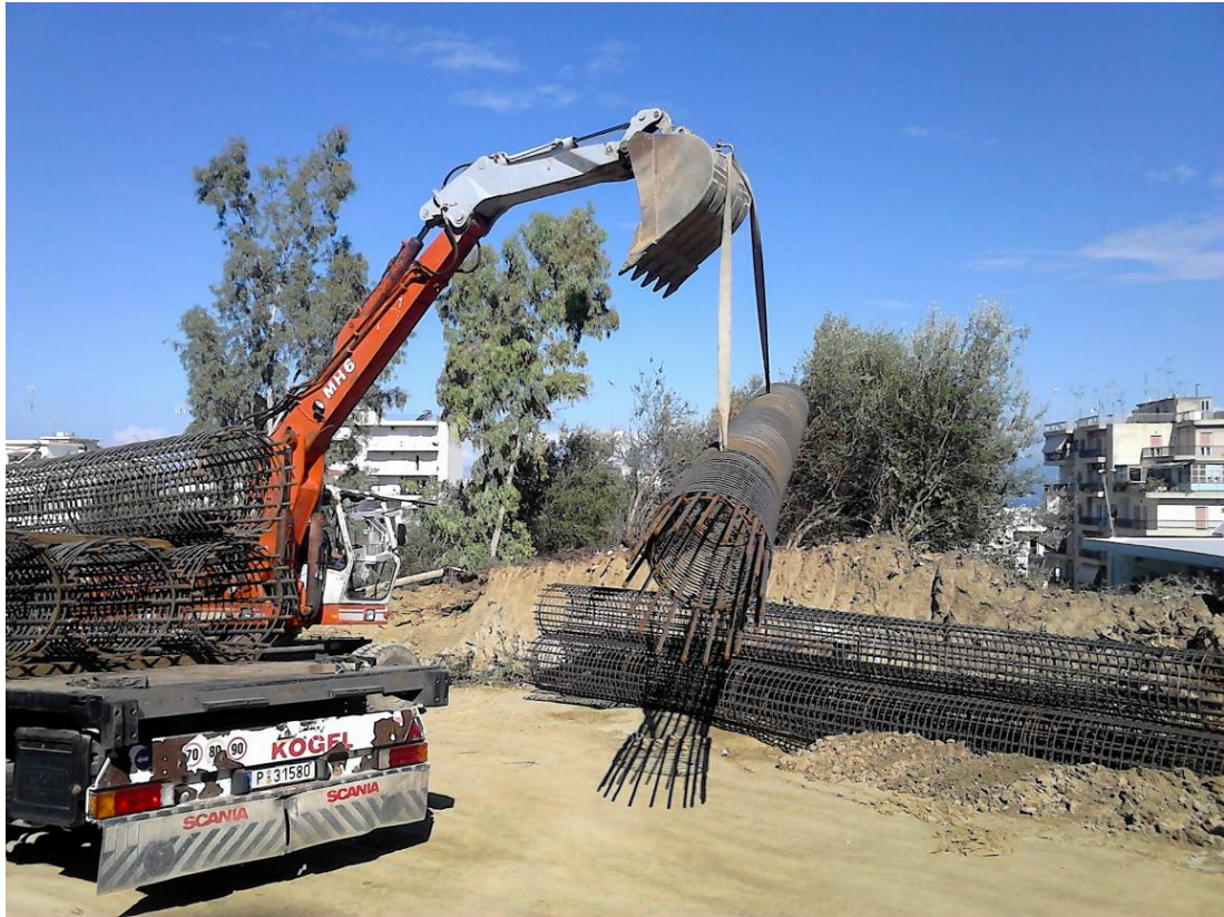
Σχήμα 3.16 Μεταφορά του κλωβού του πασσάλου στο σημείο που θα τοποθετηθεί
