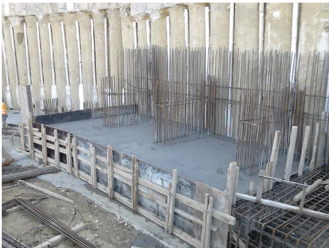
Σχήμα 3.52 Σκυροδετημένος κεφαλόδεσμος και κομμάτι του σκελετού των αντηρίδων.
