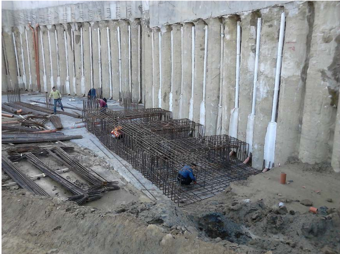
Σχήμα 3.49 Τοποθέτηση του οπλισμού του θεμελίου του τοίχου
