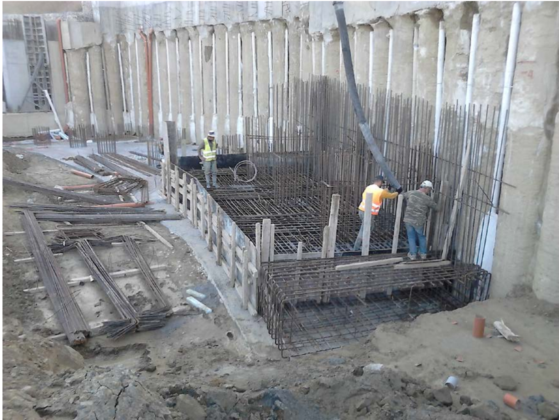
Σχήμα 3.51 Σκυροδέτηση του κεφαλόδεσμου
