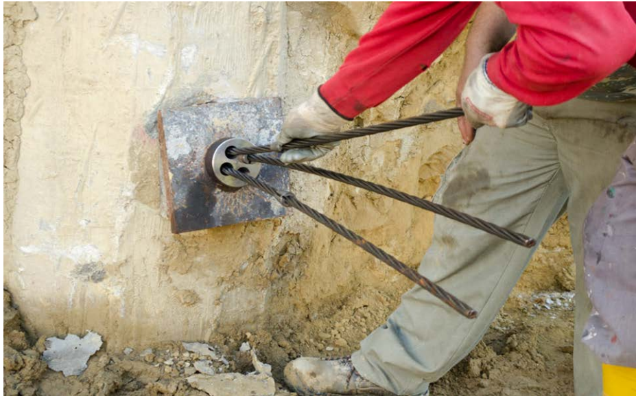
Σχήμα 3.37 Εισχώρηση των εμβόλων στο αγκύριο
