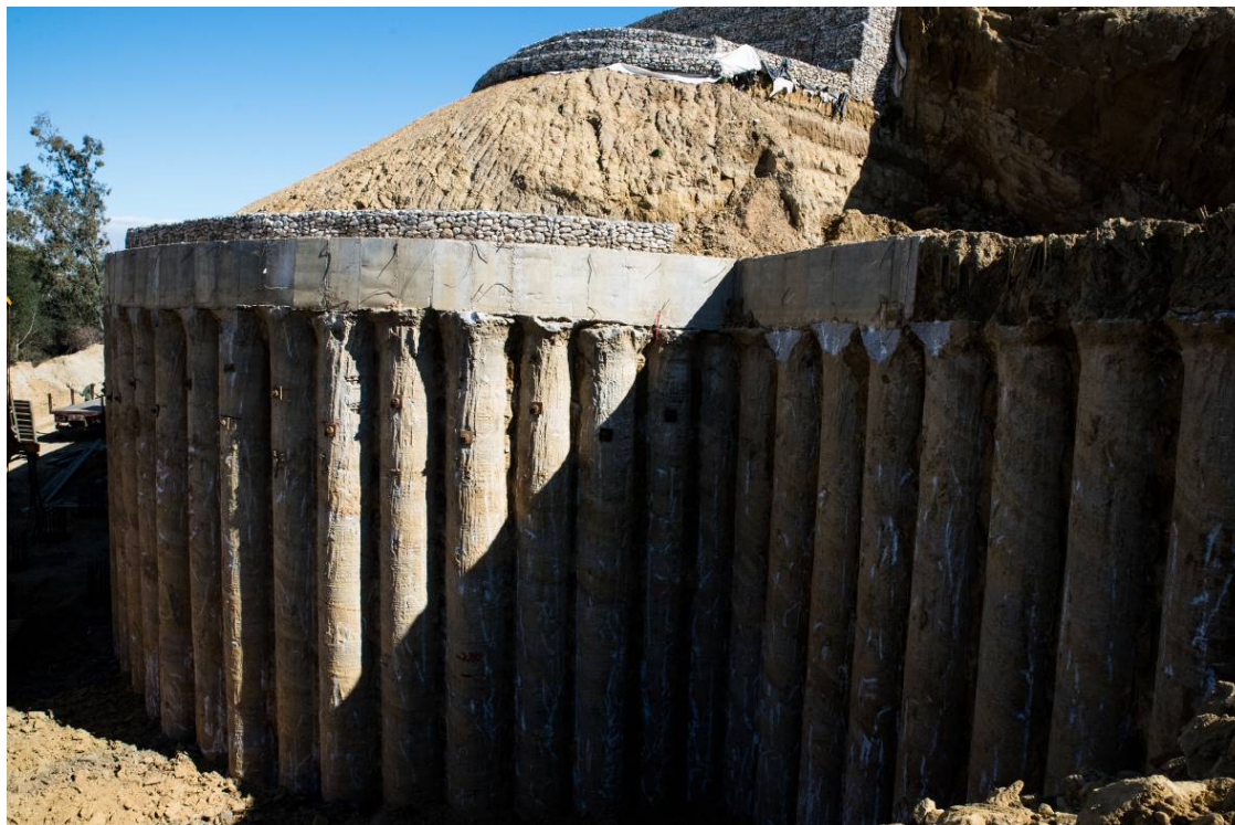
Σχήμα 3.21 Αποψη του πασσαλότοιχου με τον κεφαλόδεσμο στο τέλος του τμήματος 2.
