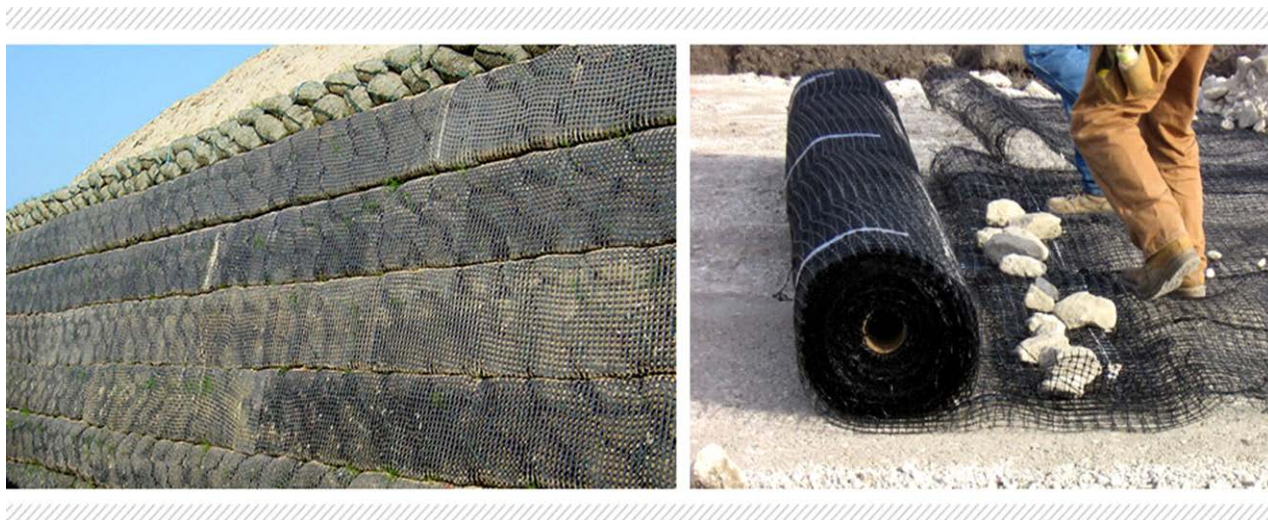
Σχήμα 5.1 Γεώπλεγμα τοποθετημένο σε έργο και ξετύλιγμα αυτού πριν την εναπόθεση.
