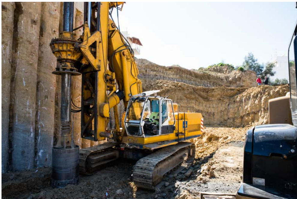
Σχήμα 3.2 Μηχάνημα διάνοιξης φρεατοπασσάλων (πασσαλομπήκτης) τύπου BAUER BG 14
