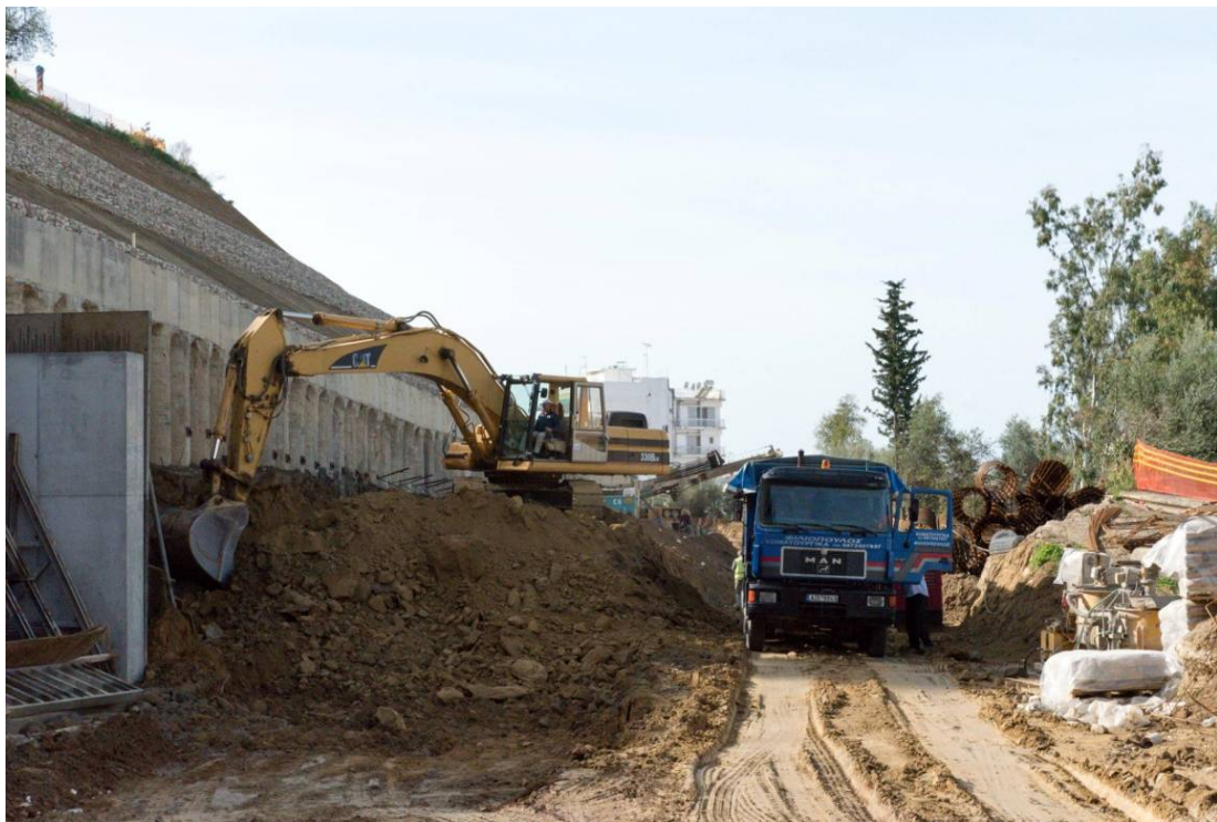
Σχήμα 3.9 Εκσκαφή μέχρι το δεύτερο επίπεδο εργασίας.
