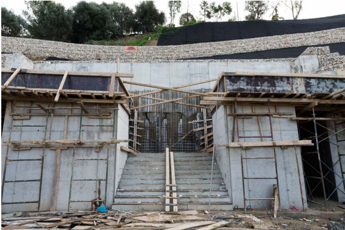
Σχήμα 3.58 Κατασκευή κλιμακοστάσιου σε ένα σημείο του τμήματος 2 της οδού.
