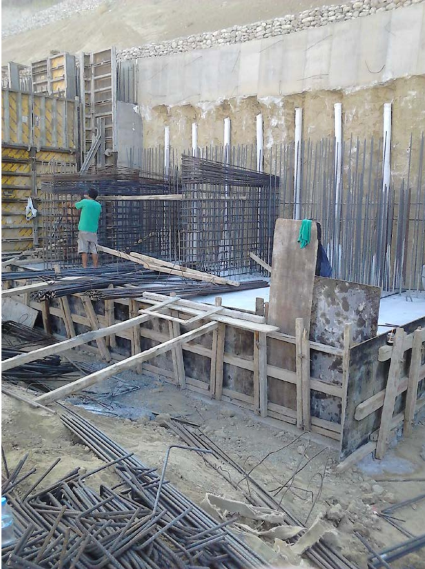
Σχήμα 3.54 Betoform και ξυλότυπος
