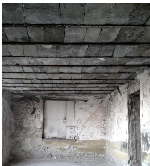
Εικόνα 28. Οροφή υπογείου από μαλτεζόπλακες
