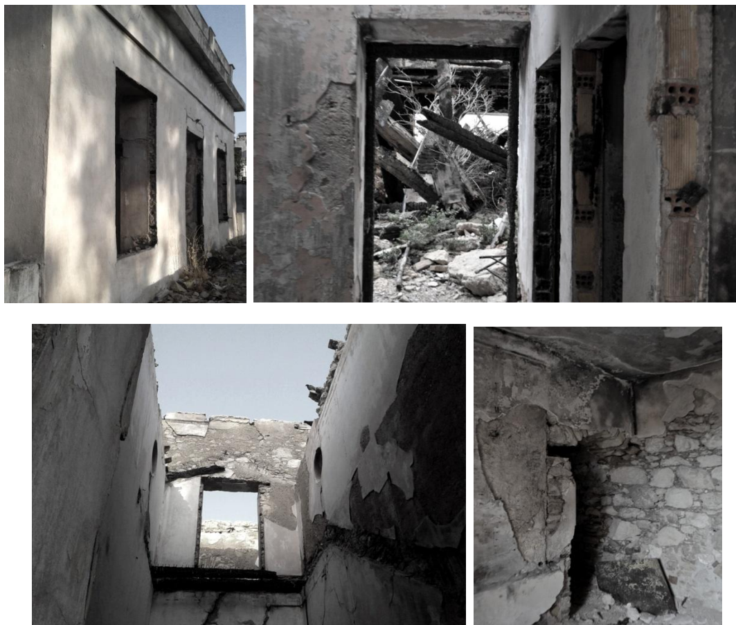
Εικόνες 18 – 21. Φέρον οργανισμός Κτηρίου Α
