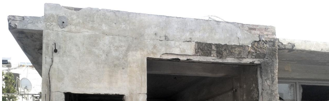
Εικόνα 75. Πλάκα δώματος νεότερου κτηρίου από οπλισμένο σκυρόδεμα
