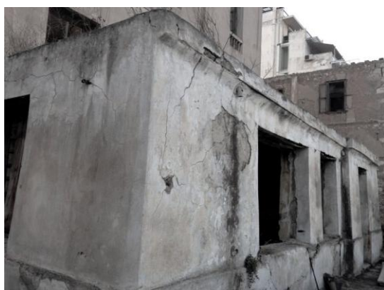
Εικόνες 65 – 66. Ρηγματώσεις και graffiti στα επιχρίσματα του παλαιότερου στηρίου
