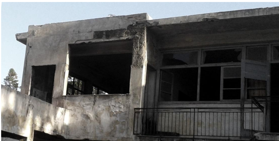
Εικόνα 34. Δώμα από οπλισμένο σκυρόδεμα
