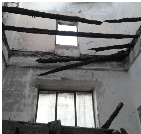
Εικόνα 29. Πατώματα από ξύλινα δοκάρια και μεσοδόκαρα
