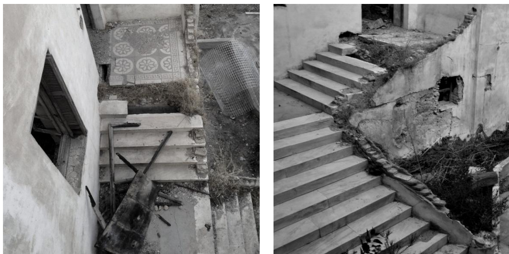
Εικόνες 76 – 77. Κυκλική κλίμακα με κατεστραμένο στηθαίο και μαρμάρινα πατήματα
