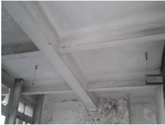
Εικόνα 30. Δοκιδωτή πλάκα στην οροφή του ισογείου
