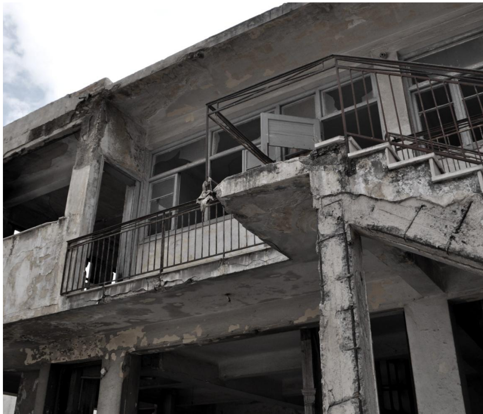
Εικόνες 22 – 24. Φέρον οργανισμός Κτηρίου Β
