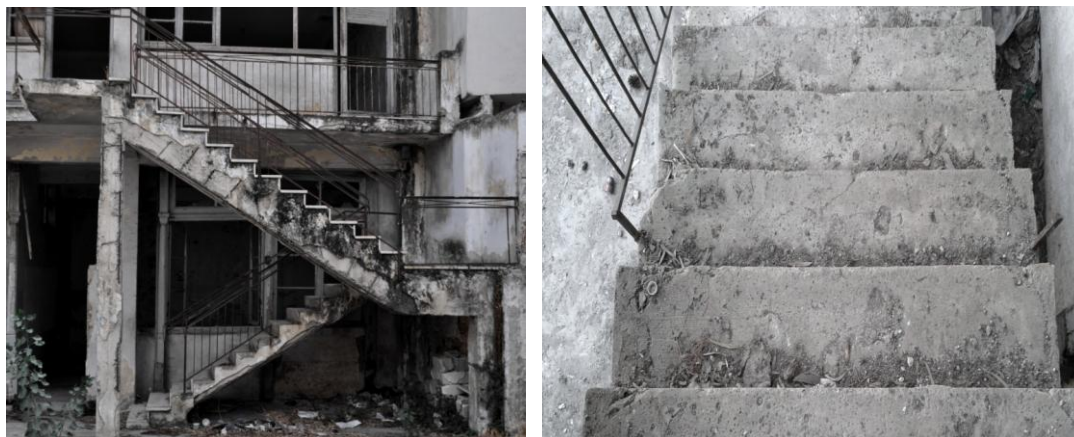
Εικόνες 82 – 83. Εξωτερική κλίμακα νεότερου κτηρίου
