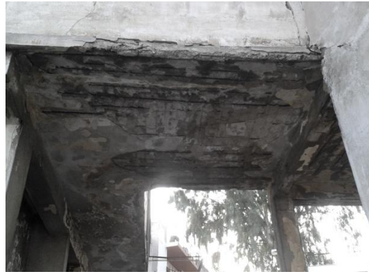
Εικόνα 31. Πλάκα από σπλισμένο σκυρόδεμα
