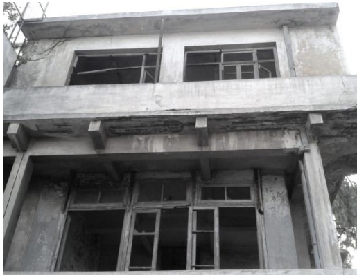
Εικόνες 84 – 87. Σφραγισμένα με οπτόπλινθους και ευτελή υλικά τα ανοίγματα του διατηρητέου κτηρίου και κατεστραμμένα κουφώματα με σπασμένους υαλοπίνακες στο κτήριο της προσθήκης
