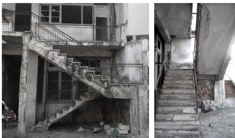
Εικόνες 38 -39. Εξωτερική κλίμακα από οπλισμένο σκυρόδεμα στο κτήριο της προσθήκης
