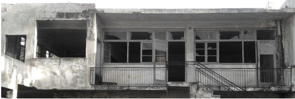
Εικόνα 50. Ανοίγματα ορόφου στο κτήριο της προσθήκης
