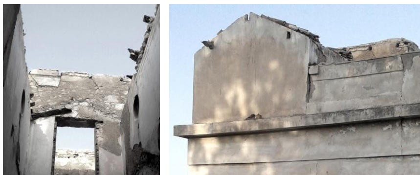
Εικόνες 73 – 74. Δίρριχτη στέγη του διατηρητέου κτίσματος
