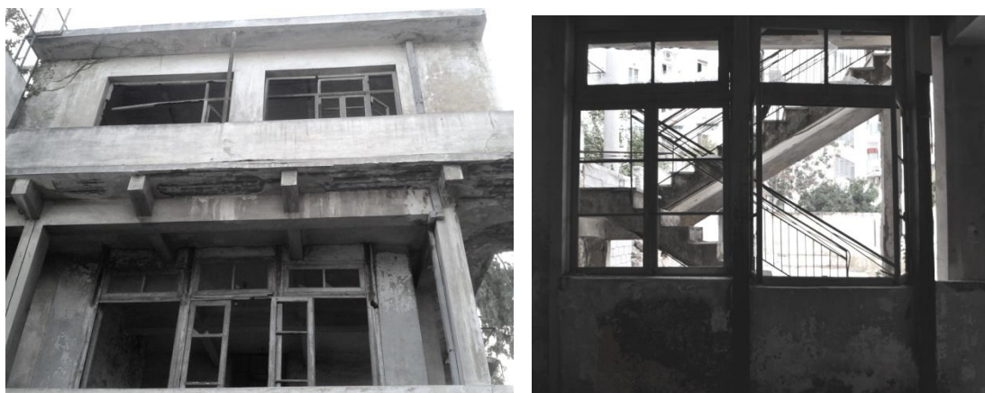
Εικόνες 48 – 49. Εξωτερικά ανοίγματα νεότερου κτηρίου
