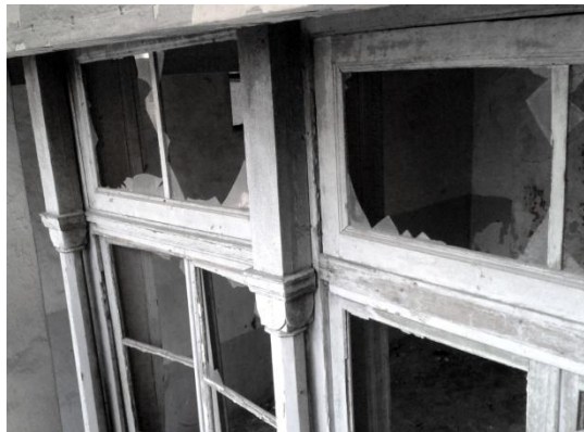
Εικόνες 84 – 87. Σφραγισμένα με οπτόπλινθους και ευτελή υλικά τα ανοίγματα του διατηρητέου κτηρίου και κατεστραμμένα κουφώματα με σπασμένους υαλοπίνακες στο κτήριο της προσθήκης
