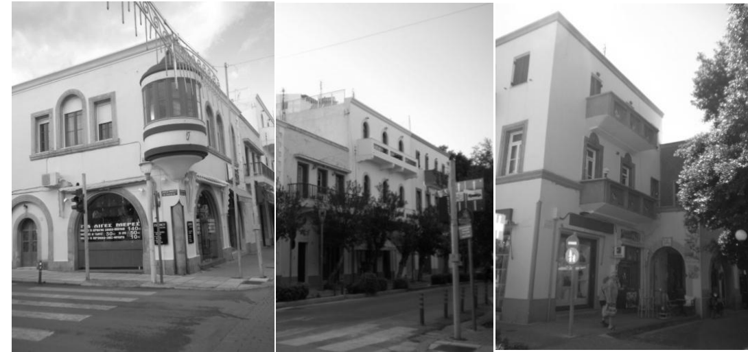
Εικόνα 194. Τμήμα 1, 482 2,3, και 4. 483 Παρατηρήσεις: Το τμήμα 1 βρίσκεται στη γωνία του οικοδομικού τετραγώνου έτσι παρουσιάζει το σύνθημα γνώρισμα της δημιουργίας καμπύλης στη γωνία του κτίσματος που είναι εκτεθειμένη. Αυτό δημιουργείται με την κατασκευή κυλινδρικού εξώστη που ενισχύει το εξωτερικό στοιχείο με τη μορφολογία του. Στα τμήματα 3 και 4 έχει γίνει προσθήκη δεύτερου ορόφου αλλά η μορφολογία δεν έχει υποστεί περαιτέρω αλλοιώσεις και έτσι το παραθέτουμε κατ' εξαίρεση.
