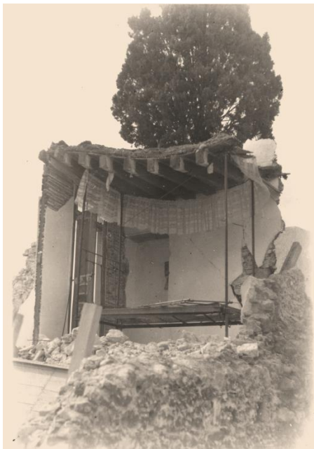
Εικόνα 54, Η νότια πλευρά της οδού Μιαούλη, μπορεί κανείς να διακρίνει τα πέταβρα και τα κορφόδια στα τμήματα των δωματίων που έχουν καταρρεύσει. 271
