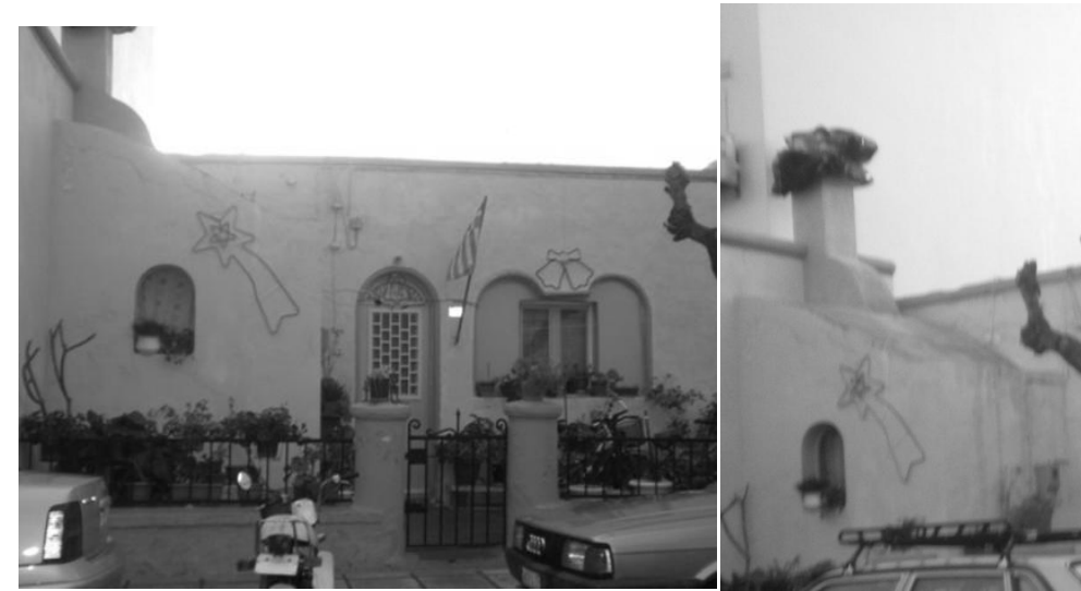
Εικόνα 100 και 101. 402 Η κατοικία βρίσκεται επί της Αλικαρνασσού (μεταξύ των οδών Βερροιοπούλου και Κύπρου) και παρουσιάζει συνεχές σύστημα δόμησης με κατοικία που έχει υποστεί επεμβάσεις. Η κάτοψη διαμορφώνεται σε σχήμα Γ, με τον χώρο w.c. να προεξέχει στην πρόσοψη. Το άνοιγμα αυτού του χώρου είναι μικρότερο και, χαρακτηριστικά, ο χώρος διαθέτει και εξαιρεισμό ο οποίος διακρίνεται. Τα ανοίγματα διαθέτουν, όλα, ημικυκλικές απολήξεις.
