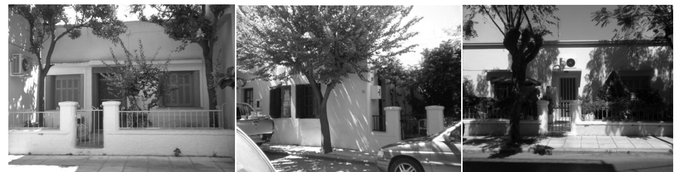
Εικόνα 113,114 και 8. 410 Κοινό χαρακτηριστικό ο τρόπος διαμόρφωσης της περίφραξης , τα ορθογωνικά ανοίγματα και οι διακοσμητικές οριζόντιες ζώνες στην απόληξη του κτιρίου. Παρατηρείται η δημιουργία στοιχειώδους στεγάστρου στ 1 ο και το 3 ο
