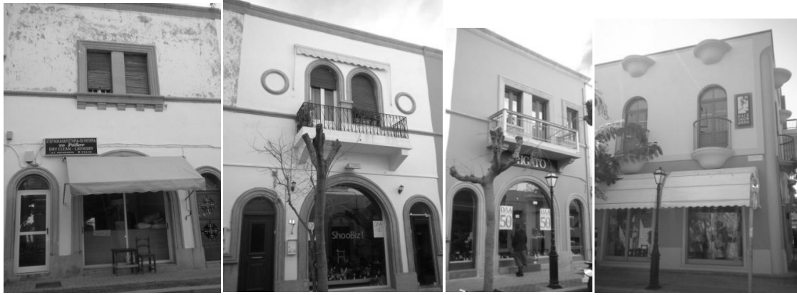
Εικόνα 192. Τμήμα 9,10,11 και 12. 479 Παρατηρήσεις: Στο ισόγειο έχουμε την ίδια συμμετρική διάταξη ανοιγμάτων με ημικυκλικές απολήξεις (τμ. 9,10,11) και στον όροφο υπάρχει εναλλαγή των αυστηρών ορθογώνιων σχημάτων με καμπύλες. Το τμήμα 12 που τοποθετείται στην γωνία του οικοδομικού τετραγώνου παρουσιάζει πιο επιμελημένο διάκοσμο. 480
