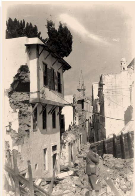
Εικόνα 54, Η νότια πλευρά της οδού Μιαούλη, μπορεί κανείς να διακρίνει τα πέταβρα και τα κορφόδια στα τμήματα των δωματίων που έχουν καταρρεύσει. 271
