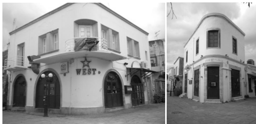
Εικόνα 21. Τμήμα 1 και 2. 465 Παρατηρήσεις: Οι ακμές αποφεύγονται και το τμήμα 1 παρουσιάζει κάμψη, στο σημείο τομής των δύο πλευρών, ενώ το τμήμα 2 αναπτύσσεται υπό γωνία (στρέψη όλης της κάτοψης).
