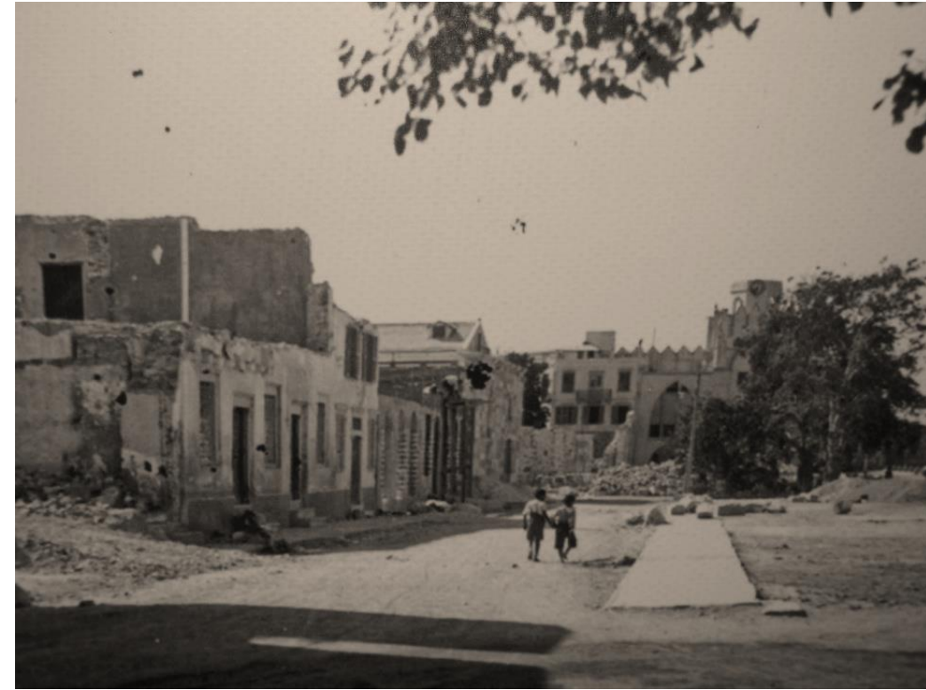
Εικόνα 52. Τα κτίσματα επί της οδού Μιαούλη , αριστερά του διοικητηρίου, είναι εμφανές το μέγεθος των ζημιών που υπέστησαν από το σεισμό. 269
