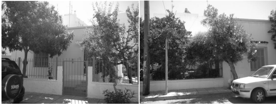
Εικόνα 9 και 117. 411 Τα κτίσματα παρουσιάζουν ορθογωνικά ανοίγματα και κάτοψη σχήματος Γ. Τα τοιχεία της περίφραξης είναι πιο απλοϊκά διαμορφωμένα και παρατηρείται η χαρακτηριστική οριζόντια ζώνη που διατρέχει το δώμα. 412
