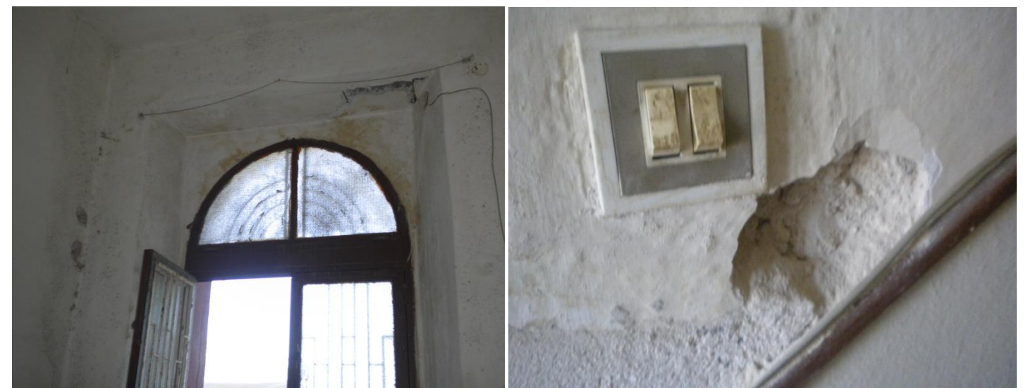
Εικόνα 35. Ανάπτυγμα Παθολογίας χώρου 122.
