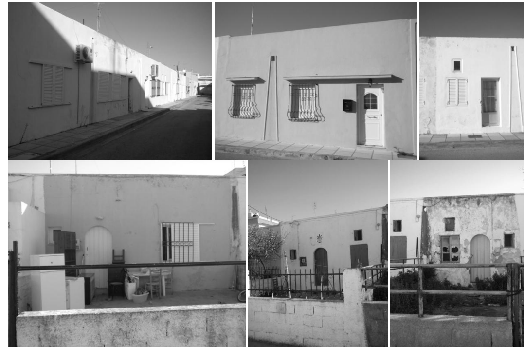
Εικόνα 287-292. 573 Το τμήμα που υφίστανται έως σήμερα έχει υποστεί πολλές επεμβάσεις. Παραθέτουμε ενδεικτικά τα καλύτερα διατηρημένα στην αρχική μορφή. Παρουσιάζουν ορθογώνιες κατόψεις, μικρό καθαρό ύψος και συνεχές σύστημα δόμησης. Τα ανοίγματα είναι ορθογώνια και η εξώθυρα της πίσω όψης, που οδηγεί σε μικρό κήπο, έχει ημικυκλική απόληξη. Τα μικρά
