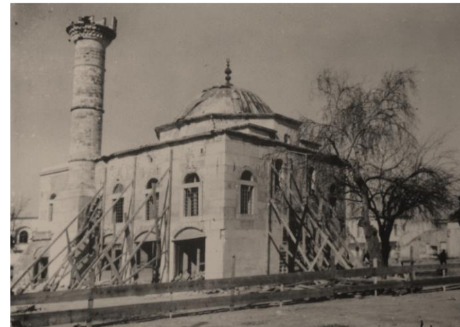
Εικόνα 58. Το τζαμί Defterdar υπέστη και αυτό όπως και όλα τα άλλα μουσουλμανικά και ελληνικά κτίσματα ζημιές από το σεισμό, στη φωτογραφία βλέπουμε την προσπάθεια επιδιόρθωσης των ζημιών του από τους Ιταλούς. 275
