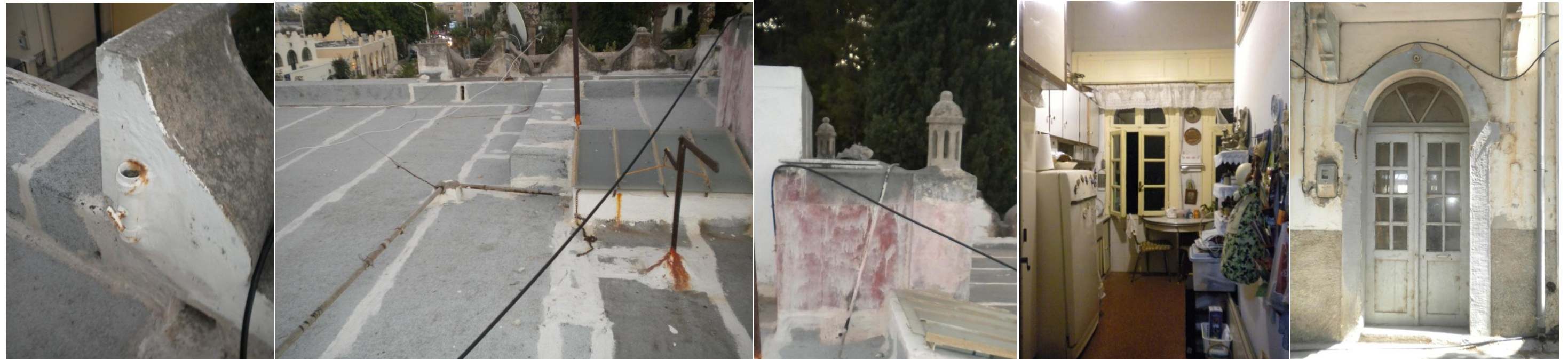
Εικόνα 10. 8 Υδρορροή, Τμήμα 1, Δ.1. Εικόνα 11. 9 Υπάρχουσα κατάσταση δώματος(Δ.1). Εικόνα 12. 10 Δεξαμενή νερού, Δ.1. Εικόνα 13 11 . Διατηρημένο κούφωμα παραθύρου (χώρος κουζίνας, Δ.1.) Εικόνα 14. 12 Κούφωμα εξωτερικής θύρας που διατηρείται(Δυτική όψη, Κ.4.).
