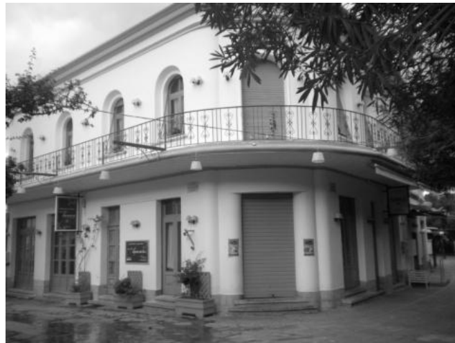
Εικόνα181. Τμήμα 1, 2 και 3. 464 Παρατηρήσεις: Στο τμήμα 1 έχουμε το στοιχείο ανάπτυξης υπό γωνία. Στο τμήμα 2 και 3, τα στέγαστρα αποτελούν προσθήκη.
