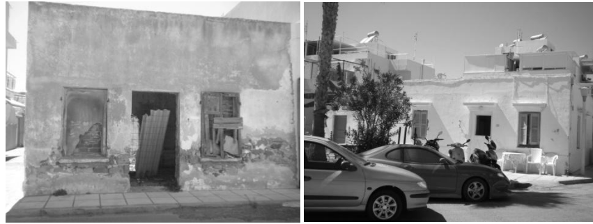
Εικόνα 85. 391 Στην περιοχή αυτή έχουν διασωθεί μόνο αυτά τα παραδείγματα. Πλήρως απλουστευμένη τυπολογία και μορφολογία. Ίδια αναλογία ανοιγμάτων. Συμμετρική διαμόρφωση ανοιγμάτων.
