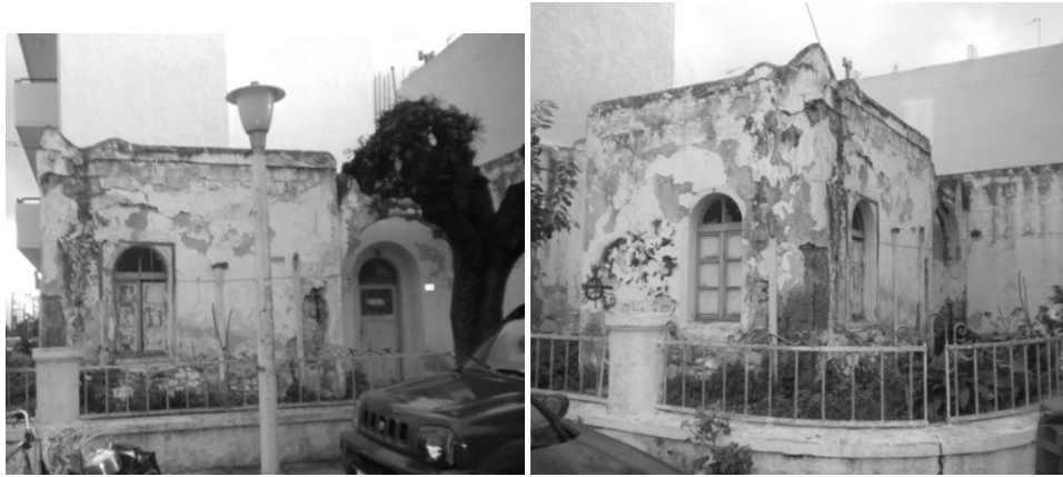
Εικόνα 93 395 . Διαμόρφωση κάτοψης σε σχήμα Γ. Τοποθετείται στην γωνία του οικοδομικού τετραγώνου και η περίφραξη παρουσιάζει μια κάμψη για αποφυγή της δημιουργίας γωνιάς 396
