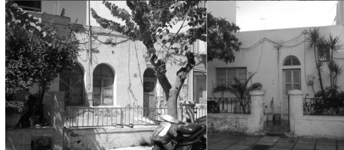
Εικόνα 3, 88,4 και 90. 393 Διατηρούνται σε άριστη κατάσταση (όσον αφορά την έλλειψη επεμβάσεων και άρα τη διατήρηση της αυθεντικής μορφής). Διακρίνουμε την ορθογωνική ανάπτυξη των ανοιγμάτων με ημικυκλικές απολήξεις. Δεν διαθέτουν διάκοσμο (ο τρόπος ανάπτυξης των ανοιγμάτων είναι το μόνο στοιχείο που διαμορφώνει τις όψεις.) Τα μικρά ανοίγματα αντιστοιχούν σε χώρους w.c., η μορφολογία αναπτύσσεται με βάση την εξυπηρέτηση της τυπολογίας. Ο χαρακτήρας του μοντερνισμού συνδυάζεται, εδώ, με παραδοσιακά στοιχεία (πλαστικότητα χαμηλής περιφραξης, καμπύλες απολήξεις ανοιγμάτων).
