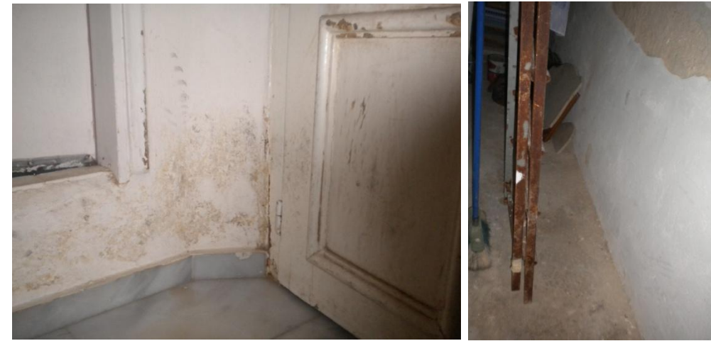
Εικόνα 53. Αποσάθρωση και Ανάπτυξη μικροοργανισμών(χώρος 020). Εικόνα 54. Αποσάθρωση και αποκόλληση επιχρίσματος(χώρος 033).
