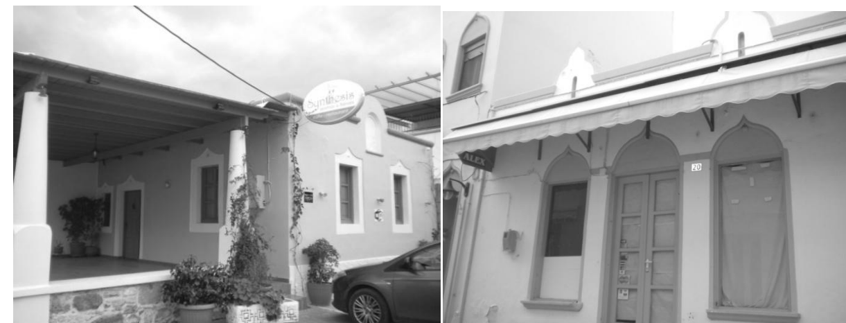
Εικόνα 11 και 132. 426 Ο αυξημένος διάκοσμος αλλά και η χρήση μεγαλύτερων αναλογικά ανοιγμάτων από ότι στα casa di porolare κατατάσσει τις κατοικίες αυτές στις αστικές. Βρίσκονται στην συνοικία Χαλουβαζιά 427 , που αποτελεί και την πλησιέστερη στο
