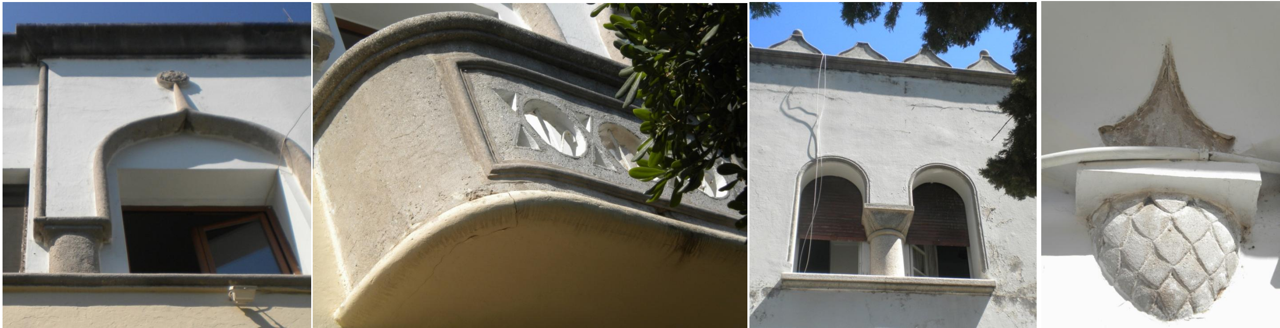
Εικόνα 23. 22 Απόσπασμα διακόσμου Ανατολικής Όψης, Δ.4. Εικόνα 24. 23 Διάκοσμος ανατολικού εξώστη, Δ.4. Εικόνα 25. 24 Διαμόρφωση διακόσμου με κίονα και ημικυκλικής απόληξης ανοίγματα περιγεγραμμένο με ζώνη κυκλικής διατομής. Απόσπασμα από την κυματοειδή στέψη. Δυτική όψη, Δ.1. Εικόνα 26. 25 Λεπτομέρεια διακόσμου τμήματος προεξοχής Α ορόφου στην Νότια Όψη, Δ.1.
