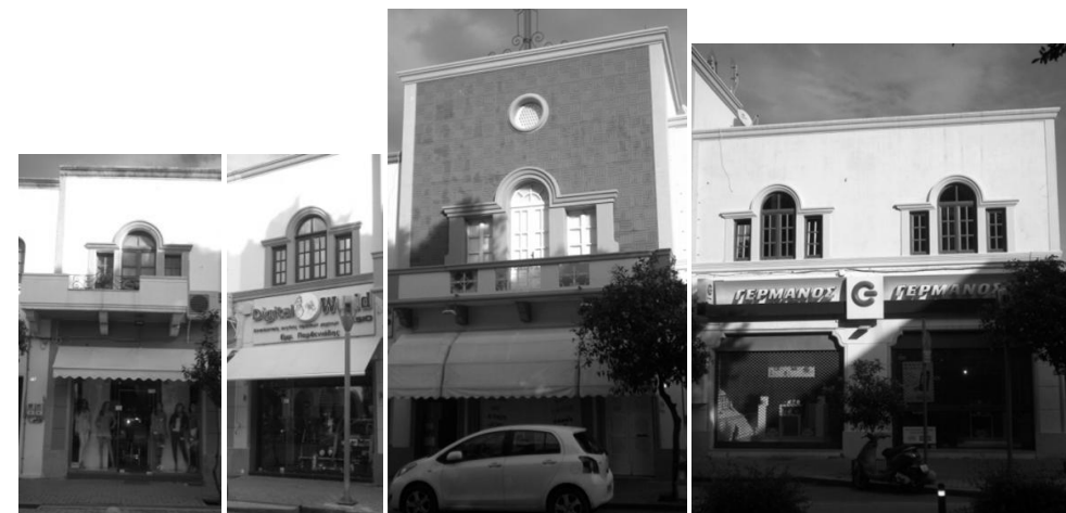
Εικόνα 190. Τμήμα 3,4,5 και 6 477 (επί της Ιπποκράτους). Παρατηρήσεις: Εμφανίζουν όμοια μορφολογική ανάπτυξη ανοιγμάτων και διακόσμου. Το τμήμα 5 αναπτύσσεται σε μεγαλύτερο ύψος και κοσμείται με διακοσμητικό μοτίβο αραβουργικών καταβολών.
