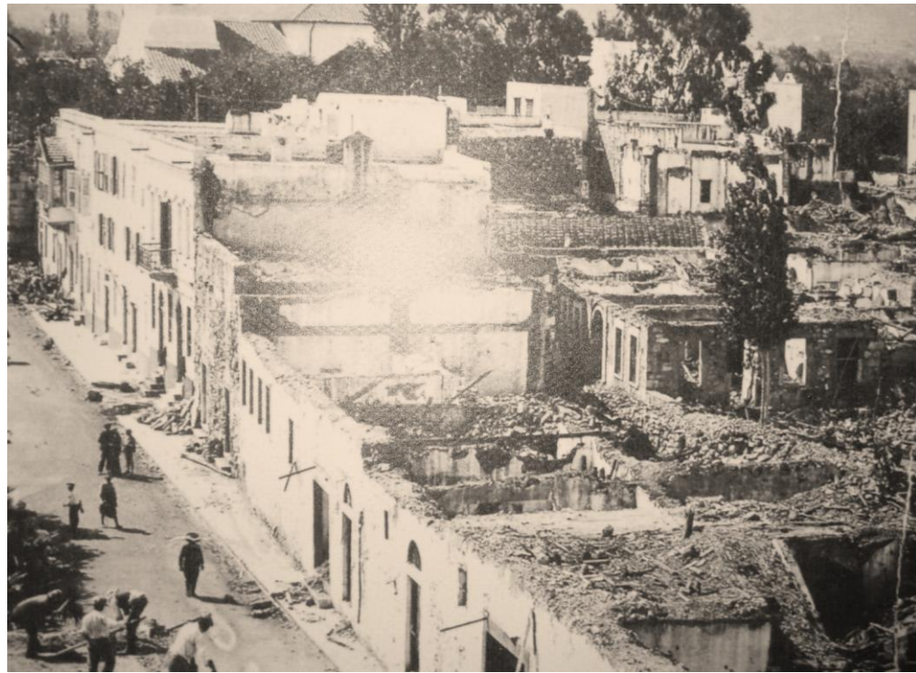
Εικόνα 54, Η νότια πλευρά της οδού Μιαούλη, μπορεί κανείς να διακρίνει τα πέταβρα και τα κορφόδια στα τμήματα των δωματίων που έχουν καταρρεύσει. 271
