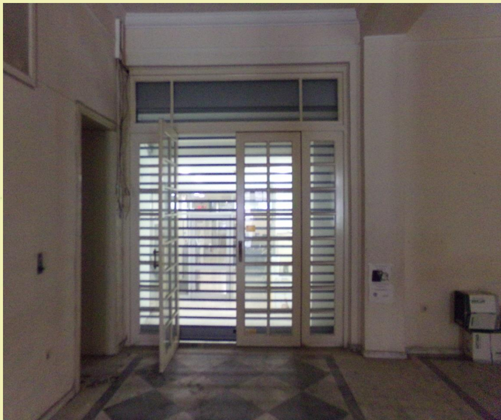
Εικόνα 17: Η ξύλινη aller retour θύρα της ανατολικής πλευράς.
