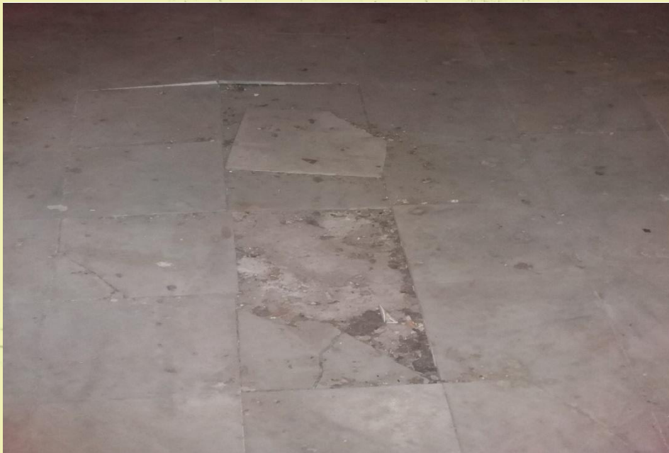
Εικόνα 37: Τα αποκολλημένα μαρμάρια πλακίδια στο σημείο του προθαλάμου.
