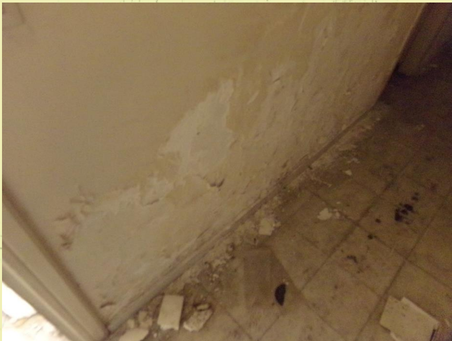
Εικόνα 22: Αποφλοίωση του χρώματος και αποσάθρωση του επιχρίσματος της διαχωριστικής τοιχοποιίας των λουτρών.
