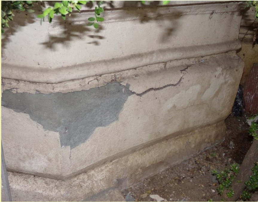
Εικόνα 64: Αποσάθρωση της πλάκας και απολέπιση του λίθου.
