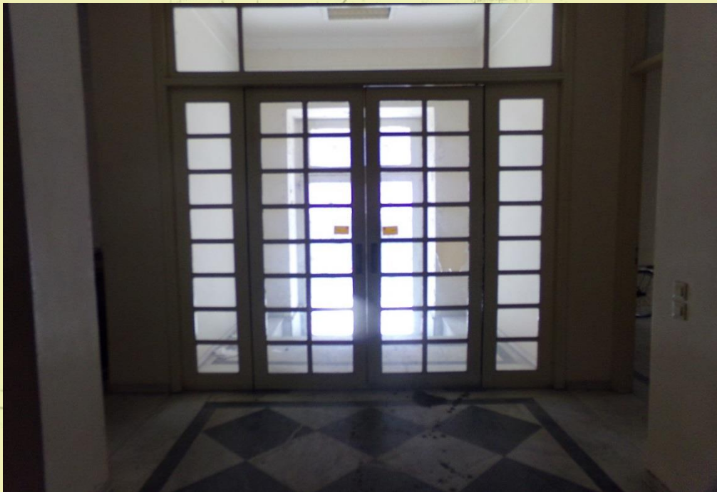
Εικόνα 10: Η ξύλινη aller retour θύρα που διαχωρίζει τον προθάλαμο της κεντρικής εισόδου από το ισόγειο.
