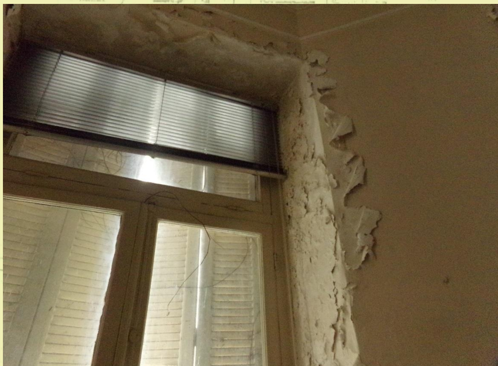
Εικόνα 14: Το νότιο άνοιγμα του έρκουρ παρουσιάζει αποφλοίωση και ζαχαροειδή φθορά
