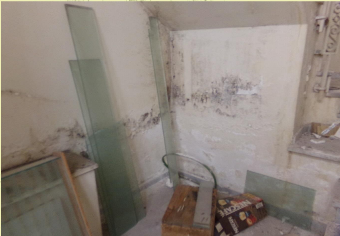
Εικόνα 26: Αποσάφηση του επιγυρίματος, μούχλα και αποχρωματισμός και αποφλοίωση της επιφάνειας κάτω από τον ουρανό της κλίμακας.
