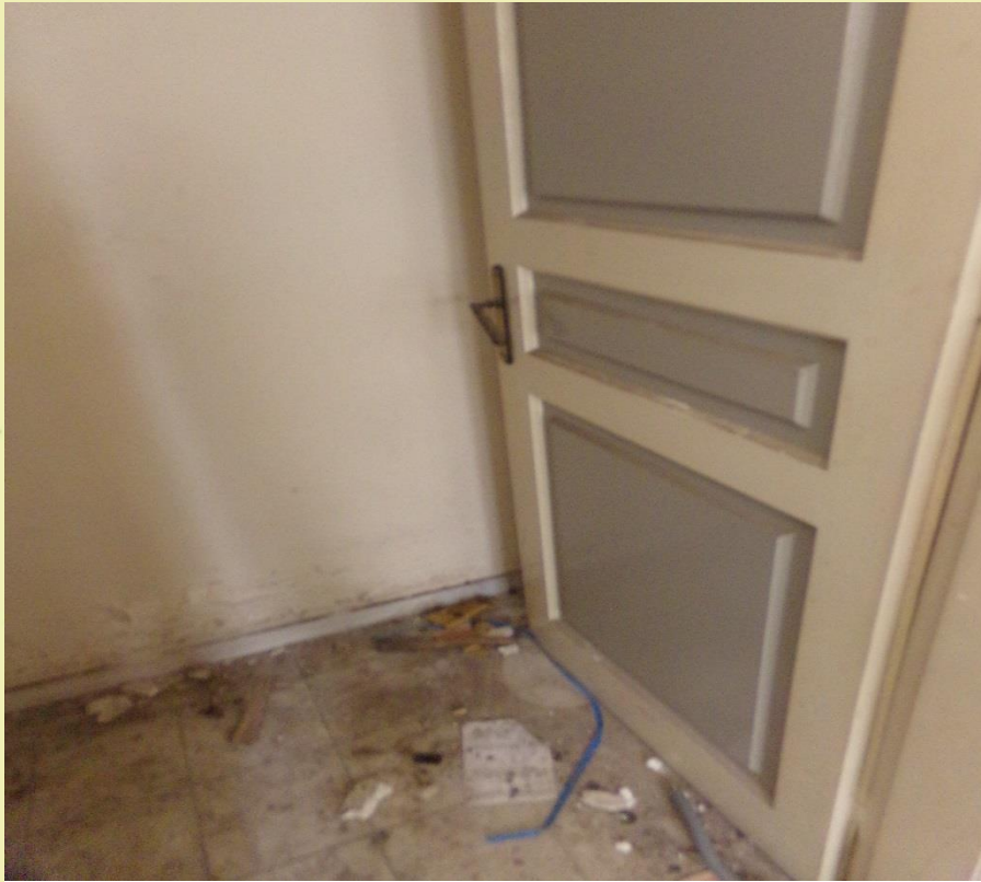
Εικόνα 21: Η ταμπλαδοτή ξύλινη θύρα του ανοίγματος που οδηγεί στον διάδρομο.
