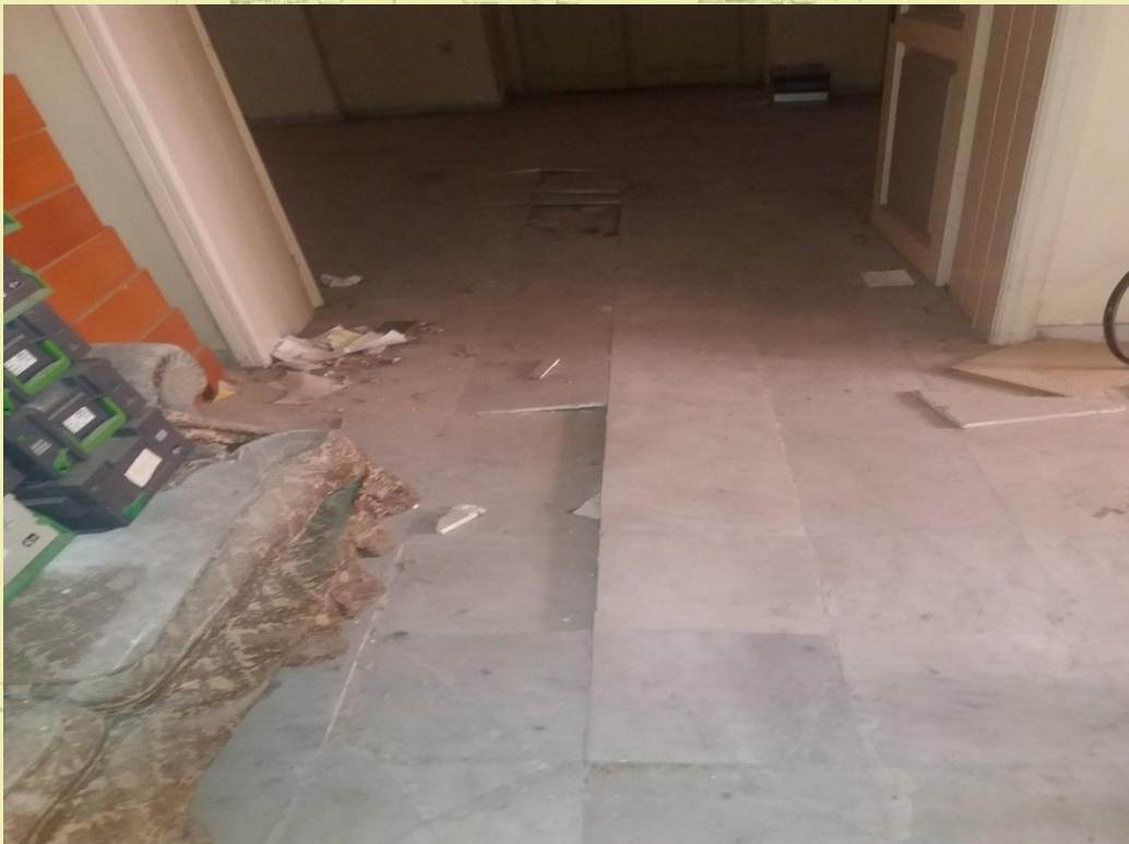
Εικόνα 42: Τα αποκολλημένα πλακίδια κατά μήκος του ορόφου.
