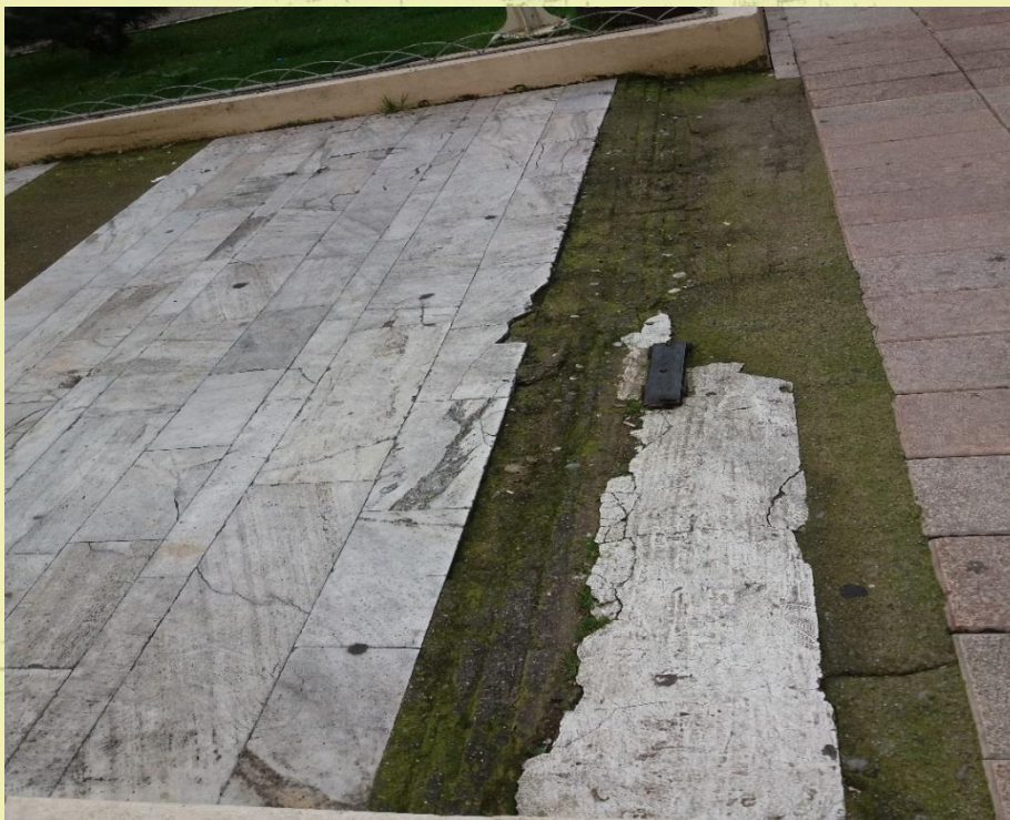
Εικόνα 73: Η ένωση της πλακάδας με τον πεζόδρομο.
