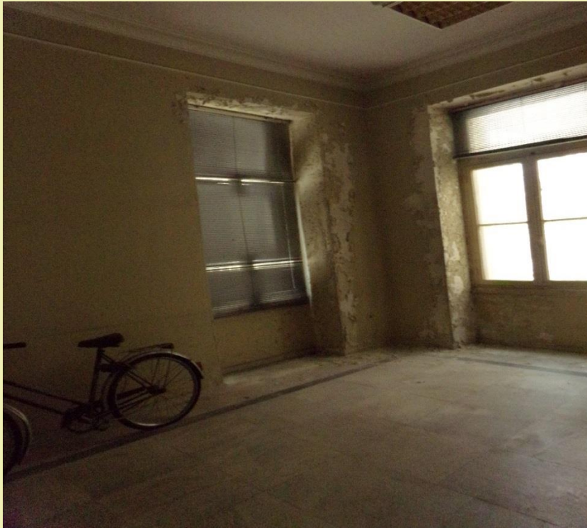
Εικόνα 5: Τα δύο ανοίγματα εμφανίζουν τις επιπτώσεις της εισροής του νερού.
