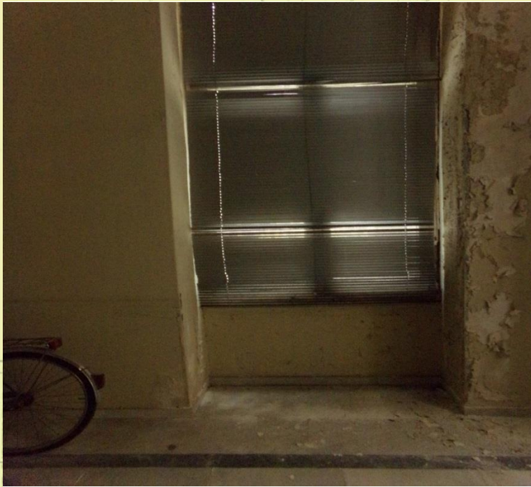
Εικόνα 6: Το άνοιγμα στη δυτική πλευρά παρουσιάζει ζημιωμένη οθονά και καφέ κηλίδες.
