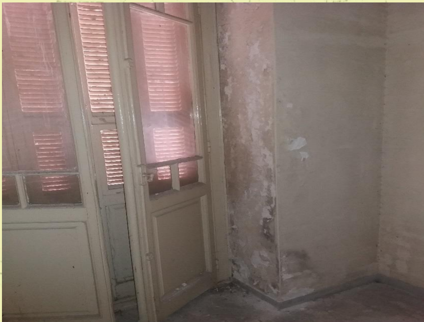
Εικόνα 45: Αποφλοίωση περιμετρικά του αριστερού ανοίγματος και στίγματα μούχλας.
