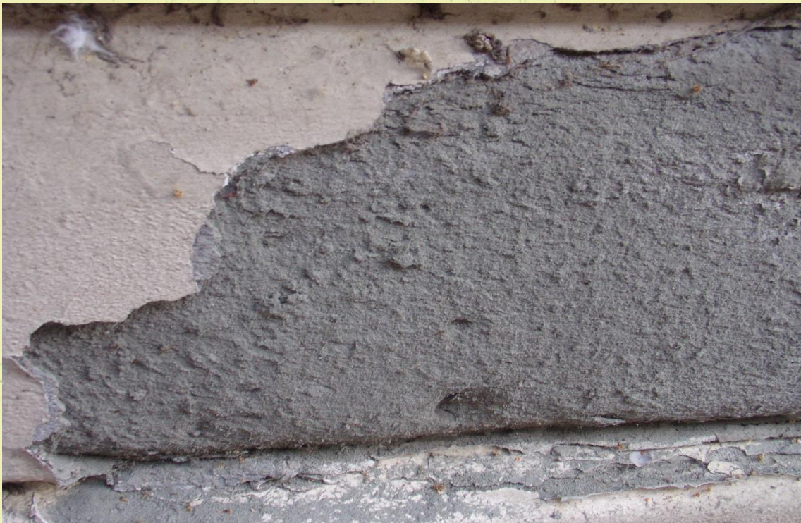
Εικόνα 49: Αποσκόρπιση της πλάκας της κρηλίδας και απολέπιση του λίθου.
