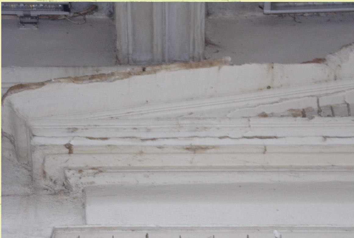
Εικόνα 51: Παραμόρφωση των γείσων και τριχοειδείς ρογιές.
