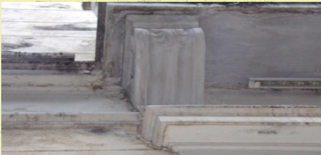
Εικόνα 47: Απομείωση της μαρμάρινης πλάκας του κεντρικού εξόστου.
