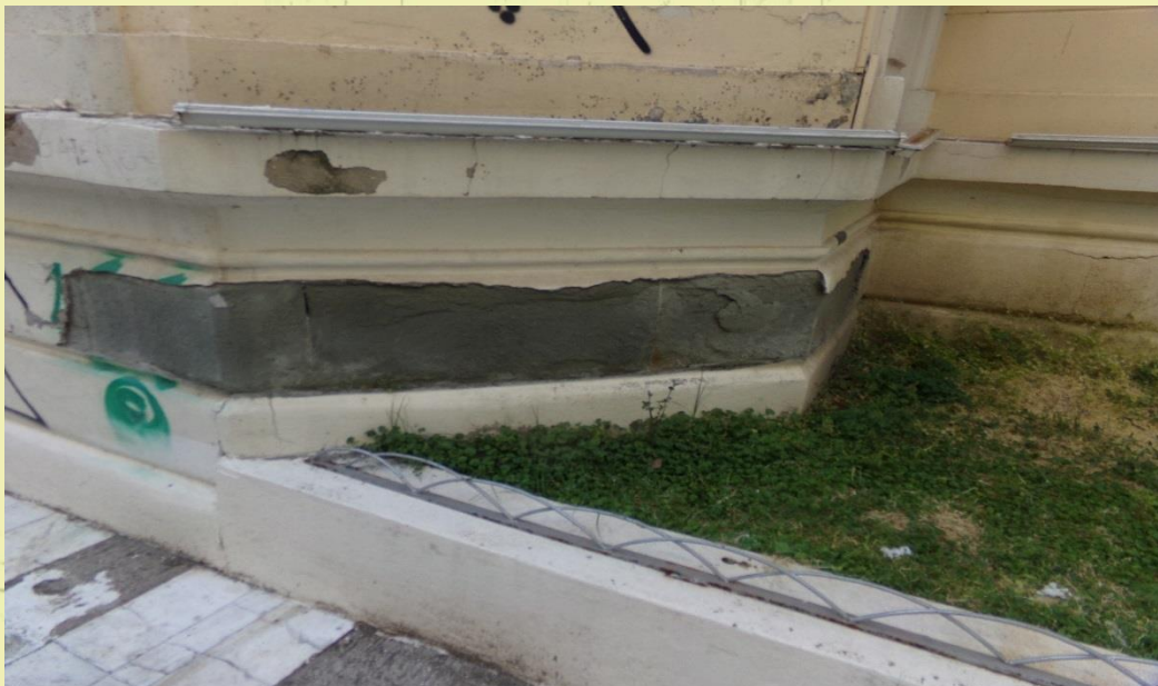
Εικόνα 67: Απολέπιση του λίθου και τοπική κατάρρευση.
