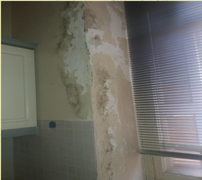
Εικόνα 32: Αποφλοίωση και αποσάθρωση του επιχρίσματος σε συνδυασμό με σκούρες κηλίδες μούχλας πάνω από τα πλακίδια του αγαφοκτήριου και περιμετρικά του ανοίγματος.
