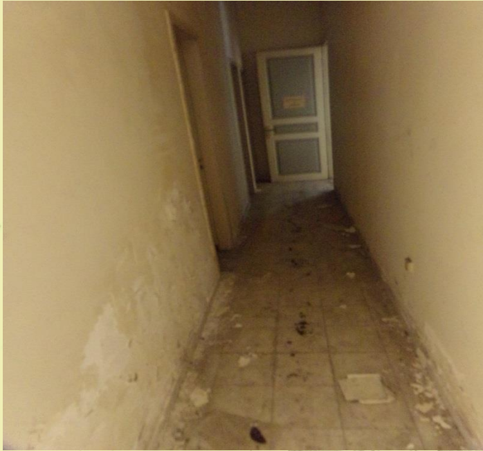
Εικόνα 19: Η διαχωριστική τοιχοποιία των λουτρών και του διαδρόμου εμφανίζει μεγάλες σκούρες κηλίδες συσσωρευμένης υγρασίας.
