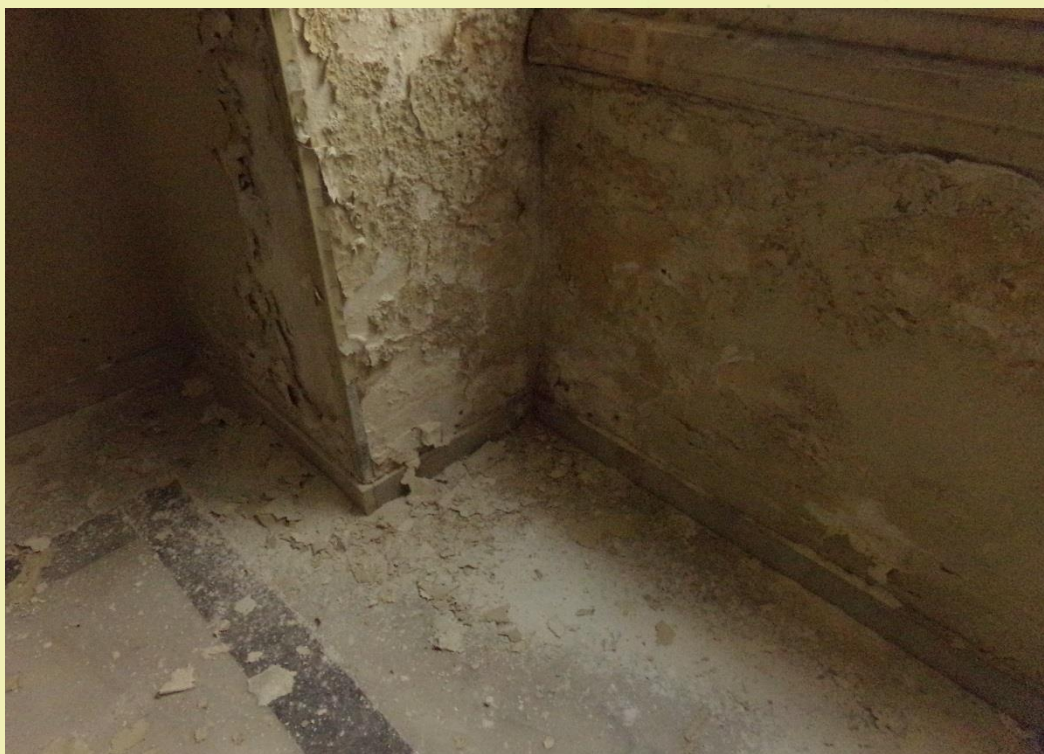
Εικόνα 7: Το άνοιγμα στην βόρεια πλευρά έχει επηρεαστεί περισσότερο καθώς η παθολογία έχει εξαπλωθεί και στην ποδιά.
