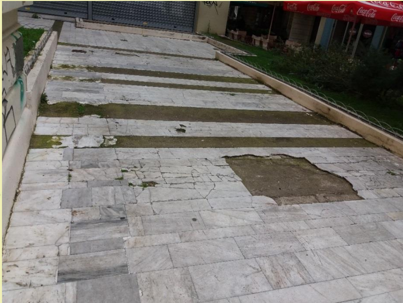
Εικόνα 74: Τα αποκολλημένα πλακίδια της πλατείας.
