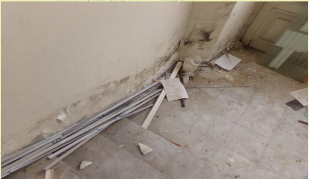
Εικόνα 28: Εμφάνιση μούχλας και αποφλοίωση του χρωματισμού.
