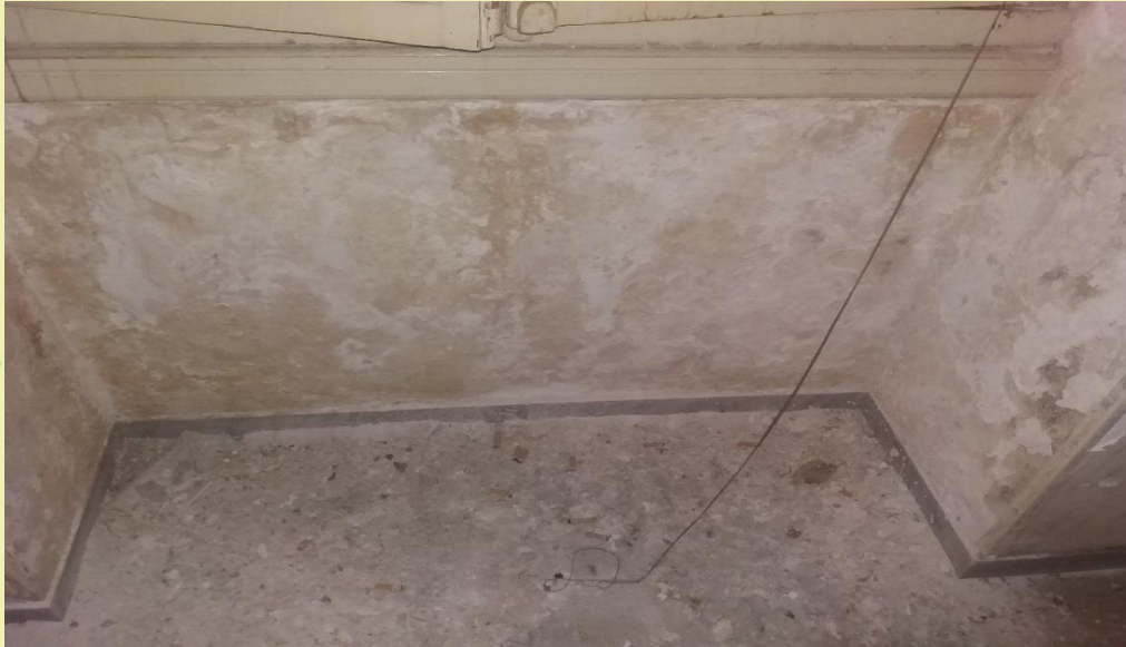
Εικόνα 29: Καφέ κηλίδες σε συνδυασμό με ζαχαρωσιδή φθορά στην ποδιά του παραθύρου.
