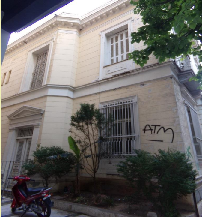
Εικόνα 58: Η βόρεια όψη.
