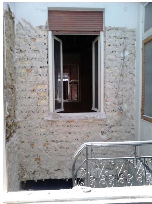
Τοιχοποιία με οπτόπλινθους
