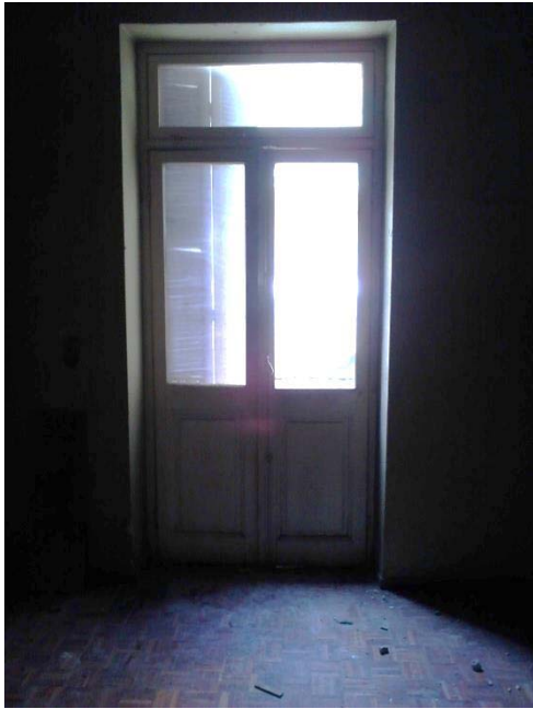
Θύρα δίφυλλη εξωτερική ξύλινη Θ6
