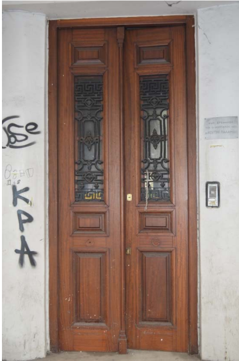
Θύρα δίφυλλη εξωτερική ξύλινη Θ1
