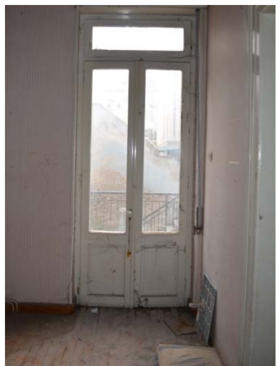
Θύρα δίφυλλη εξωτερική ξύλινη Θ17
