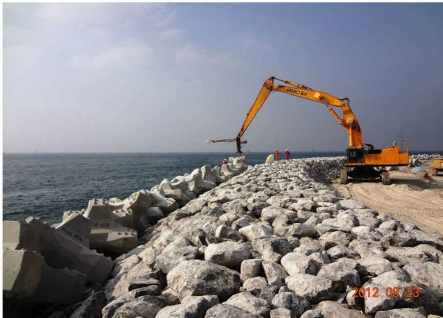
Εικόνα 14: Γερανός ξηράς τοποθέτηση ογκολίθων, (Διαδίκτυο 5).
