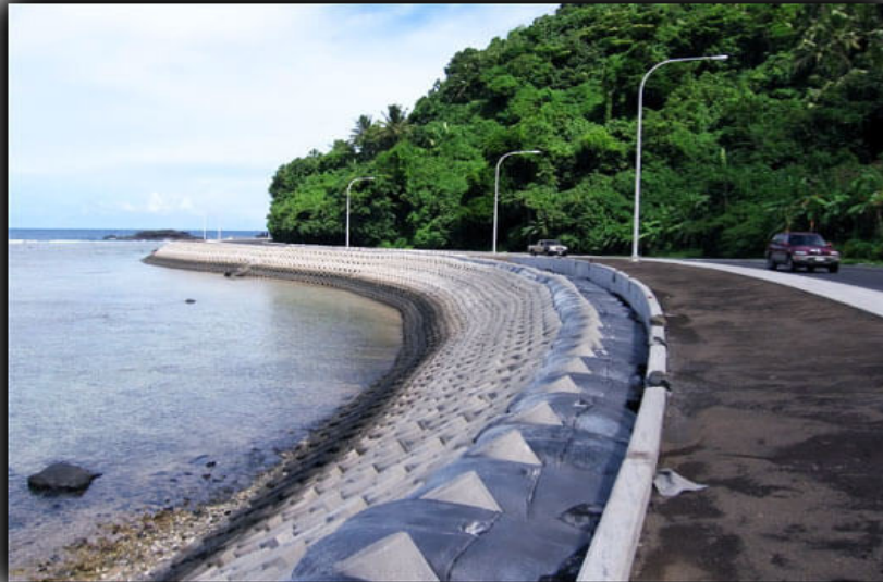
Εικόνα 10: Έργο προστασίας με πρανή τεχνητούς και μπετονιένους ογκόλιθους (Διαδίκτυο 3).
