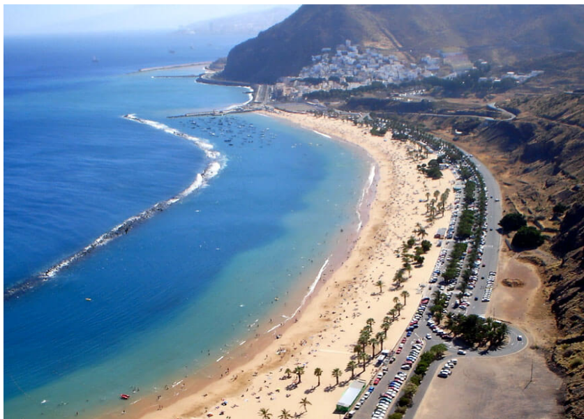
Εικόνα 3: Κυματοθραύστης με φυσικούς ογκόλιθους παράλληλος και κατά μήκος όλης της ακτής στο εξωτερικό (Διαδίκτυο 1, 2016).
