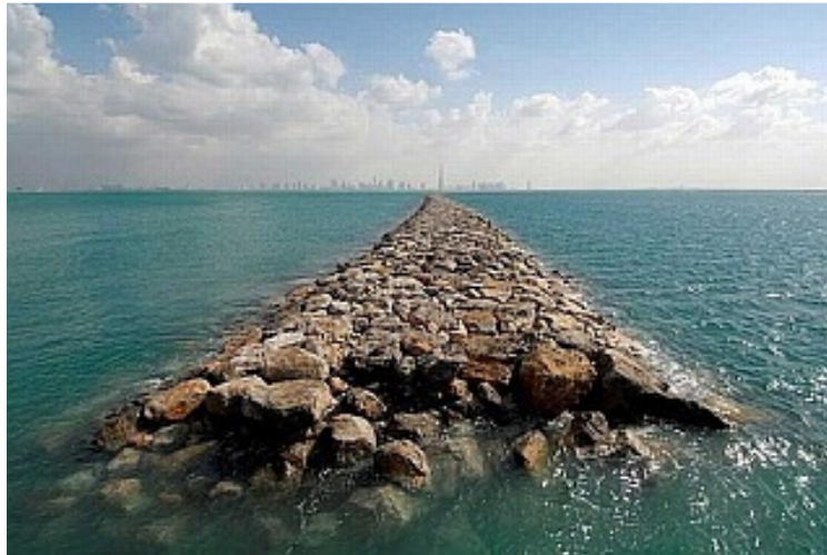
Εικόνα 2: Κυματοθραύστης διπλού μετώπου με φυσικούς ογκολίθους (Διαδίκτυο 2).
