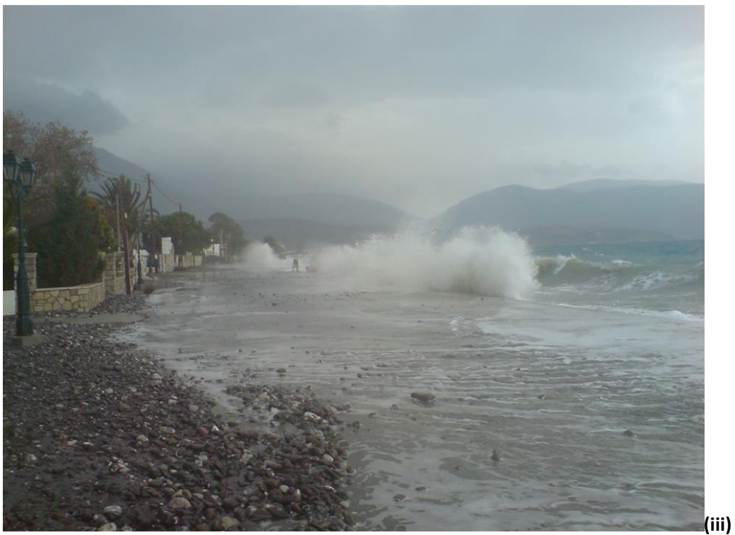
Εικόνες 18: Τμήμα διάβρωσης ακτής προσωπική λήψη Φεβρουάριος 2016.
