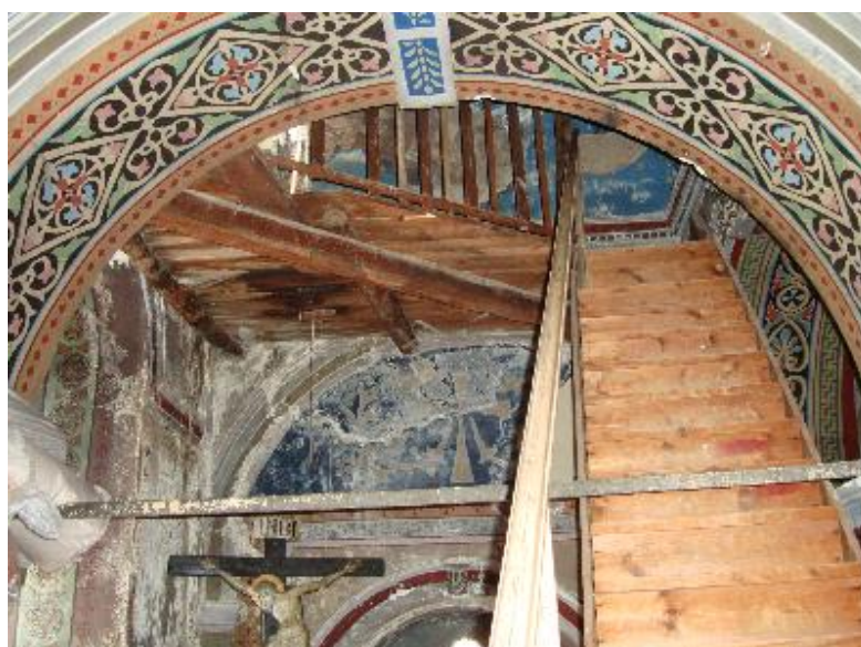
32.β Σκάλα που οδηγεί στο πατάρι για την έξοδο στο κωδωνοστάσιο
