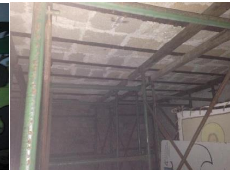
Εικόνα 16: Σύστημα καπιζάνα, στήριξη με υποσύλωση.
