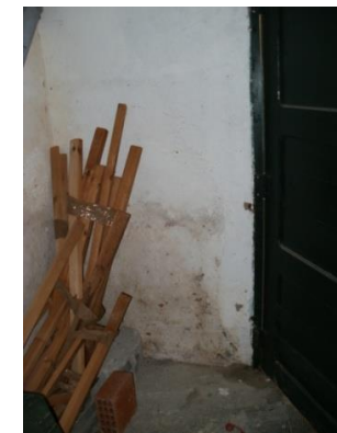
Εικόνα 31: Πρόβλημα με ανερχόμενη υγρασία.
