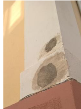
Εικόνα 37: Αφαίρεση τσιμεντοκονιάματος.
