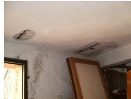
Εικόνα 38: Εμφανής σπλισμός.
