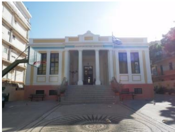
Εικόνα 1: Κύρια όψη κτιρίου.
