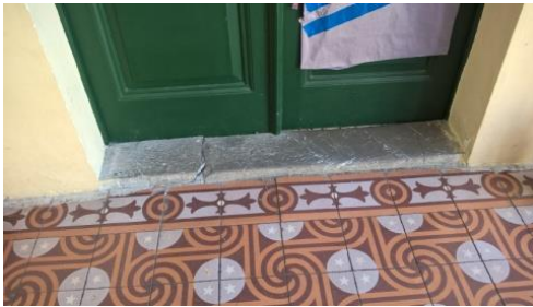
Εικόνα 33: Αποκόλληση τσιμεντοπλακιδίων.
