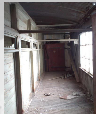
Εικόνα 88: Εσωτερική όψη μεταλλικής γέφυρας
