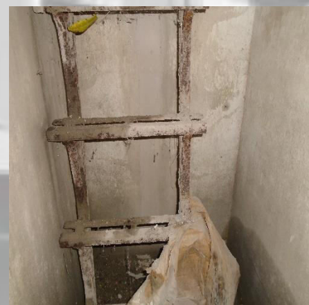
Εικόνα 13: Οξειδωμένη μεταλλική κλίμακα
