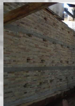
Εικόνα 49: Τοιχοποιία από συμπαγή τούβλα
