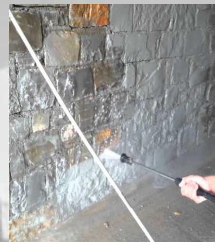
Εικόνα 161: Υδροβολή σε Πέτρινη Τοιχοποιία
