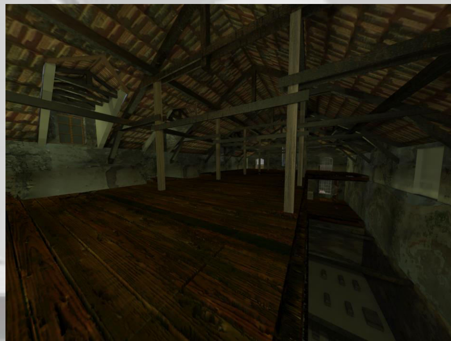
Εικόνα 150: Αποψη Δευτέρου Ορόφου Κτηρίου 1
