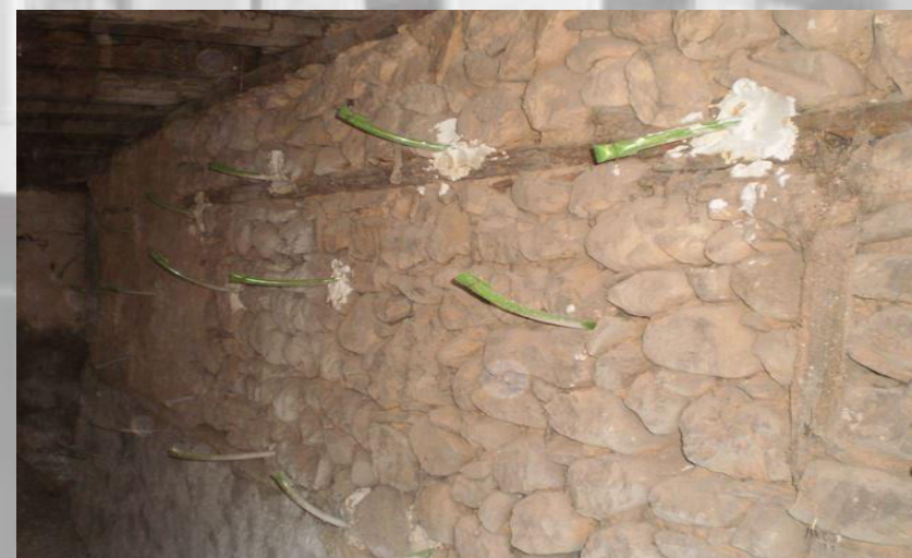
Εικόνα 162: Υδραυλικά Ενέματα σε Πέτρινη Τοιχοποιία
