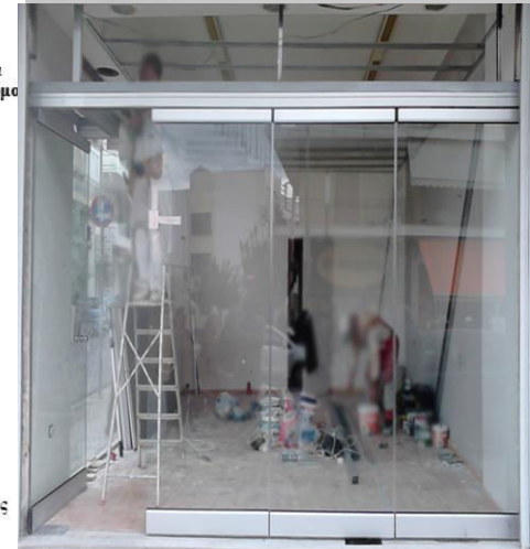
Εικόνα 164: Γυάλινα Πτυσσόμενα Πετάσματα
