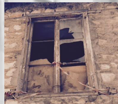
Εικόνα 31: Φθορές στα κουφώματα τα ξύλινα
