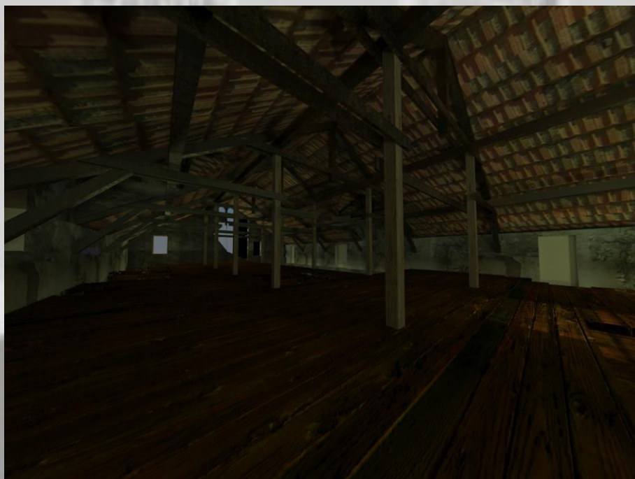
Εικόνα 149: Αποψη Δευτέρου Ορόφου Κτηρίου 1
