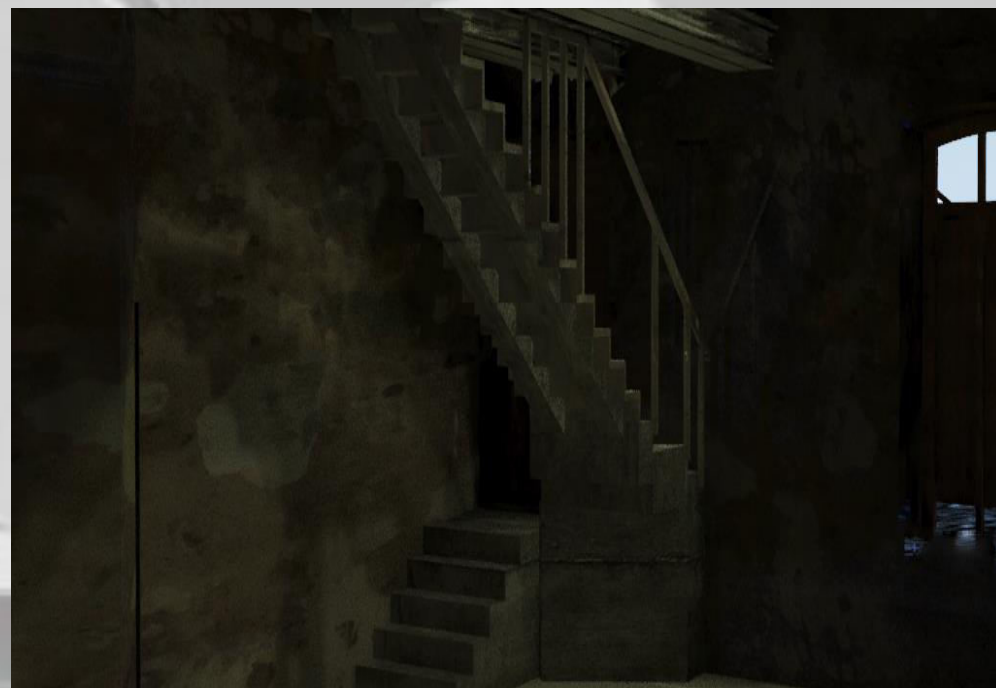
Εικόνα 152: Άποψη Κλίμακας Ισογείου-Πρώτου Ορόφου Κτηρίου 1
