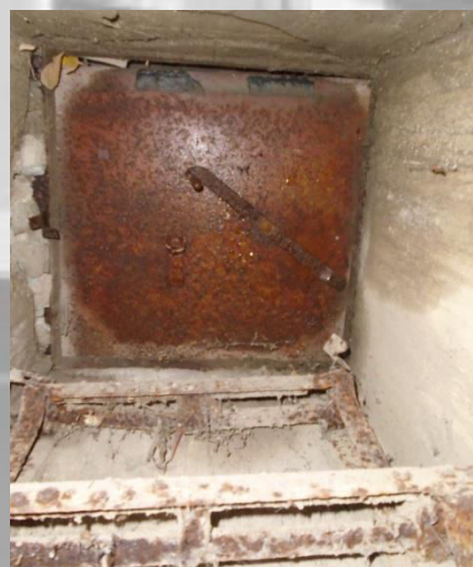
Εικόνα 70: Βοηθητική κλίμακα για καταπακτή
