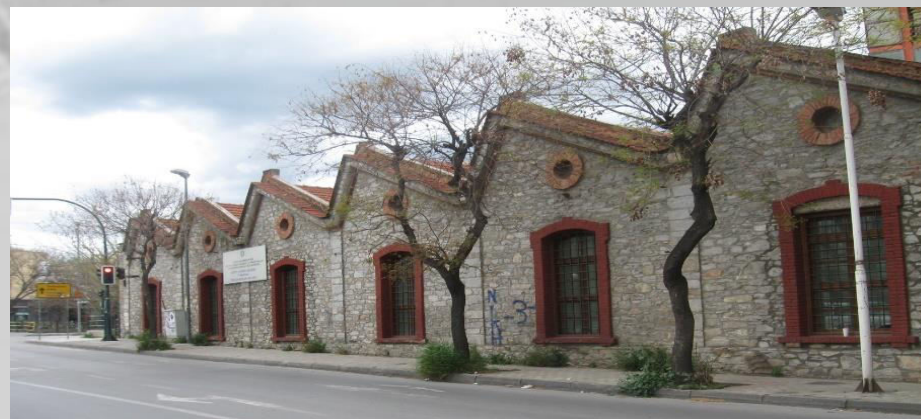
Εικόνα 9 Τύπος «οδοντωτό κτήριο», (κτήριο εργοστάσιο υφαντουργίας Μουρτούκου, Βόλος)
