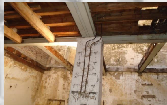
Εικόνα 63: Πεπλάτωση πέτρινων κολονών
