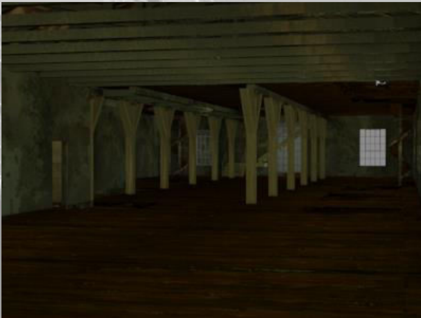
Εικόνα 148: Άποψη Πρώτου Ορόφου Κτηρίου 1
