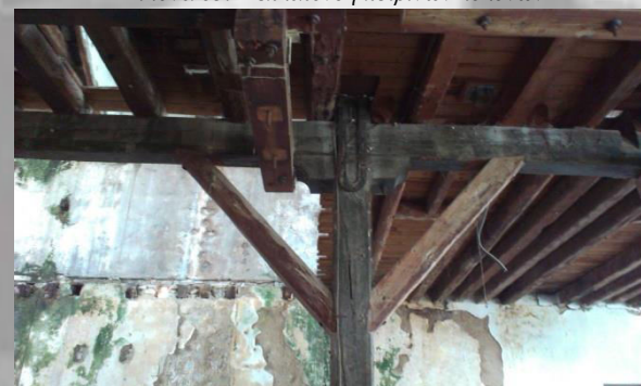
Εικόνα 64: Ψαλίδια ξύλινων υποστυλωμάτων
