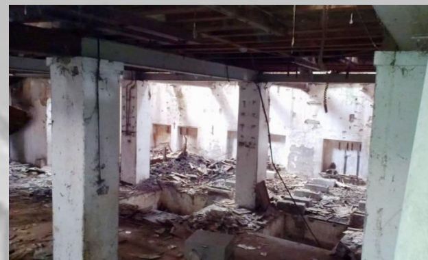
Εικόνα 59: Μεταλλικά Η μεσοπάτωμα ισογείου
