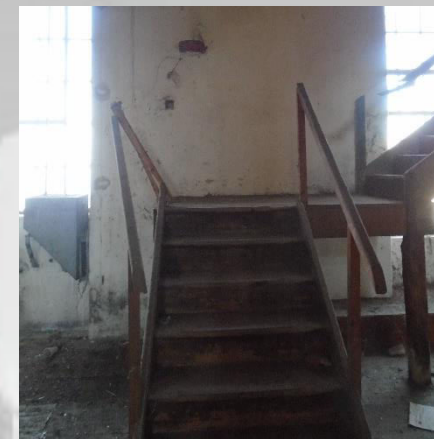
Εικόνα 12: Φθορές στα κιγκλιδώματα
