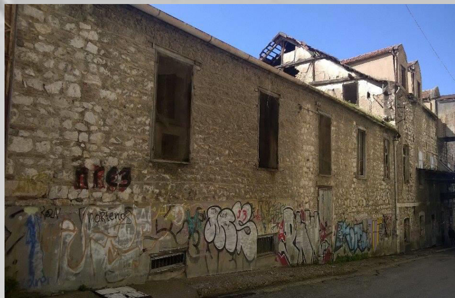
Εικόνα 40: Πλάγια όψη κτηρίου 1
