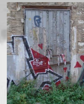
Εικόνα 54: Διαμόρφωση ανοίγματος με μεταλλικό πρέκι
