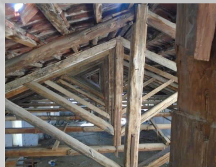
Εικόνα 15: Στέγη πρώτου επιπέδου
