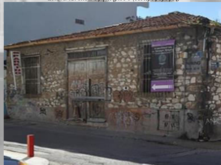
Εικόνα 43: Πίσω όψη κτηρίου 1 (πρώτος όροφος)
