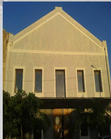
Εικόνα 32: Πρόσψη 3 ου κτηρίου
