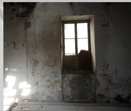
Εικόνα 3: Ρωγμές τοιχοποιίας
