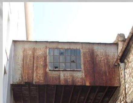
Εικόνα 87: Εξωτερική όψη μεταλλικής γέφυρας
