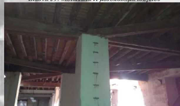
Εικόνα 60: Ξύλινοι δοκοί μεσοπάτωμα ισογείου
