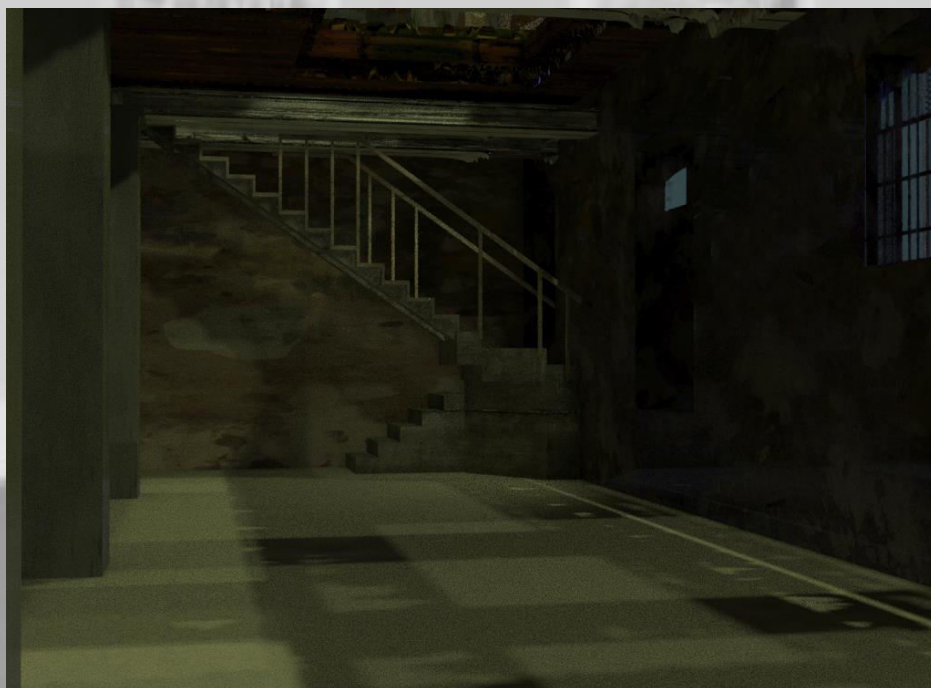
Εικόνα 151: Άποψη Κλίμακας Ισογείου-Πρώτου Ορόφου Κτηρίου 1
