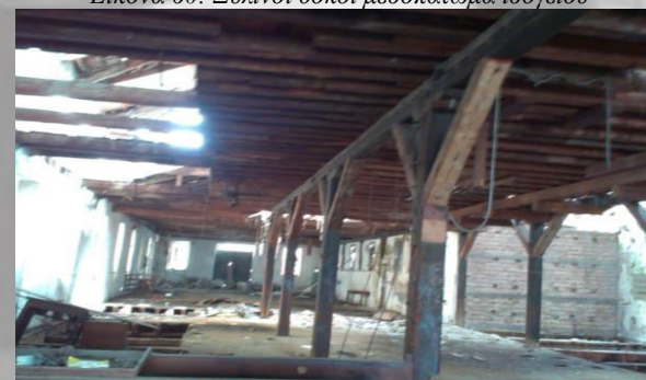
Εικόνα 61: Ξύλινοι δοκοί μεσοπάτωμα πρώτου ορόφου
