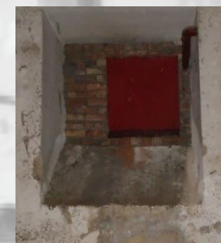
Εικόνα 56: Σφραγισμένο άνοιγμα στη πλάγια όψη
