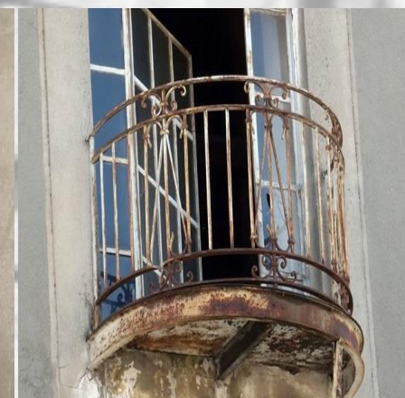
Εικόνα 14: Οξειδωμένοι εξώστες
