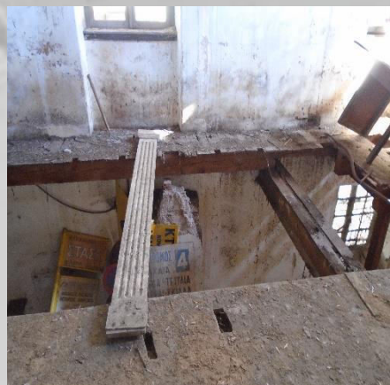
Εικόνα 7: Αφαίρεση μέρους των μεσοπατωμάτων
