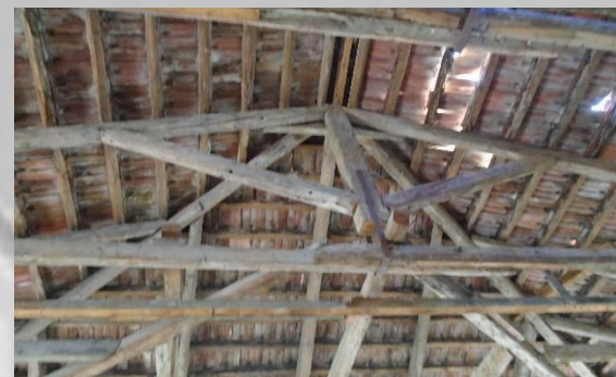
Εικόνα 74: Στέγη πρώτου επιπέδου
