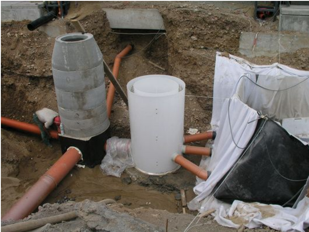
Εικόνα 8: Άποψη φρεατίου συμβολής. [Διαδίκτυο 7]
