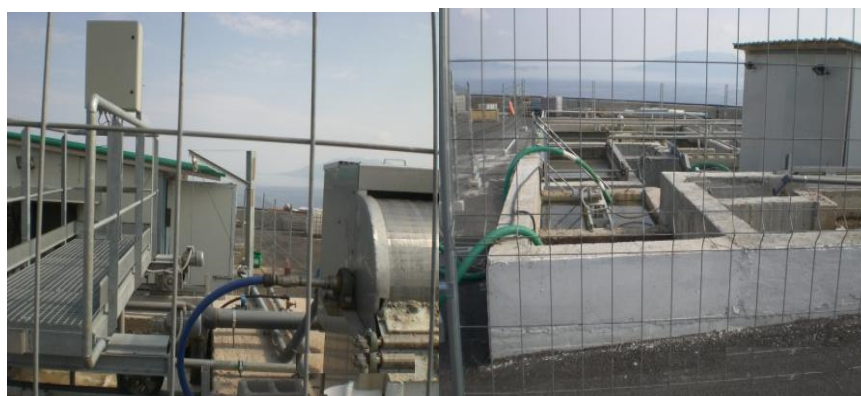
Εικόνα 44: Εγκατάσταση βιολογικού καθαρισμού σε μονάδα μεταποίησης και συσκευασίας ιχθύων
