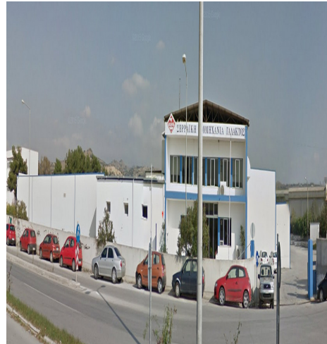
ΕΙΚΟΝΑ 7: Εγκαταστάσεις της Σεργαλ στο 1ο Σερρών-Θεσσαλονίκης
