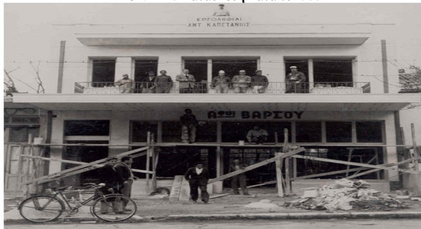
ΕΙΚΟΝΑ 44: Κατασκευή κατά το 1955
