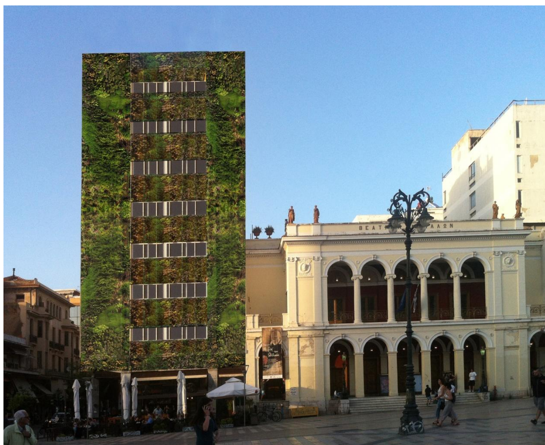
Εικόνα 3.22: Επέμβαση κάθετου κήπου σε κτίριο που βρίσκεται στην πλατεία Γεωργίου.
