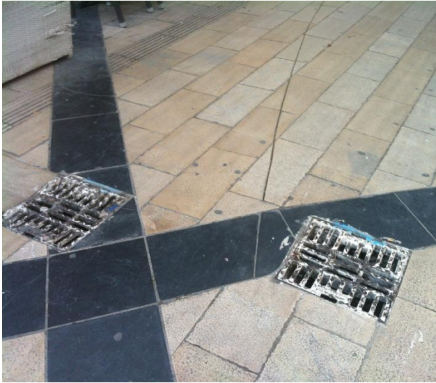
Εικόνες 2.17 – 2.20: Σπασμένες πλάκες και λάθος σύνδεση των διάφορων υλικών στην πλατεία.
