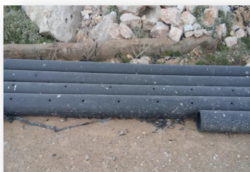
Εικόνα 4.5α: Διάτρητοι αγωγοί συλλογής [67]
