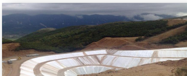
Εικόνα 3.2: ΧΥΤΑ με ειδική μεμβράνη στεγανοποίησης [58]
