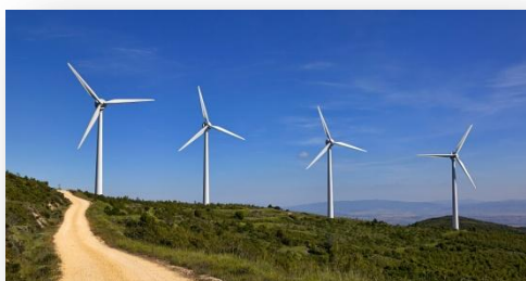
Εικόνα 1.1: Αιολικό πάρκο ανεμογεννητριών [16]
