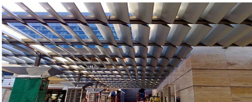
Εικόνα 3.2 :Σκίαση αίθριου σε βιομηχανικό κτίριο στο Λονδίνο .
