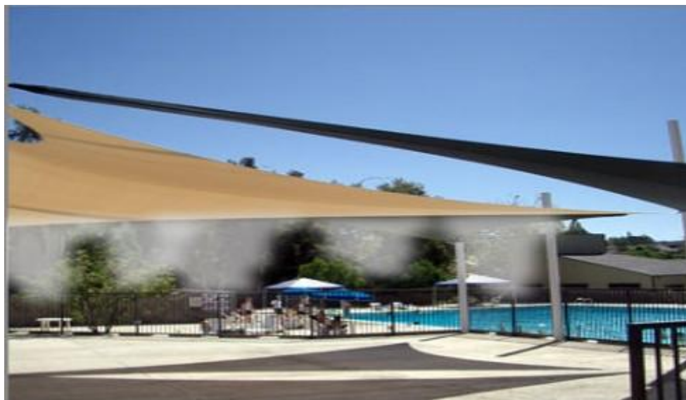
Εικόνα 8.1 : Παράδειγμα υδρονέφωσης σε στέγαστρο
