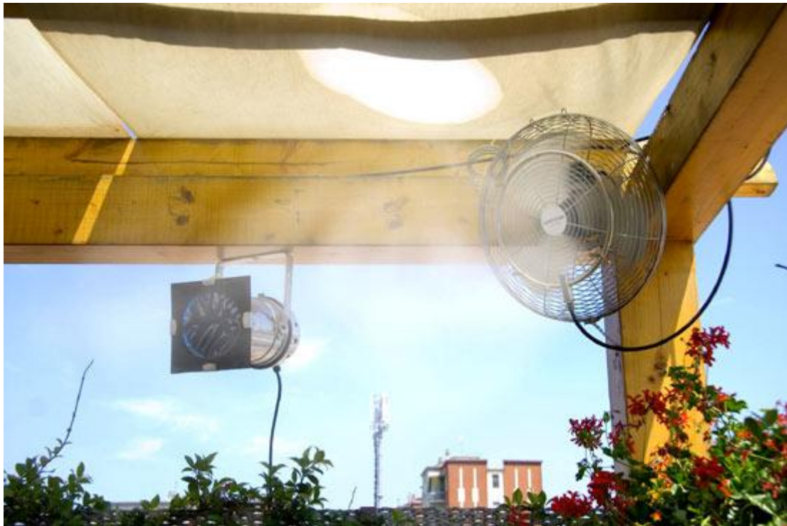
Εικόνα 8.2 : Υλοποίηση υδρονέφωσης με ανεμιστήρα
