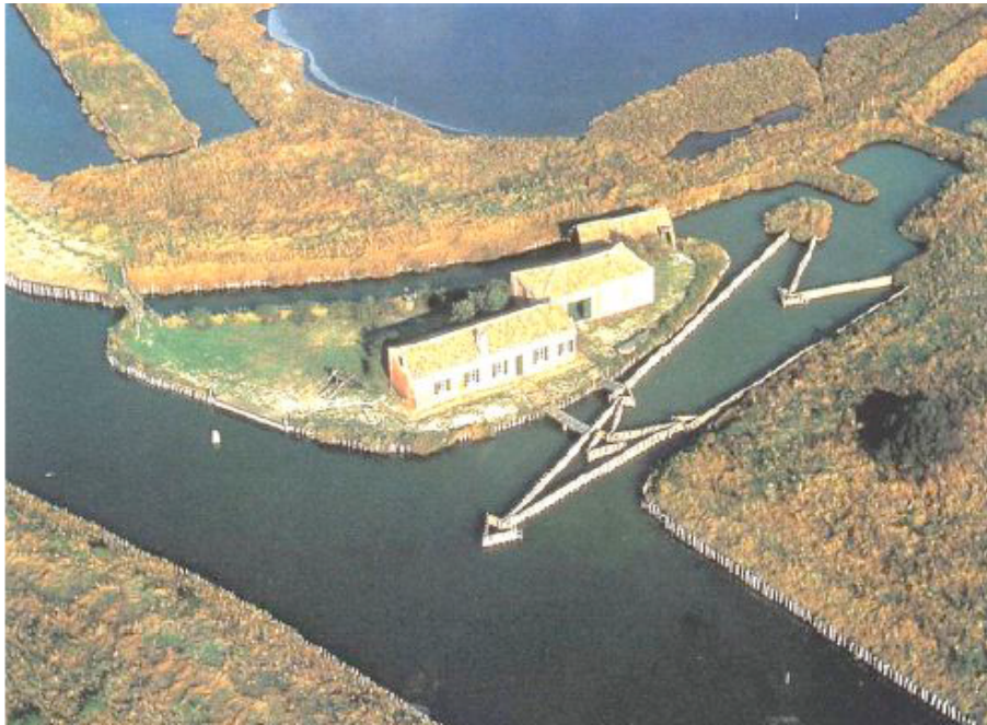
Σχήμα 10. Ιχθυοσυλληπτική εγκατάσταση σε valli.
