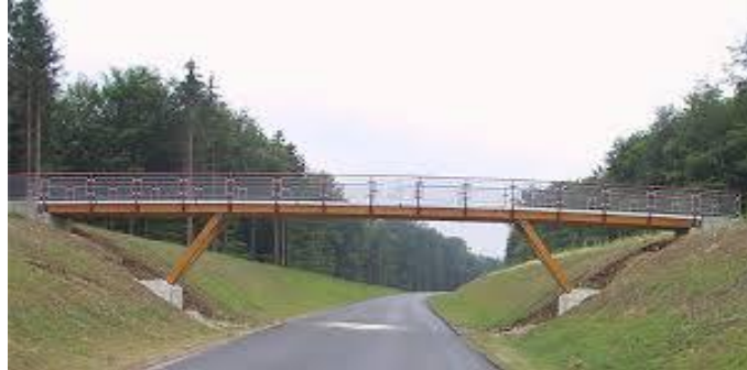
Εικόνα 2.28: Άκαμπτο Πλαίσιο με κεκλιμένα μεσόβαθρα.
