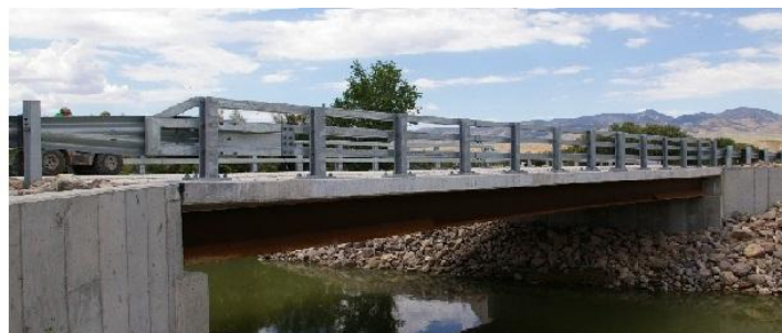
Εικόνα 2.24: Γέφυρα μορφής δοκού, το κατάστρωμα είναι πάνω στις δοκούς.
