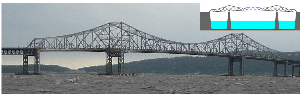
Εικόνα 2.31: Γέφυρα πρόβολος διάταξης through, όπου το κατάστρωμα βρίσκεται στο κάτω πέλμα του δικτυώματος.
