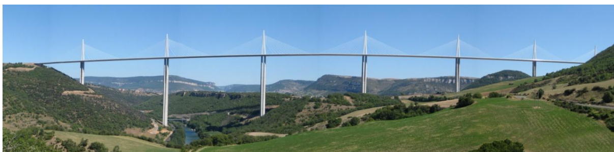
Εικόνα 2.13: Γέφυρα Millau 2004, Γαλλία.
