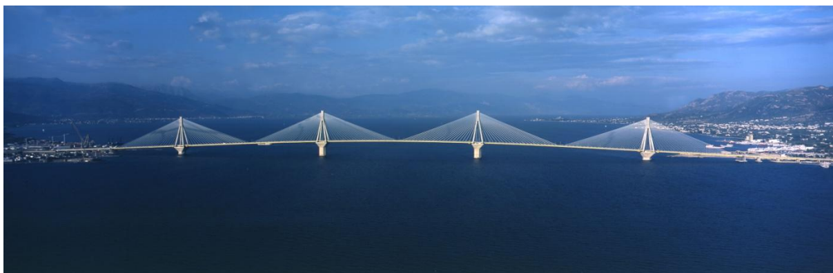
Εικόνα 2.12: Γέφυρα Ρίου-Αντιρρίου 2004, Ελλάδα.
