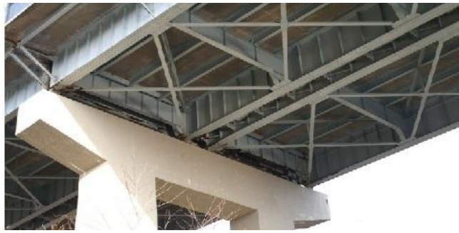
Εικόνα 2.25: Γέφυρα διάταξης deck υποστηριζόμενη, το κατάστρωμα είναι πάνω σε πλάκες οι οποίες εδράζονται σε τραβέρσα.
