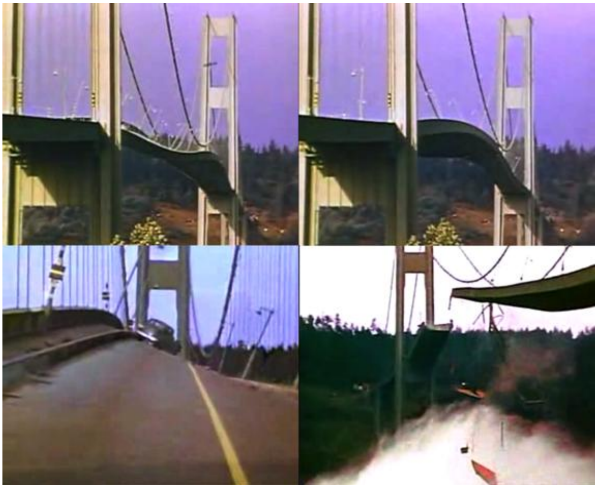
Εικόνα 7.1: Γέφυρα Tacoma Narrows.
