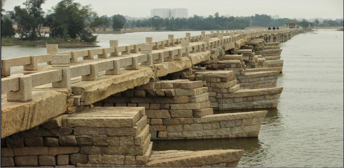
Εικόνα 2.1: Anping Bridge στην Κίνα το 1151.
