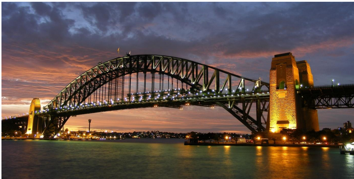
Εικόνα 2.9: Γέφυρα Sydney Harbour 1932, Σύδνεϋ Αυστραλία.
