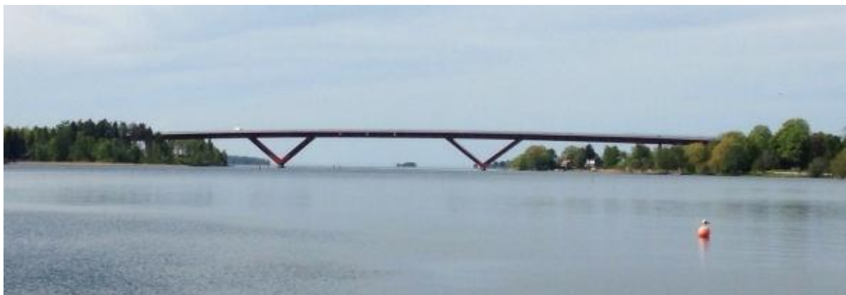
Εικόνα 2.29: Άκαμπτο Πλαίσιο με μεσόβαθρα μορφής τύπου 'V'.
