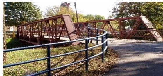
Εικόνα 2.26: Γέφυρα διάταξης pony, η διαδοκίδα και το κατάστρωμα συνδέονται άκαμπτα με έλασμα ενισχύσεως.
