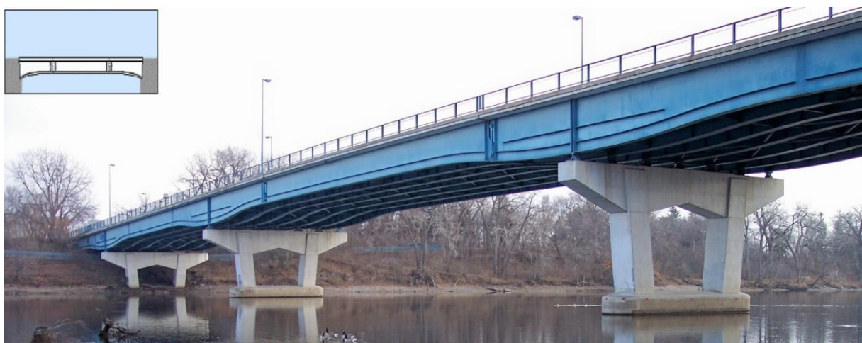
Εικόνα 2.27: Τρία ανοίγματα τα οποία συναρμόζονται μεταξύ τους με κομβοελάσματα.
