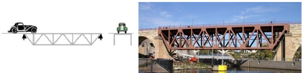
Εικόνα 2.21: Δικτύωμα διάταξης deck, άνω διαβάσεως κλειστής διατομής.
