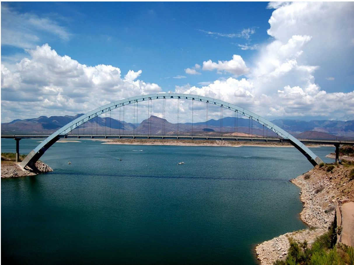
Εικόνα 1.3: Τοξωτή γέφυρα στην λίμνη Roosevelt, (παράδειγμα τόξου).
