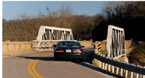
Εικόνα 2.23: Δικτύωμα διάταξης pony, κάτω διαβάσεως ανοικτής διατομής.
