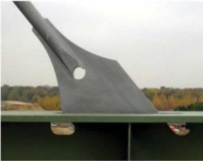
Εικόνα 4.10: Αριστερά σύνδεση κρέμαστρου απευθείας συγκολλημένο, δεξιά όψη κρέμαστρου.
