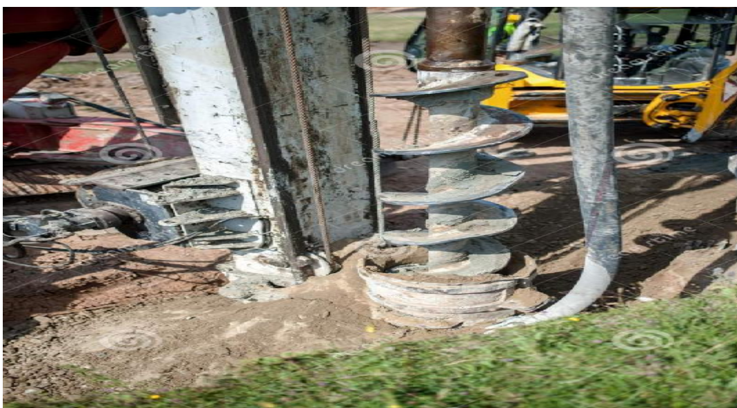
Εικόνα 2.6: Θρύμματα από γεώτρηση στην περίπτωση αυτή λασπη [41].
