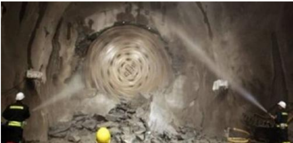
Εικόνα 1.10: Μετροπόντικας ανοίγει σήραγγα [17].
