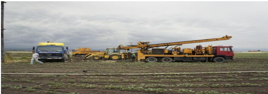
Εικόνα 4.1: Γεωτρηση νερού σύμφωνα με την παραπάνω μελέτη [17].
