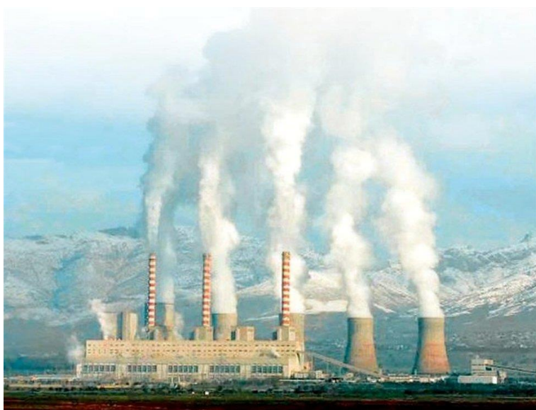
Εικόνα 33: Μονάδα ΔΕΗ Κοζάνης
