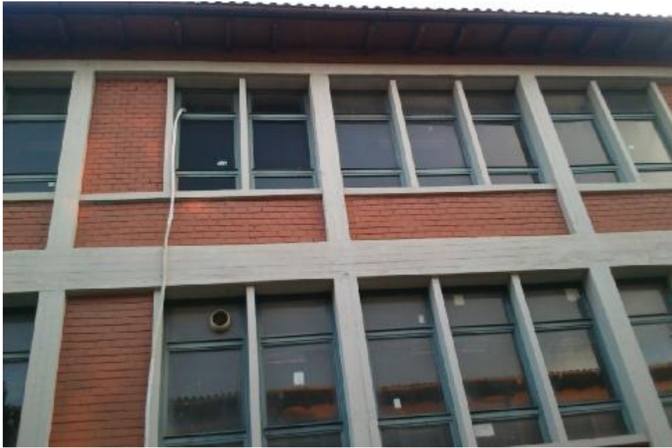
ΕΙΚΟΝΑ 2.4: ΑΛΛΗ ΑΠΟΨΗ ΤΗΣ ΒΟΡΕΙΑΣ ΠΛΕΥΡΑΣ ΤΟΥ ΚΤΙΡΙΟΥ Ζ
