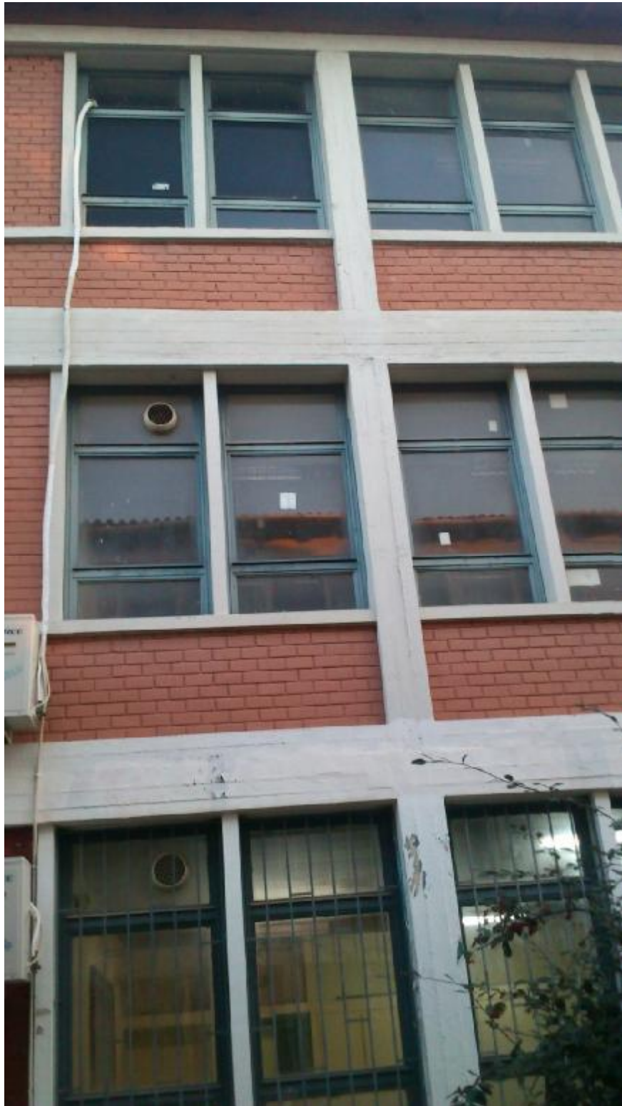
ΕΙΚΟΝΑ 2.3: ΑΛΛΟ ΜΕΡΟΣ ΑΝΟΙΓΜΑΤΩΝ ΤΗΣ ΒΟΡΕΙΑΣ ΠΛΕΥΡΑΣ ΤΟΥ ΚΤΙΡΙΟΥ Ζ
