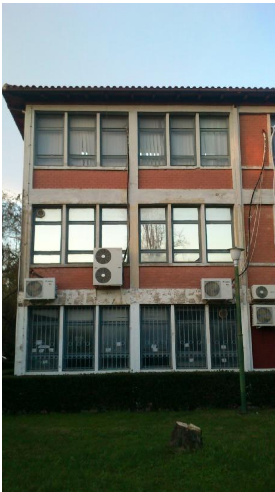
ΕΙΚΟΝΑ 1.3: ΜΕΡΟΣ ΑΝΟΙΓΜΑΤΩΝ ΤΗΣ ΝΟΤΙΑΣ ΠΛΕΥΡΑΣ ΤΟΥ ΚΤΙΡΙΟΥ Ζ
