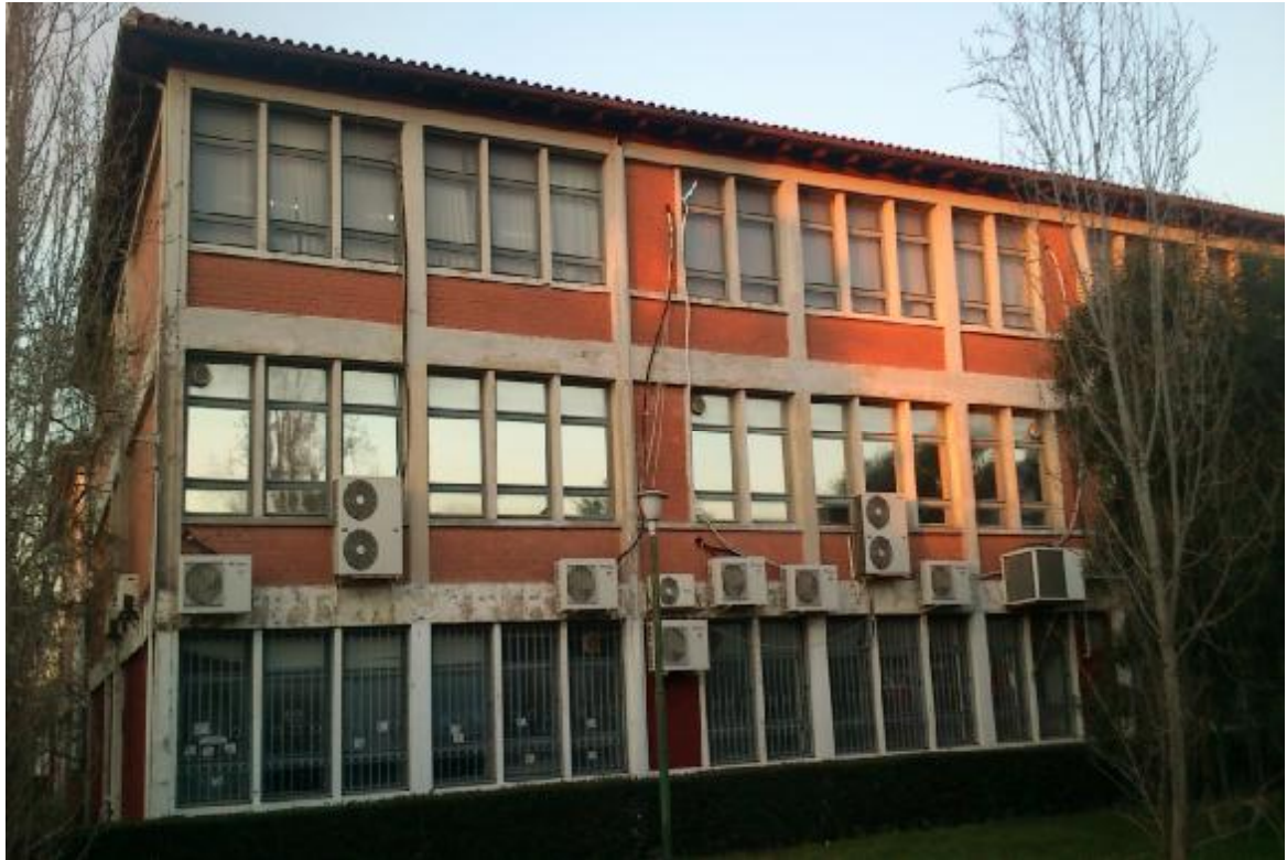
ΕΙΚΟΝΑ 1.1: ΑΠΟΨΗ ΤΗΣ ΝΟΤΙΑΣ ΠΛΕΥΡΑΣ ΤΟΥ ΚΤΙΡΙΟΥ Ζ
