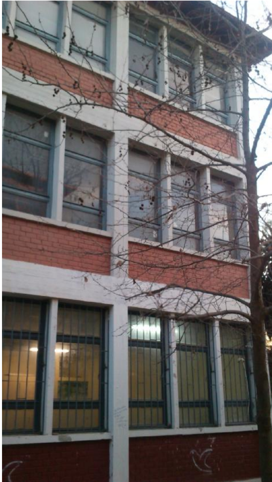
ΕΙΚΟΝΑ 2.6: ΝΕΟ ΜΕΡΟΣ ΑΝΟΙΓΜΑΤΩΝ ΤΗΣ ΒΟΡΕΙΑΣ ΠΛΕΥΡΑΣ ΤΟΥ ΚΤΙΡΙΟΥ Ζ
