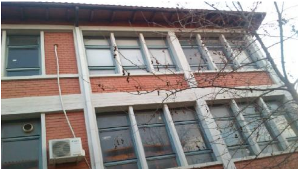
ΕΙΚΟΝΑ 2.5: ΝΕΑ ΑΠΟΨΗ ΤΗΣ ΒΟΡΕΙΑΣ ΠΛΕΥΡΑΣ ΤΟΥ ΚΤΙΡΙΟΥ Ζ
