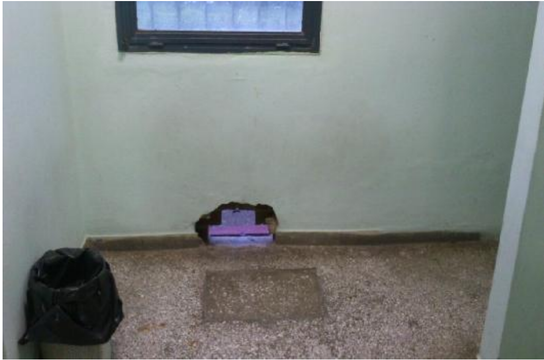
ΕΙΚΟΝΑ 3.1: ΑΝΟΙΓΜΑ ΣΤΟ ΙΣΟΓΕΙΟ ΤΟΥ ΚΤΙΡΙΟΥ Ζ
