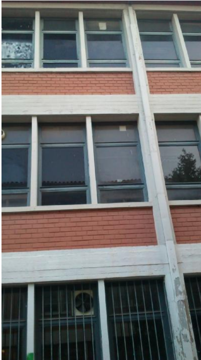
ΕΙΚΟΝΑ 2.2: ΜΕΡΟΣ ΑΝΟΙΓΜΑΤΩΝ ΤΗΣ ΒΟΡΕΙΑΣ ΠΛΕΥΡΑΣ ΤΟΥ ΚΤΙΡΙΟΥ Ζ
