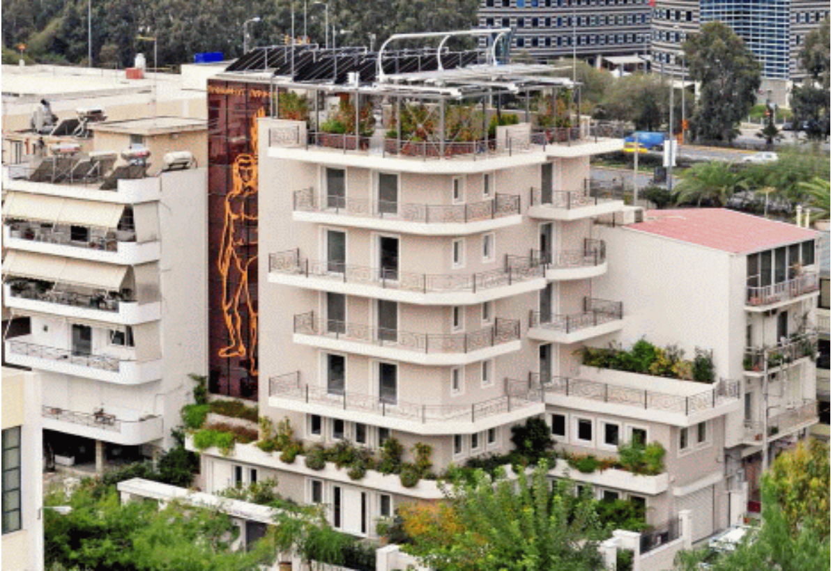
Κτίριο κατοικιών σχεδόν μηδενικής κατανάλωσης ενέργειας στην Ελλάδα (στην περιοχή του Π. Φαλήρου Αττικής)
