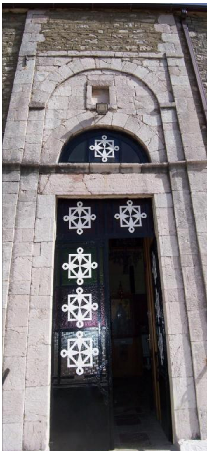
Εικόνα 18 Κύρια είσοδος πριν την αποκατάσταση
