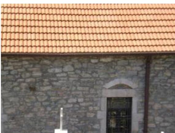
Εικόνα 51 Λεπτομέρεια λιθοδομής στη βόρεια όψη
