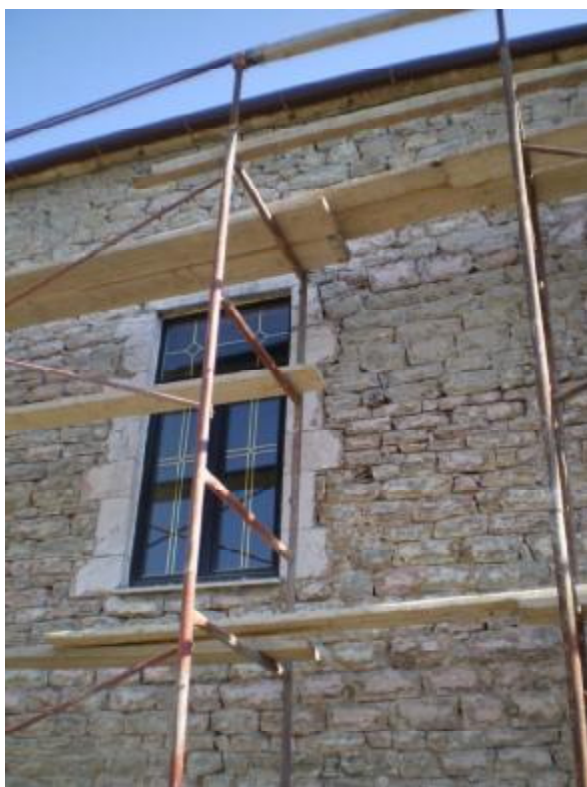
Εικόνα 32 Απόξεση αρμών περιμετρικά των ανοιγμάτων
