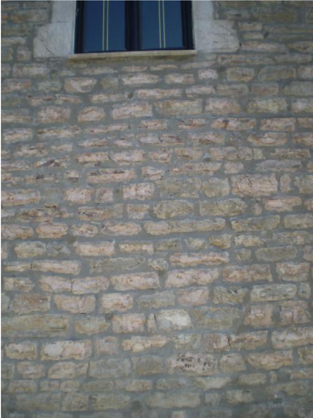
Εικόνα 60 Λεπτομέρεια κατόπιν εφαρμογής λιθοραφής
