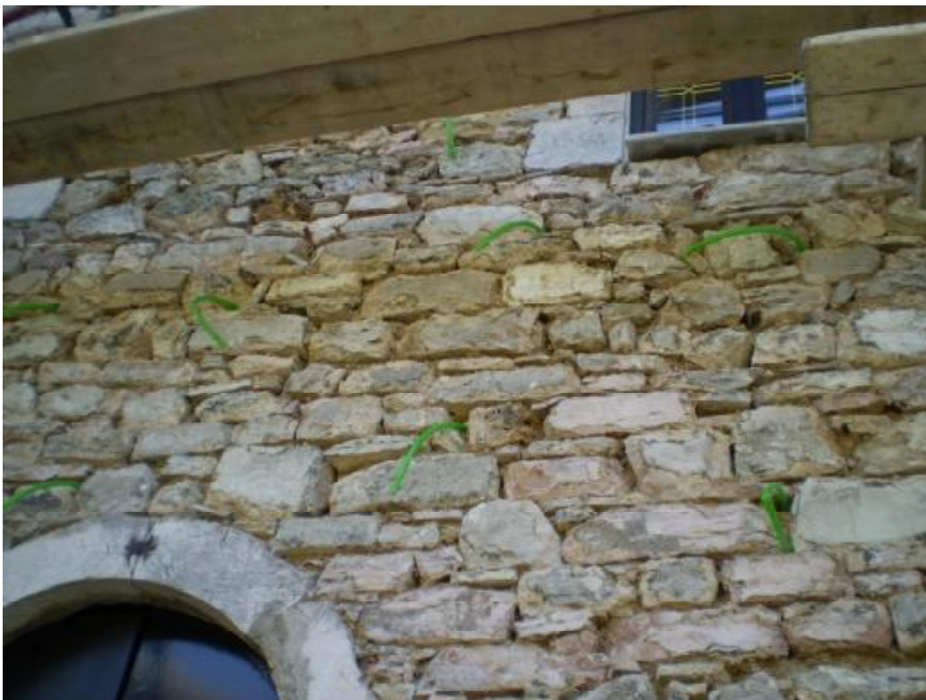
Εικόνα 33 Εφαρμογή σωληνίσκων πριν το νέο αρμολόι
