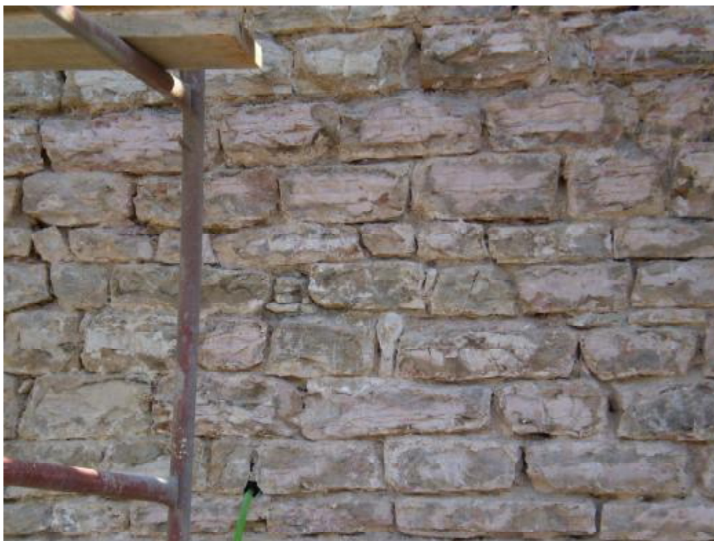
Εικόνα 31 Απόξεση αρμών.
