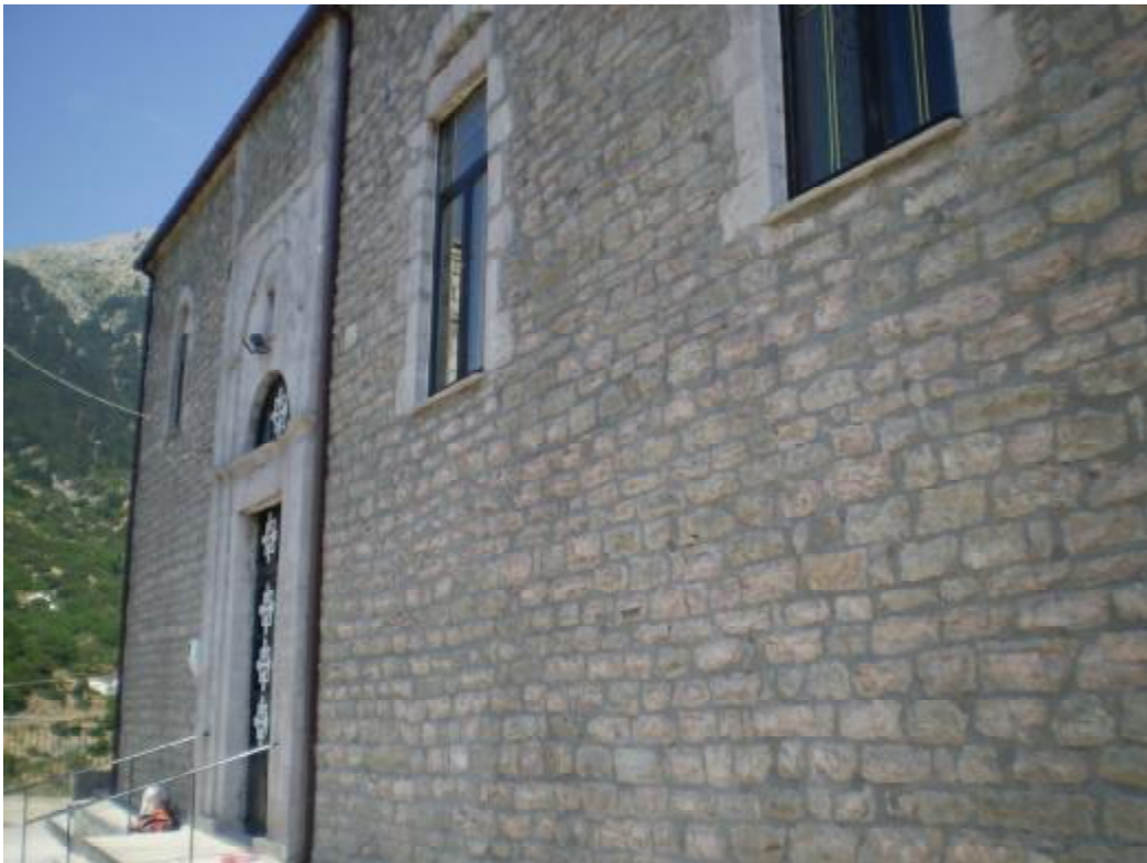
Εικόνα 47 Νότια όψη μετά
