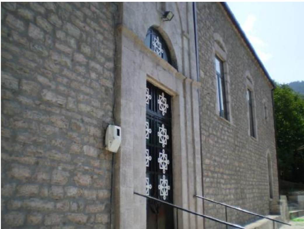
Εικόνα 48 Νότια όψη μετά, εμφανής η διαφορά στο αρμολόγημα
