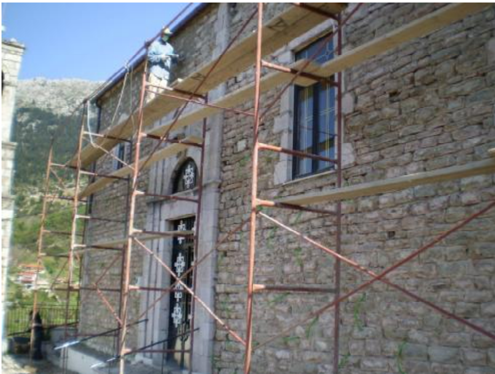
Εικόνα 34 Μετά την τοποθέτηση σωληνίσκων για τα ενέματα γίνεται το νέο αρμολόγημα
