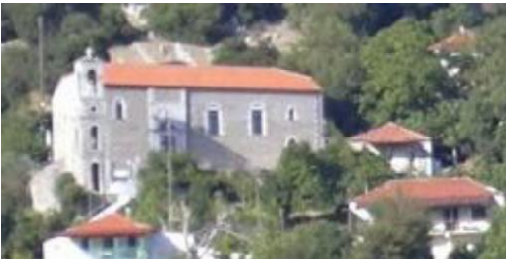
Εικόνα 9 Μακρινή άποψη της νότιας πλευράς του Ιερού Ναού Αγίας Μαρίας και του καμπαναριού, μετά την αποκατάσταση
