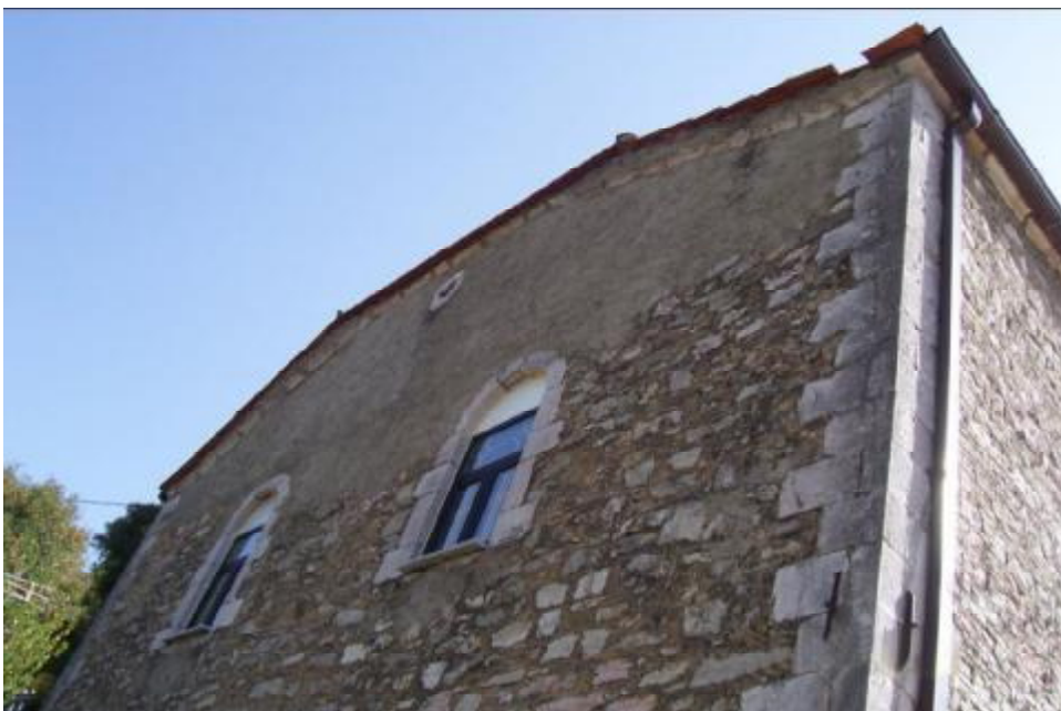
Εικόνα 12 Άποψη δυτικής όψης πριν την αποκατάσταση
