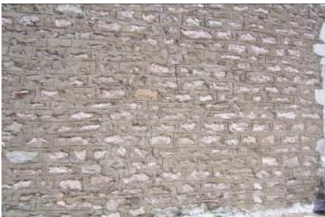
Εικόνα 57 Λεπτομέρεια αρμολογήματος πριν
