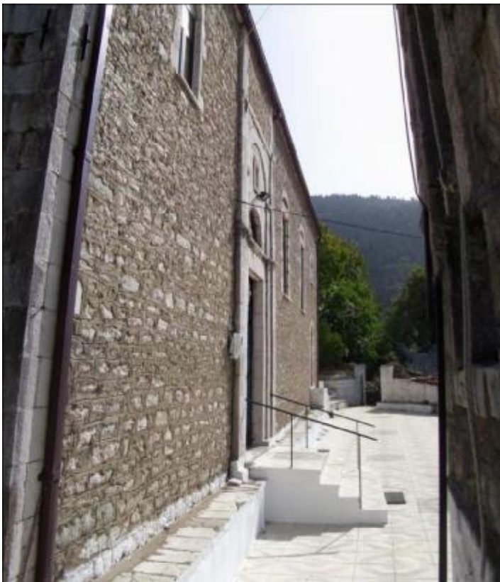
Εικόνα 11 Άποψη νότιας όψης πριν την αποκατάσταση
