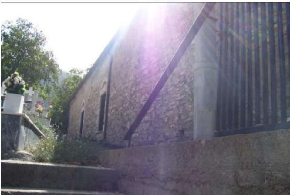
Εικόνα 14 Άποψη βόρειας όψης πριν την αποκατάσταση
