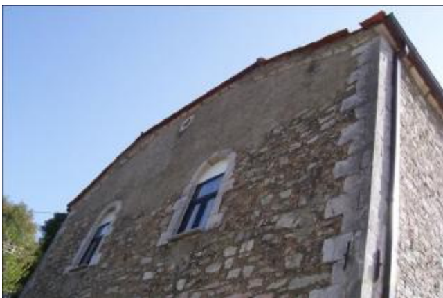
Εικόνα 52 Δυτική όψη πριν
