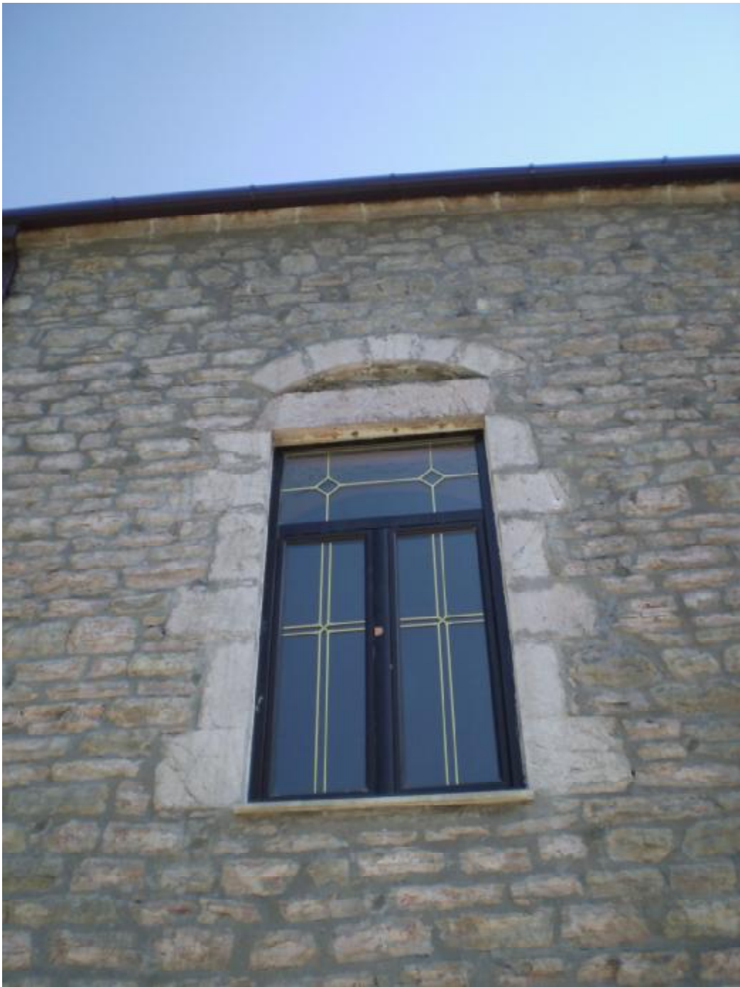
Εικόνα 61 Λεπτομέρεια αποκατάστασης περιμετρικά του ανοίγματος που είχε υποστεί διαμπερή ρωγμή
