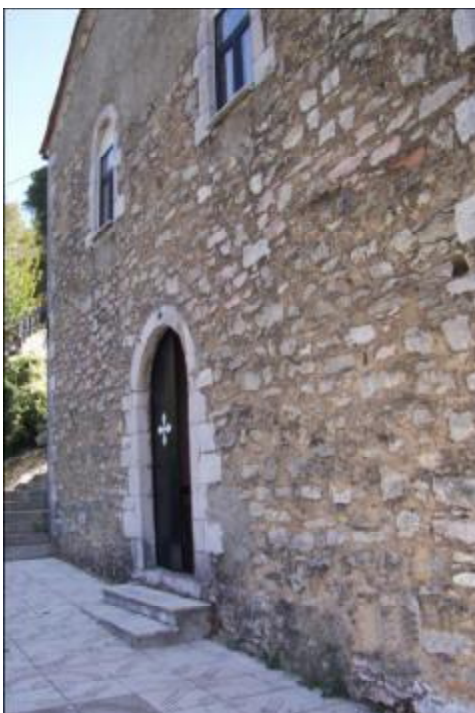
Εικόνα 13 Άποψη δυτικής όψης πριν την αποκατάσταση
