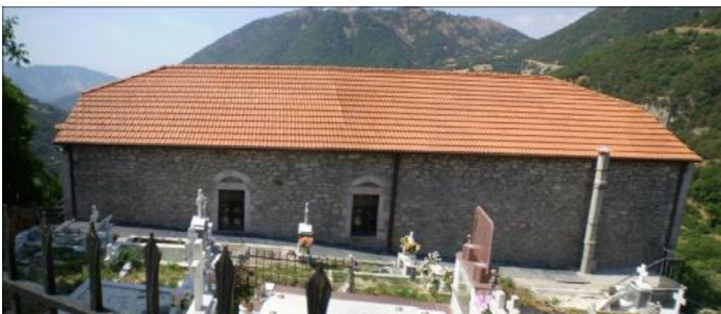
Εικόνα 50 Βόρεια όψη μετά
