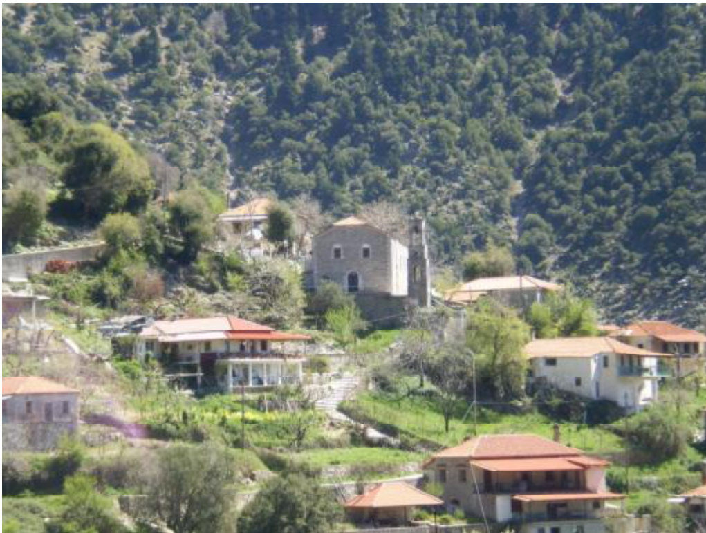
Εικόνα 8 Μακρινή άποψη της δυτικής πλευράς του Ιερού Ναού Αγίας Μαρίας και του καμπαναριού, μετά την αποκατάσταση
