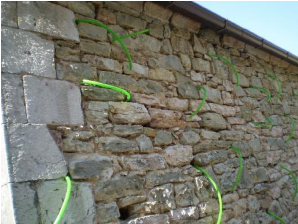
Εικόνα 38 Κάνναβος ενεμάτων στην βόρεια όψη
