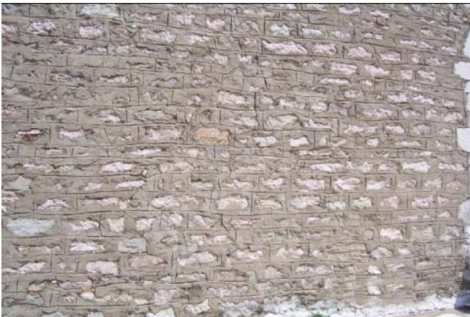
Εικόνα 17 Λεπτομέρεια αρμολογήματος πριν τις εργασίες αποκατάστασης
