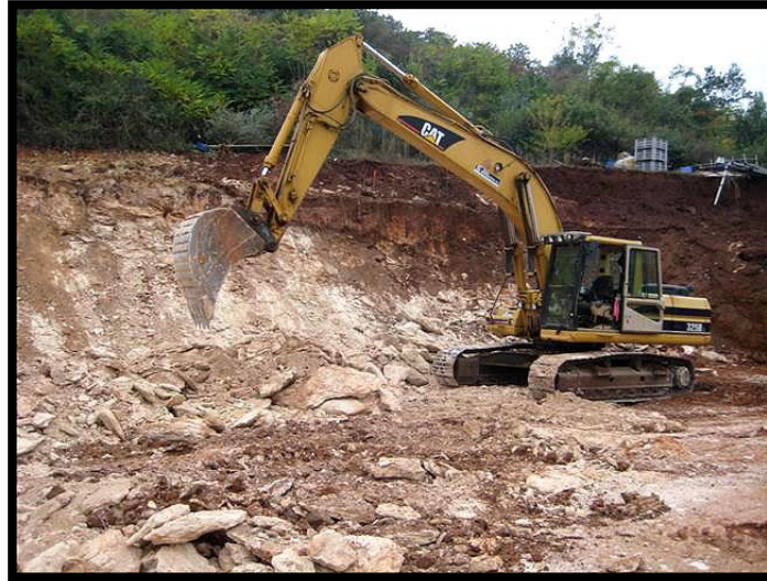
Εικόνα 1.4 : Στάδιο εκσκαφής πριν την κατασκευή
