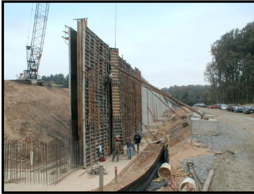
Εικόνα 1.6 : Τοποθέτηση ξυλότυπου και οπλισμού από το συνεργείο
