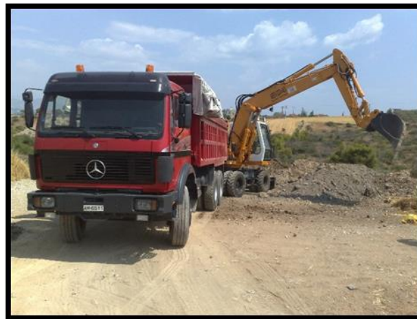
Εικόνα 1.5 : Εναπόθεση υλικών εκσκαφής σε φορτηγό όχημα για τη μεταφορά τους στην κατάλληλη θέση
