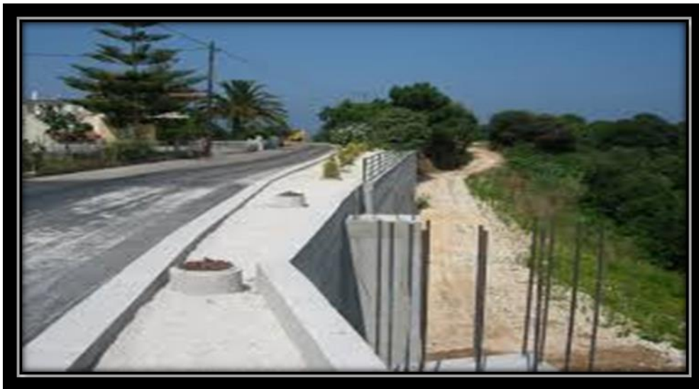
Εικόνα 1.1 : Τοίχος αντιστήριξης που υποστηρίζει επίχωμα από οδόστρωμα.
