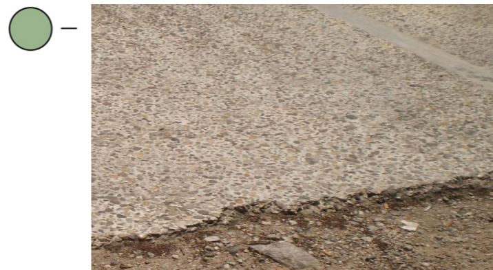
Εγκιβωτισμένες βοτσαλωτές πλάκες με σκυρόδεμα
