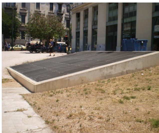
Εικόνα 3.9. Εγκατάσταση του μετρό
