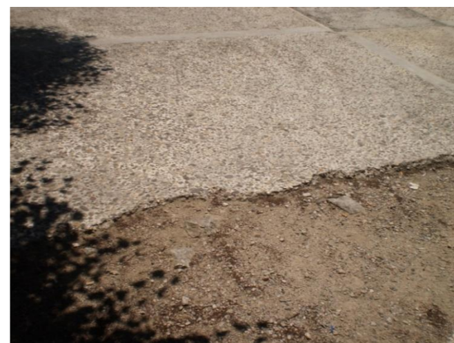
Εικόνα 3.25 – Εγκιβωτισμένες βοτσαλωτές πλάκες με σκυρόδεμα
