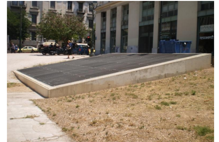
Εικόνα 3.18 – Κατασκευή του μετρό Σκυρόδεμα-μέταλλο
